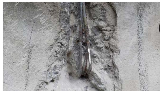
*Espulsione di copriferro ed armature ossidate*
