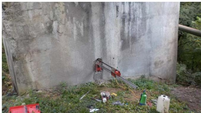
*Esecuzione di carotaggio su pila in c.a.*
