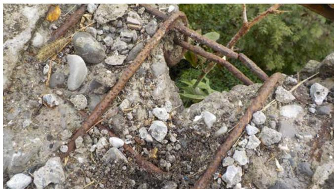
*Espulsione di copriferro ed armature ossidate*
