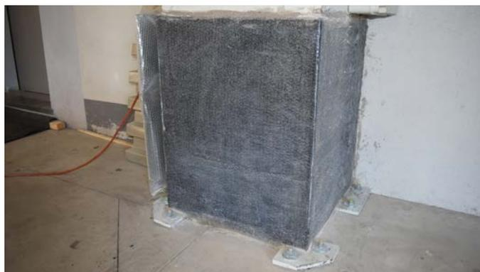
*Rinforzo di pilastri prefabbricati esistenti tramite fasciatura*
