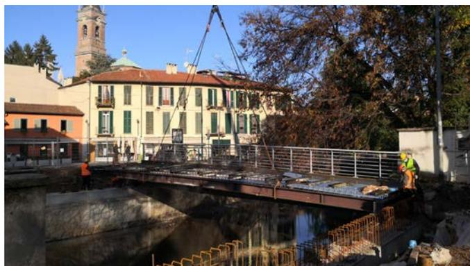
*Posa della struttura portante del nuovo ponte*
