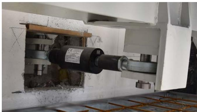
*Messa in opera di accoppiatori idraulici antisismici*
