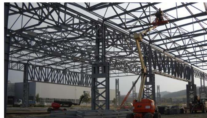
*Realizzazione della struttura in carpenteria metallica*
