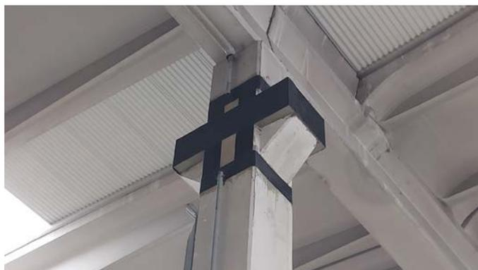
*Placcaggio del nodo trave-pilastro*
