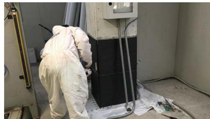
*Rinforzo di pilastri prefabbricati esistenti tramite fasciatura*
