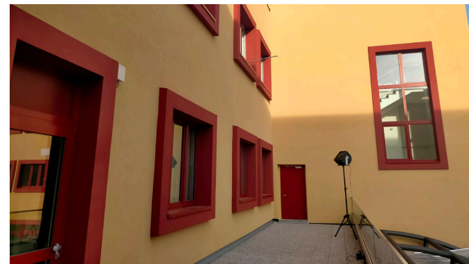
Misura del potere fonoisolante di facciata
