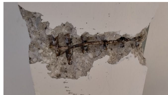
Saggio per indagare le armature su pilastro
