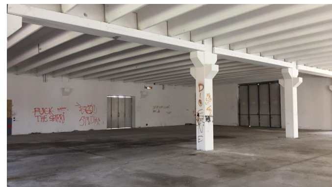
Vista interna dell'immobile
