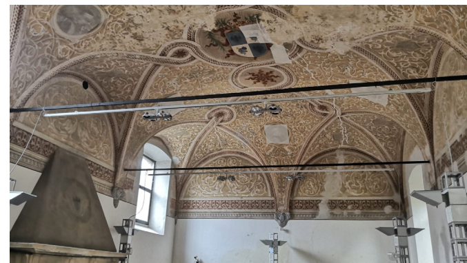
Vista interna dell'edificio allo stato di fatto
