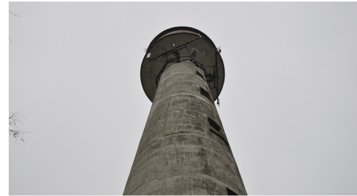
Vista del fusto della torre piezometrica
