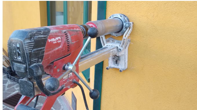
Esecuzione di carotaggio su elemento in c.a.
