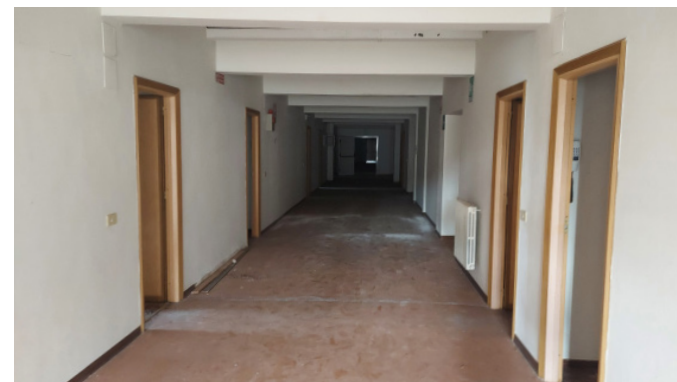
Vista interna dell'immobile allo stato di fatto
