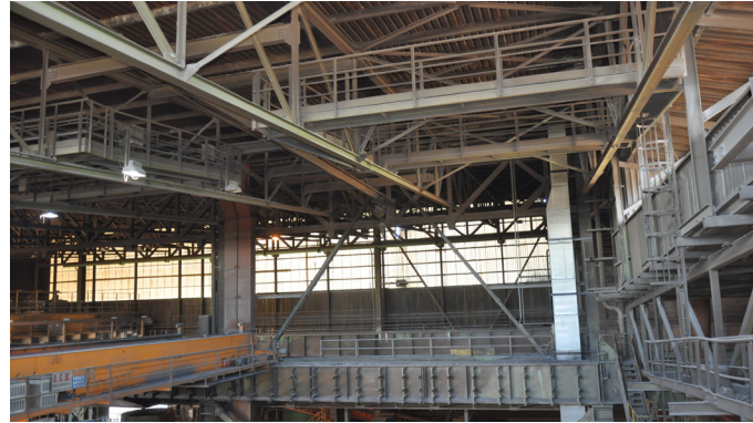
Vista interna dell'immobile
