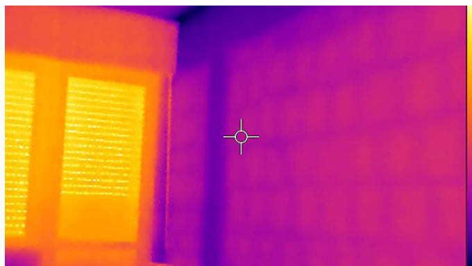
Termocamera per rilievo della struttura portante
