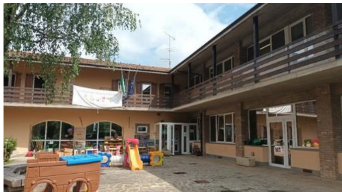
Vista esterna della scuola materna
