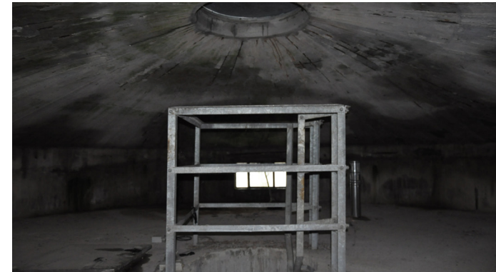
Vista interna al serbatoio della torre piezometrica
