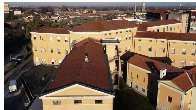
Immagini da drone del complesso ospedaliero
