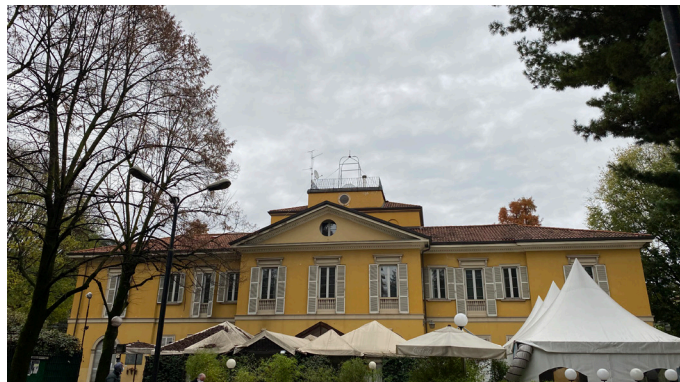
Vista esterna dell'immobile
