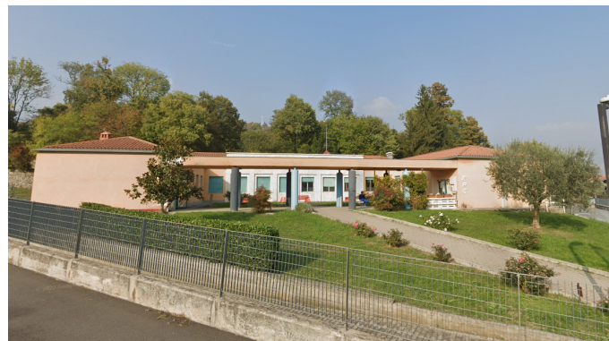
Vista esterna dell'edificio allo stato di fatto
