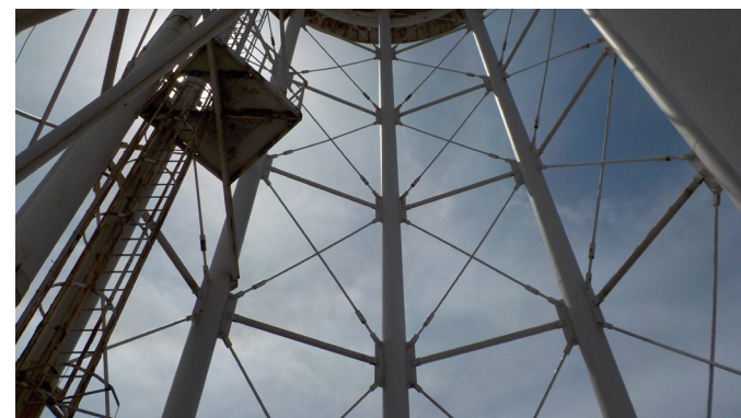
Vista esterna della torre piezometrica
