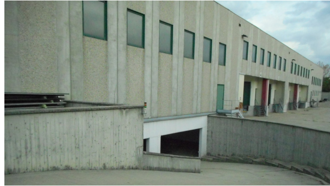
Vista esterna del complesso industriale
