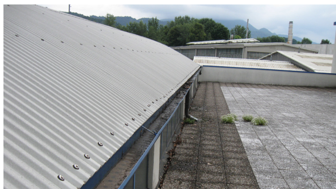
Vista della copertura dell'immobile
