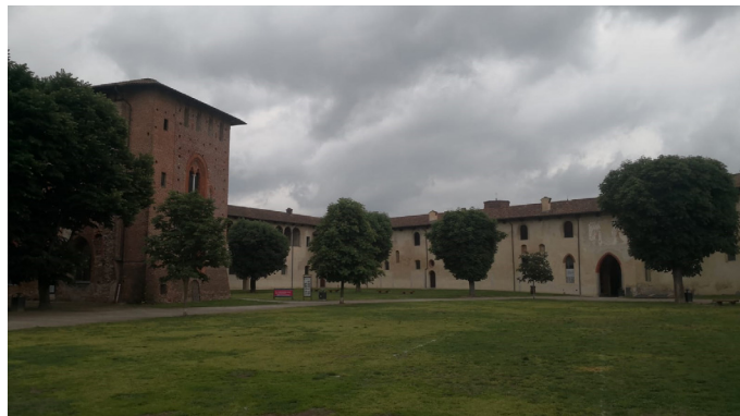
Vista esterna dell'edificio allo stato di fatto
