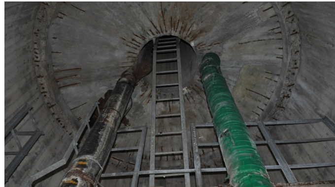
Vista dell'intradosso del serbatoio della torre piezometrica
