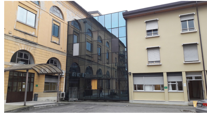
Vista esterna dell'immobile - ala moderna
