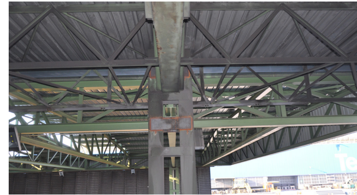
Vista interna dell'immobile
