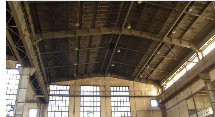
Vista interna dell'immobile
