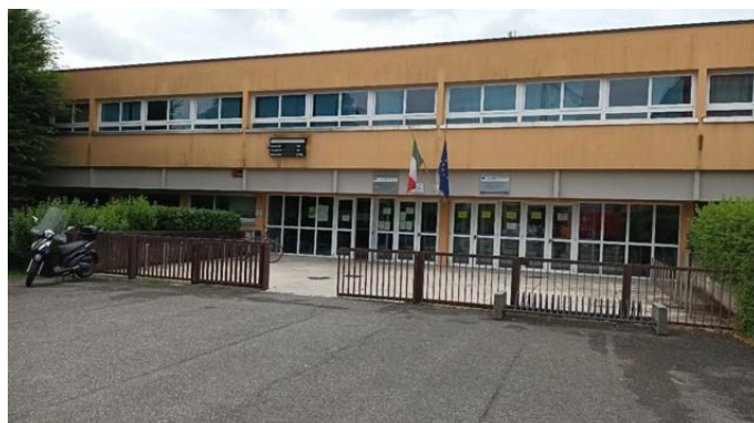
Vista esterna della scuola secondaria
