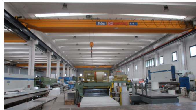
Vista interna dell'immobile
