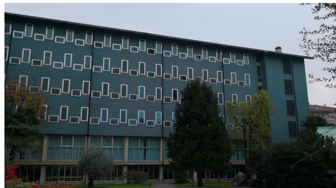
Vista esterna dell'immobile - Palazzina Comando
