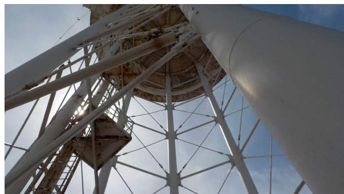
Vista esterna della torre piezometrica
