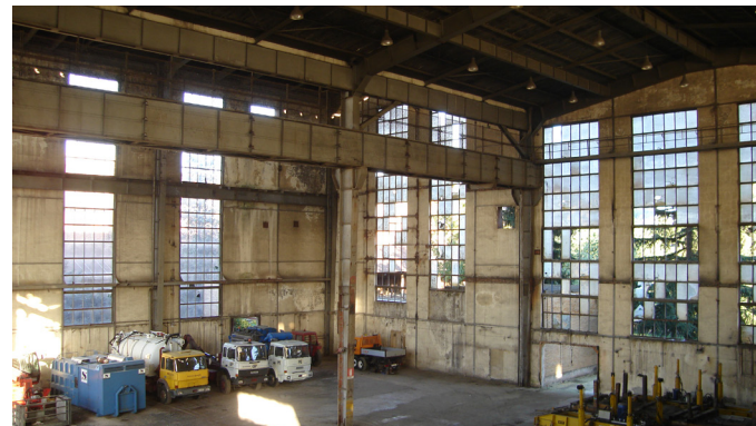
Vista interna dell'immobile
