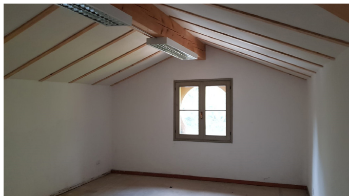
Vista interna dell'immobile
