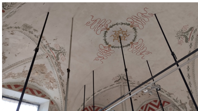
Sensori per l'esecuzione di prova di carico statica
