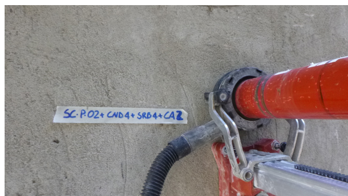
Carotaggio per caratterizzazione del calcestruzzo
