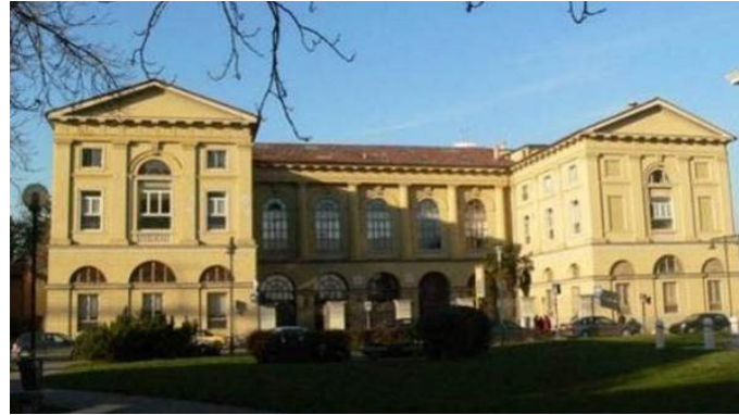
Vista esterna dell'immobile - ala storica
