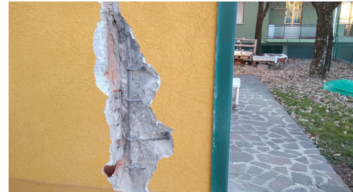
Saggio per indagare le armature su pilastro
