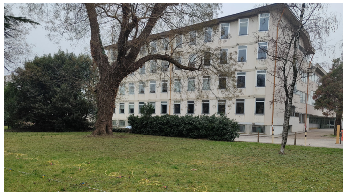
Vista esterna dell'Istituto Percoto
