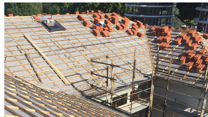
Rifacimento della copertura
