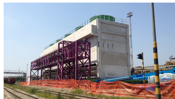
Vista dell'impianto ad intervento ultimato
