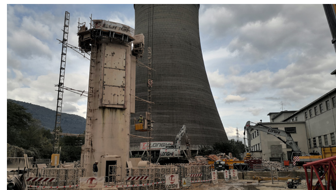
Opere di demolizione della base della ciminiera
