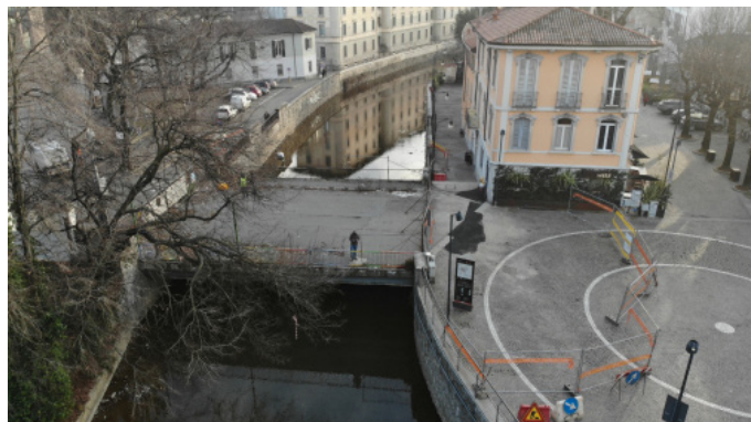
Vista da drone del ponte ante demolizione
