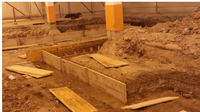
Vista interna del capannone ante intervento
