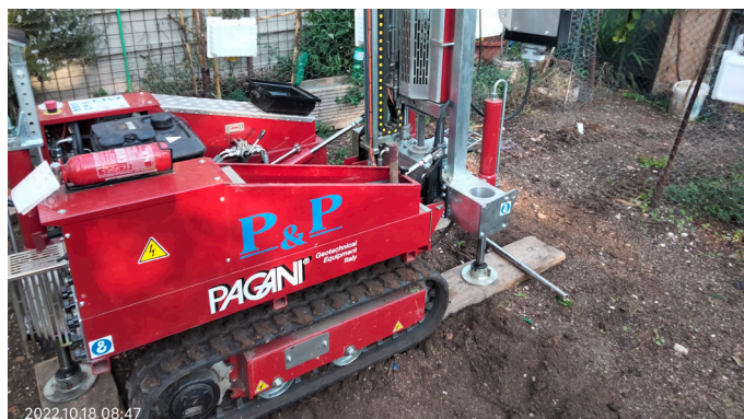
Esecuzione di indagini geognostiche
