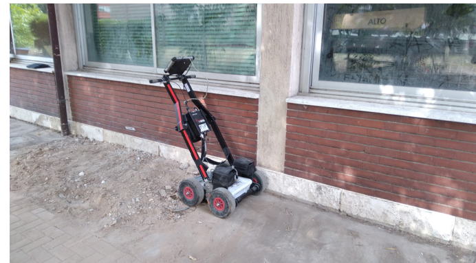
Esecuzione di indagine georadar
