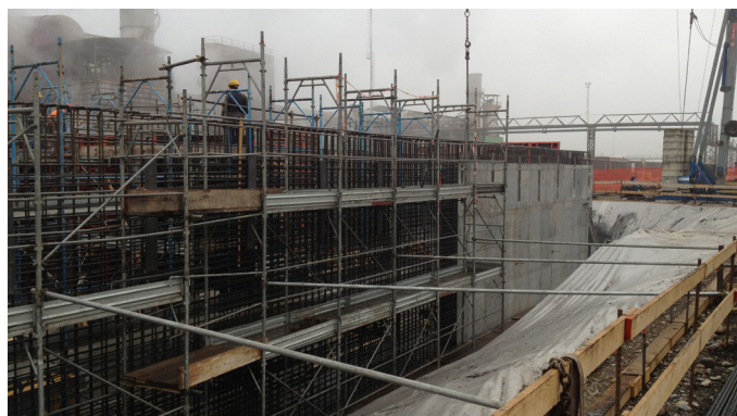
Realizzazione delle pareti verticali in c.a.
