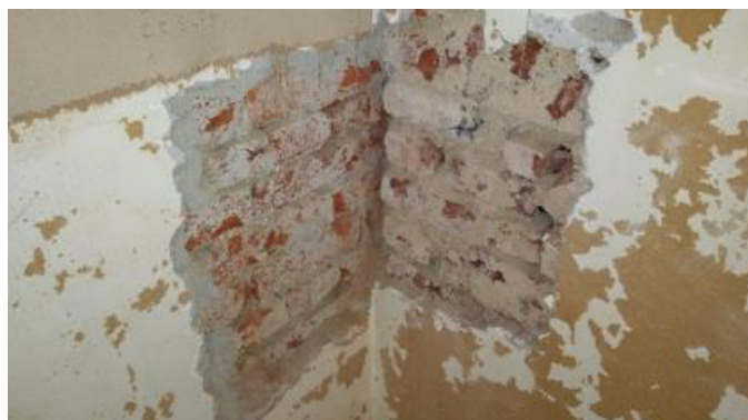
Verifica dell'ammorsamento tra le murature
