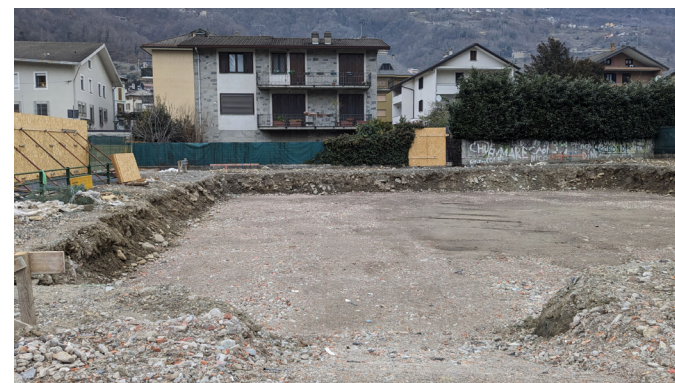
Direzione Lavori dell'attività di scavo
