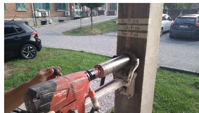
Carotaggio per valutazione della resistenza del calcestruzzo
