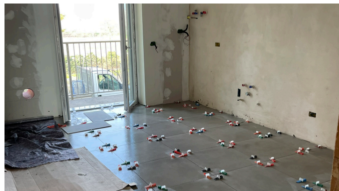
Direzione lavori delle opere edili interne
