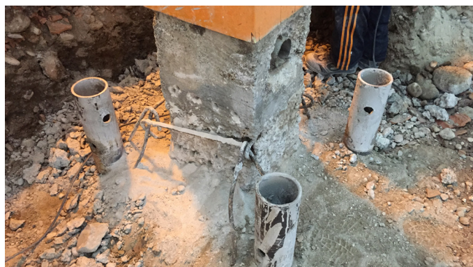
Posizionamento di micropali attorno ad un pilastro esistente
