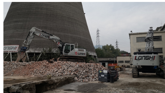
Stato dei luoghi a demolizione ultimata
