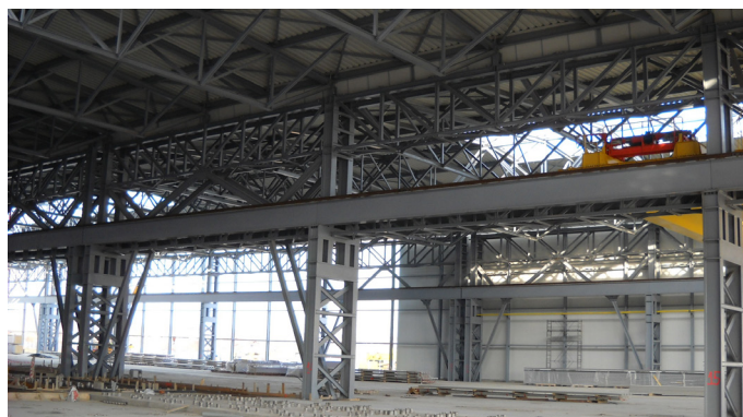
Realizzazione avanzata della struttura in carpenteria metallica
