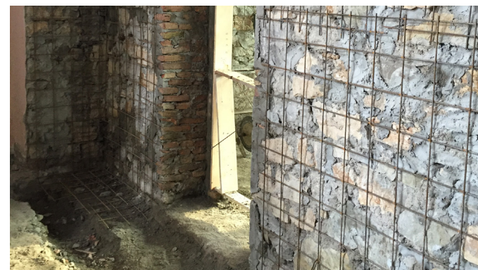
Intonaco armato sulle pareti in muratura del complesso
