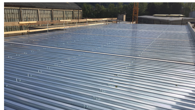
Vista estradossale del nuovo solaio in lamiera grecata
