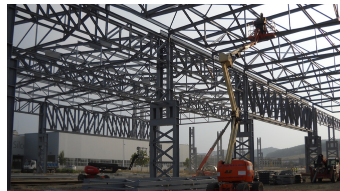
Realizzazione della struttura in carpenteria metallica
