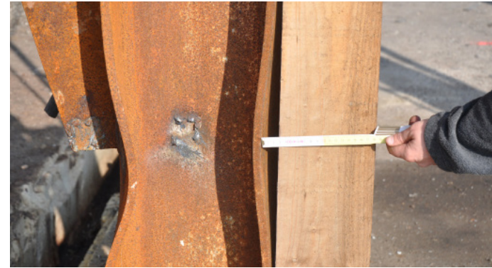
Rilievo dei dissesti
