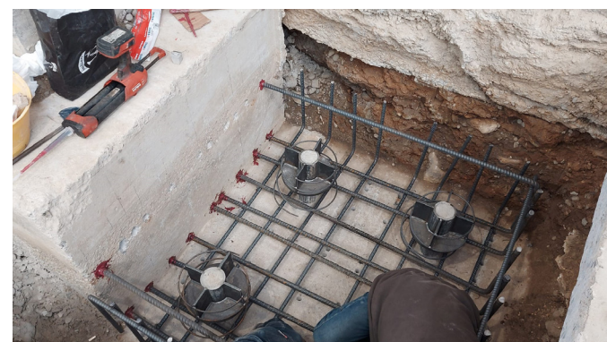
Esecuzione del rinforzo fondazionale del plinto
