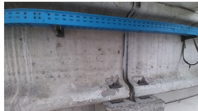
Dissesti sull'appoggio delle travi riconducibili al cedimento
