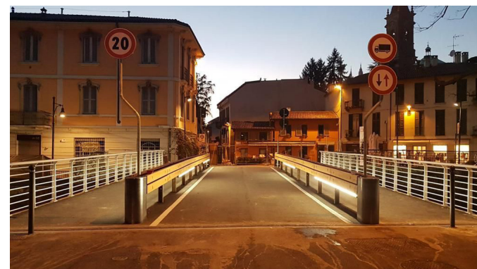
Vista del ponte post intervento
