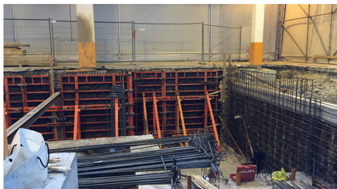
Messa in sicurezza degli scavi per la vasca
