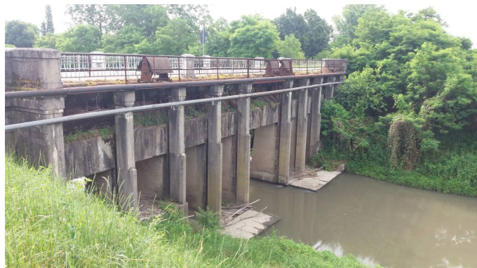
Vista del ponte n.1
