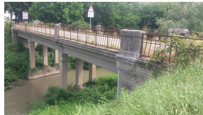
Vista del ponte n.4
