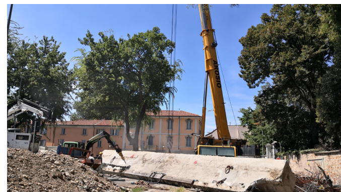
Opere di demolizione del ponte esistente
