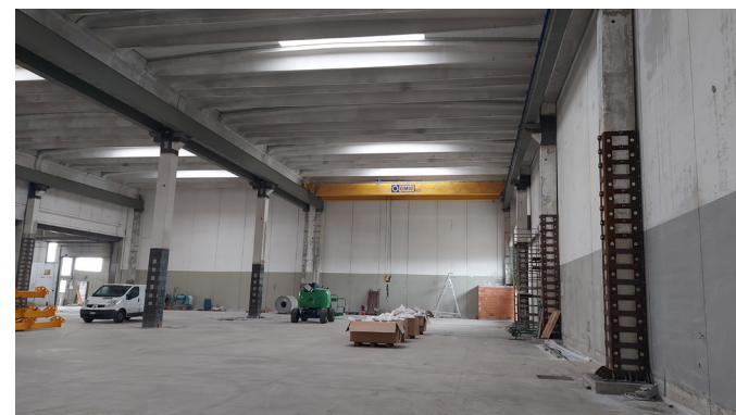
Stato dei luoghi ad intervento ultimato
