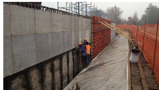
Realizzazione delle pareti verticali in c.a.
