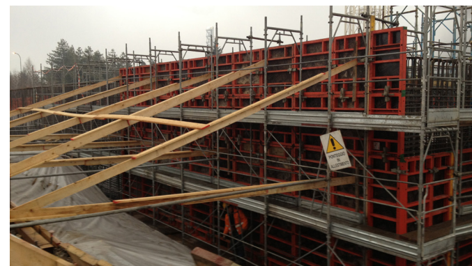
Casseratura delle pareti della vasca
