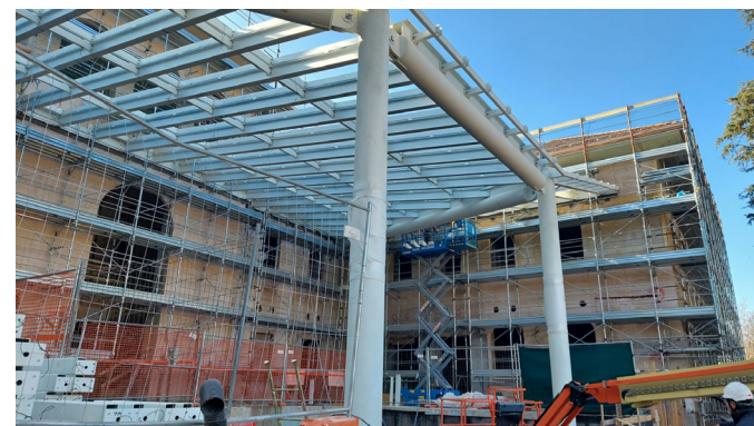
Posa delle carpenterie metalliche della corte vetrata
