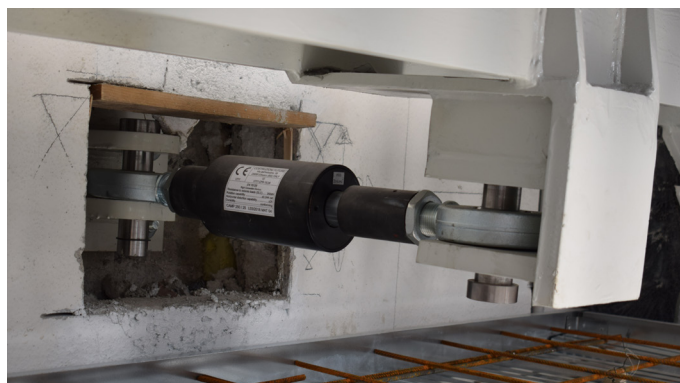
Messa in opera di accoppiatori idraulici antisismici
