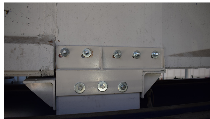
Rinforzo del collegamento tra trave e pilastro
