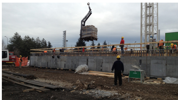
Opere di ultimazione della copertura della vasca
