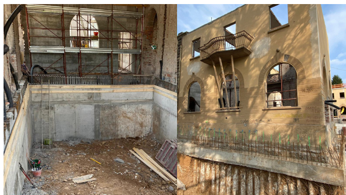
Opere di sottomurazione e di rinforzo fondazionale
