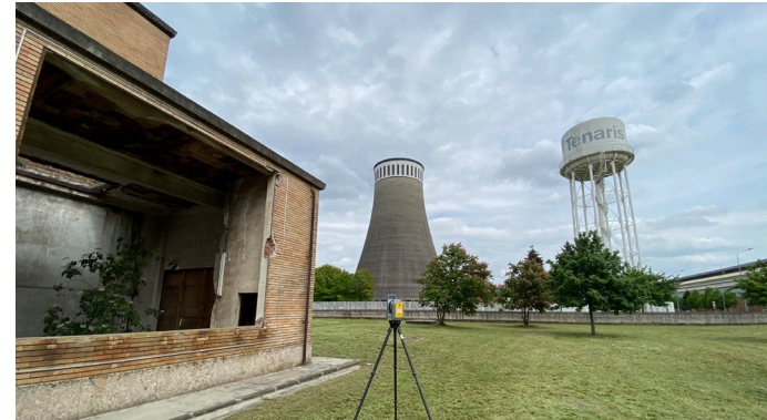
Operazioni di rilievo con Laser Scanner
