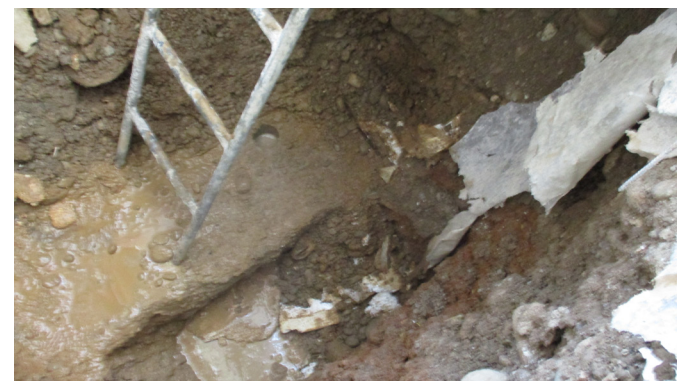
Saggio in fondazione alla base del pilastro
