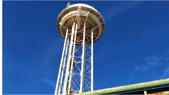
Vista del serbatoio pensile
