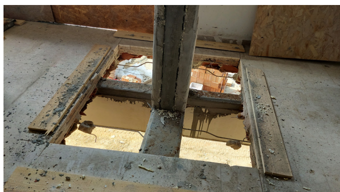
Rinforzo di travi e pilastri esistenti
