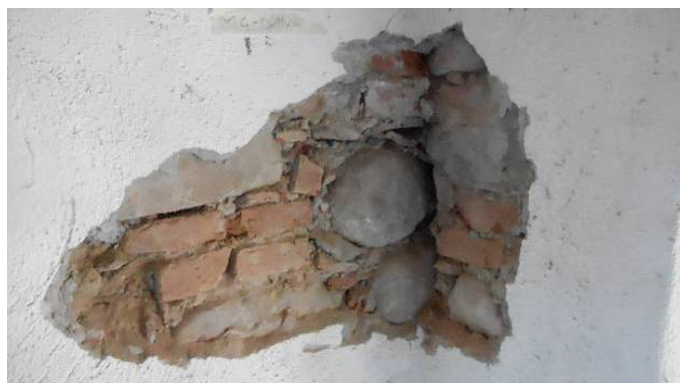
Saggi murari per la valutazione degli ammorsamenti
