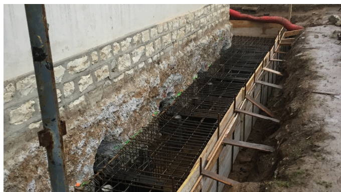
Armatura con cordolo in c.a.
