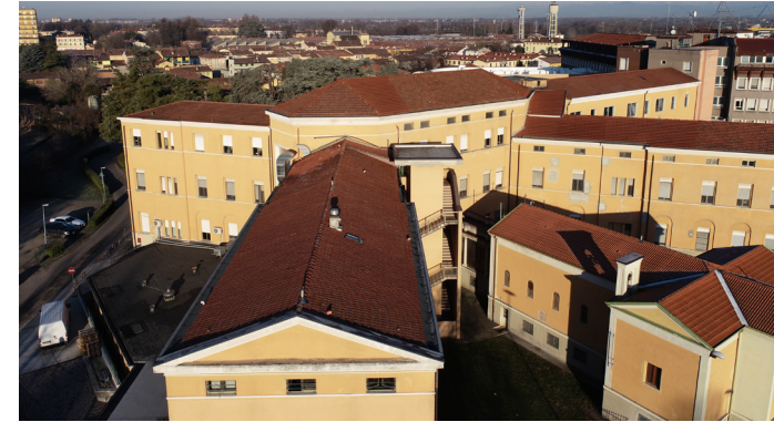
Immagini da drone del complesso ospedaliero
