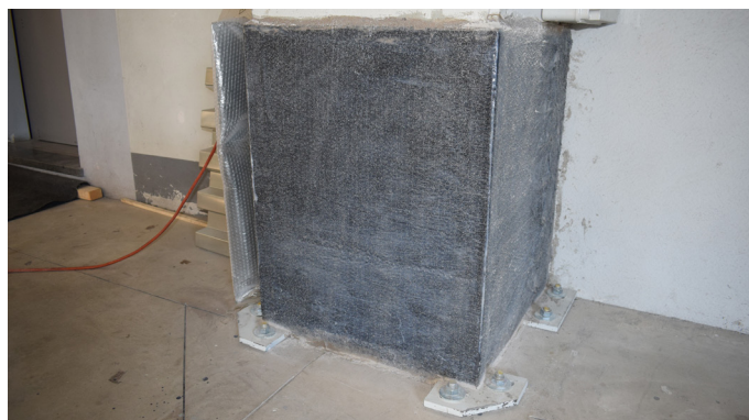
Rinforzo di pilastri prefabbricati esistenti tramite fasciatura
