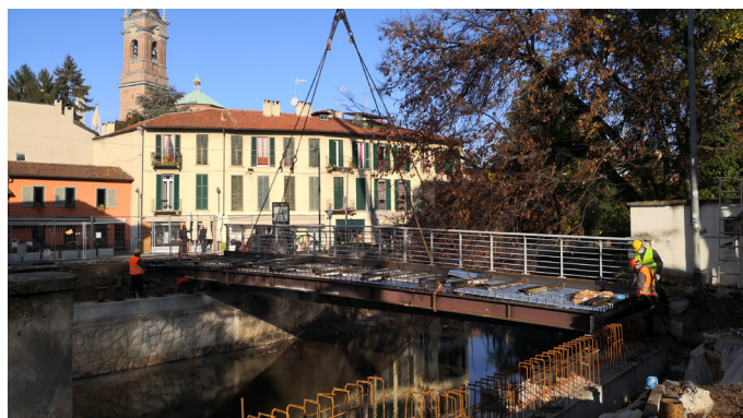
Posa della struttura portante del nuovo ponte
