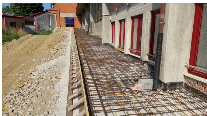
Getto del cordolo in c.a. di rinforzo alle fondazioni
