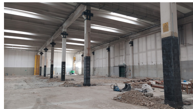
Placcaggio dei pilastri in c.a. esistenti
