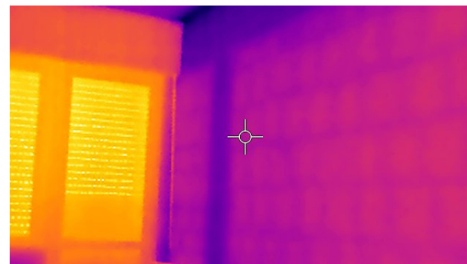
Termocamera per rilievo della struttura portante
