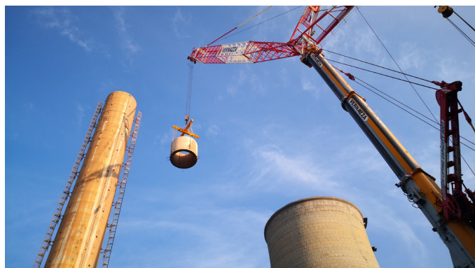
Demolizioni a conchi della ciminiera tramite gru
