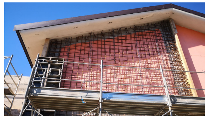
Nuovo setto di in.c.a. di rinforzo alla parete esistente
