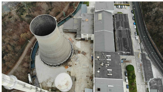
Vista da drone della centrale ante demolizione
