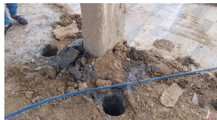
Realizzazione di nuovi micropali di fondazione
