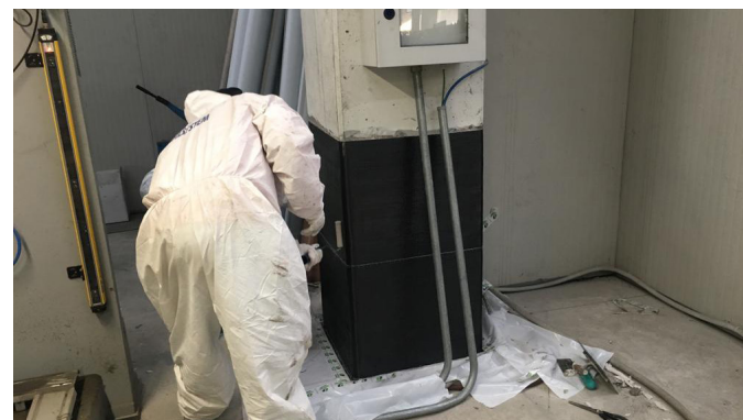
Rinforzo di pilastri prefabbricati esistenti tramite fasciatura
