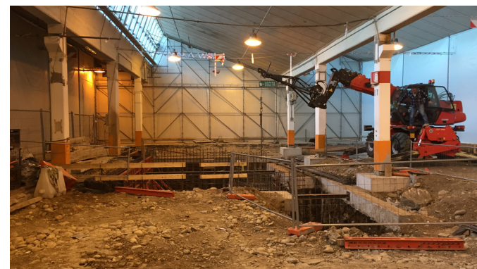
Realizzazione in corso d'opera di vasca interrata
