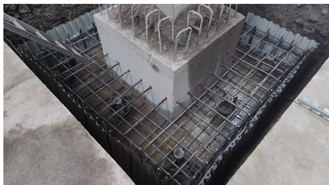
Ringrosso fondazionale con micropali e cordolo in c.a.
