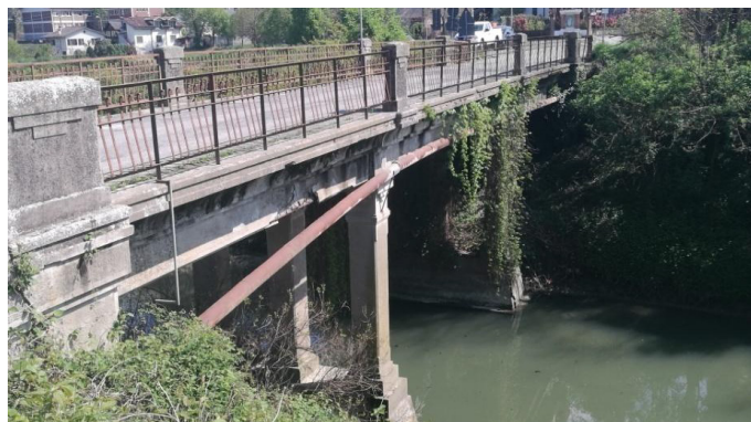
Vista del ponte n.3 allo stato di fatto
