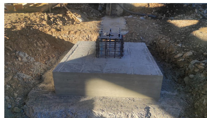
Nuovo plinto dopo la fase di getto
