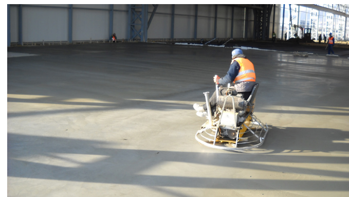
Lisciatura della pavimentazione in calcestruzzo
