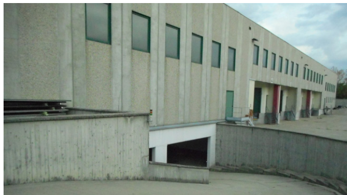
Vista esterna del complesso industriale
