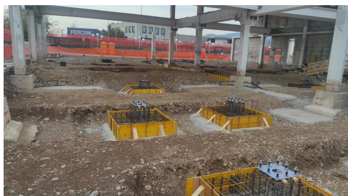
Armatura dei nuovi plinti
