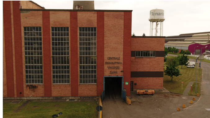
Vista della facciata principale della centrale
