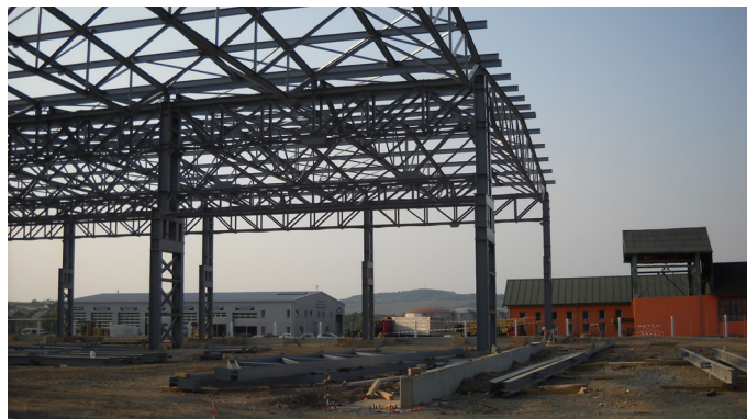
Realizzazione della struttura in carpenteria metallica
