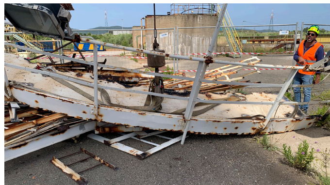
Attività di DL per demolizione della passerella
