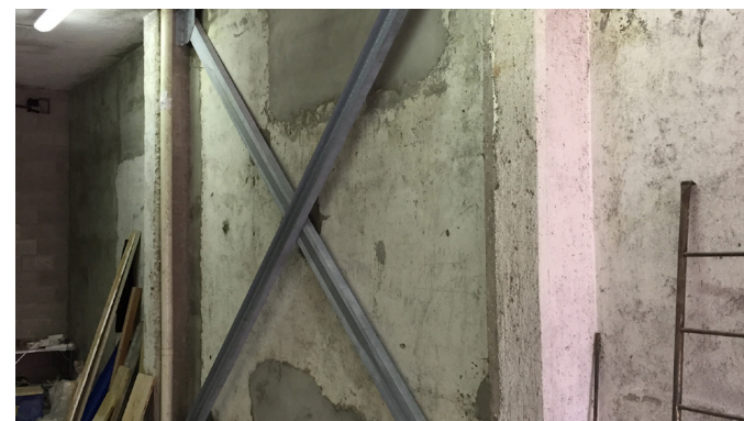
Nuovi controventi di rinforzo
