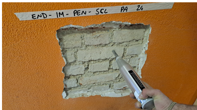
Prova penetrometrica sui giunti di malta
