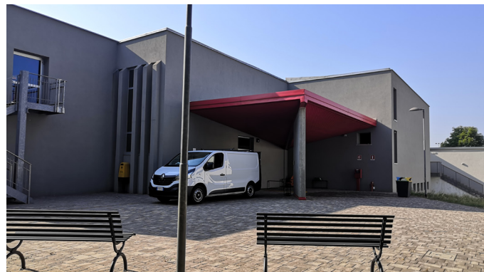
Vista esterna dell'immobile allo stato di fatto
