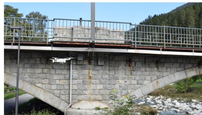
*Rilievo fotogrammetrico di manufatto stradale*
