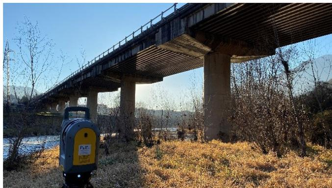
*Operazione di rilievo con Laser Scanner*
