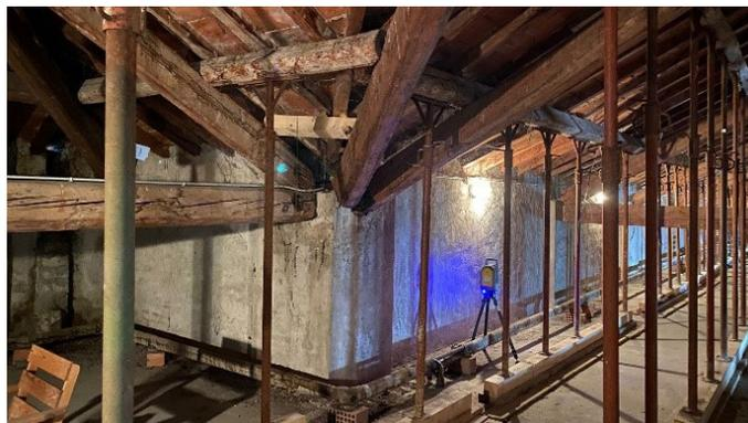
Operazione di rilievo con Laser Scanner
