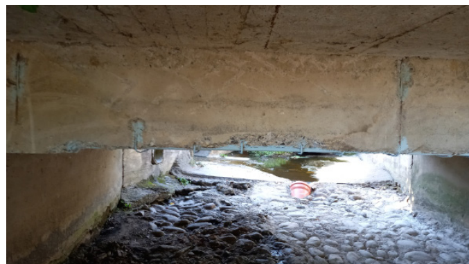
Opere di passivazione delle armature delle travi in c.a.
