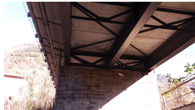
Vista intradossale dell'impalcato
