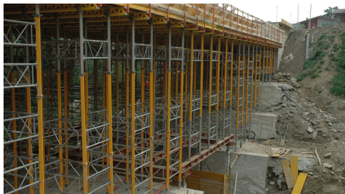
Opera di puntellazione per il getto
