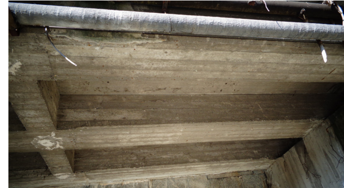
Vista intradossale del ponte
