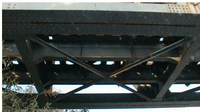
Struttura portante dell'impalcato
