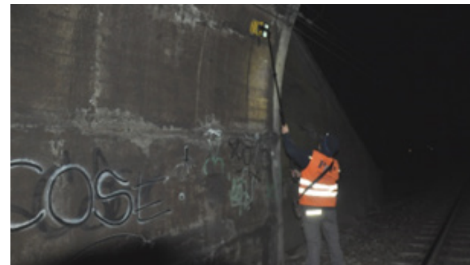
Esecuzione di indagine georadar
