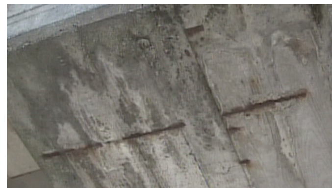
Barre a vista prima degli interventi
