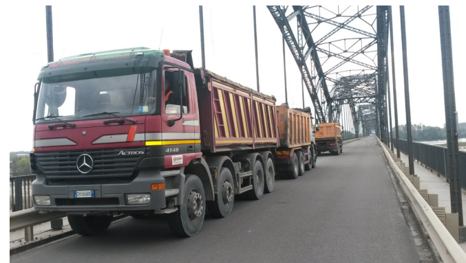
Prova di carico con autocarri
