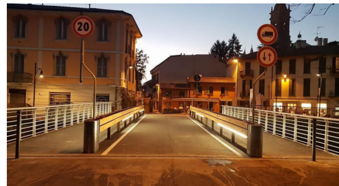
Nuovo ponte a lavori ultimati
