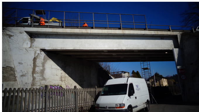
Vista d'insieme del ponte
