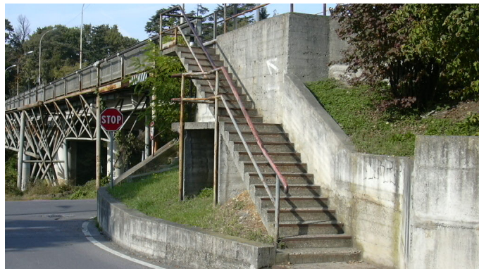
Vista del ponte
