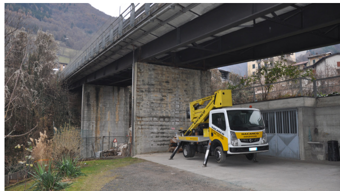
Vista d'insieme del ponte
