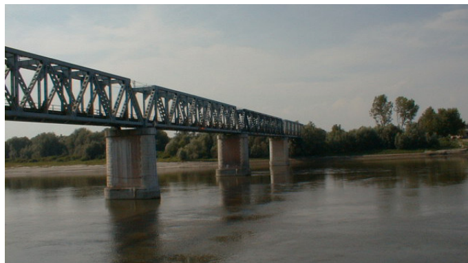
Vista d'insieme del ponte
