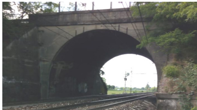
Vista del ponte dal sedime ferroviario
