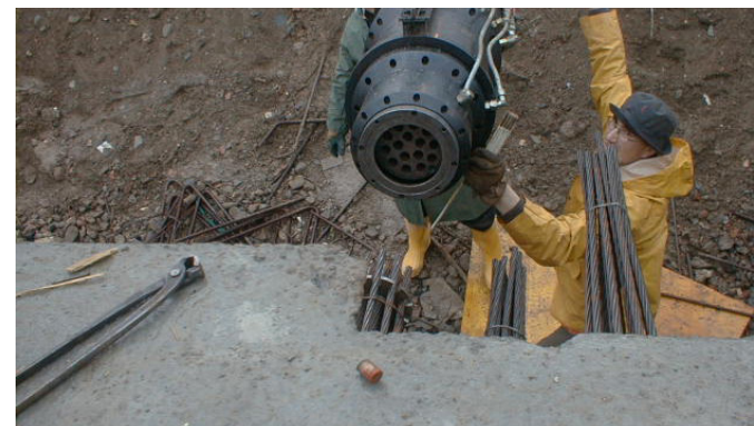
Messa in tensione dei trefoli
