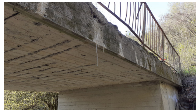
Vista dell'intradosso dell'impalcato
