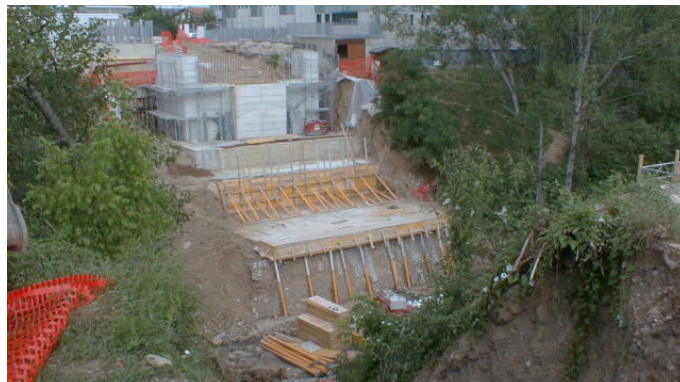
Realizzazione delle spalle
