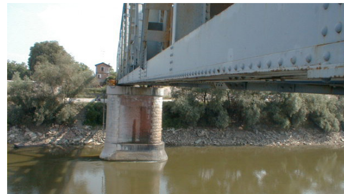
Vista di una pala oggetto di indagini
