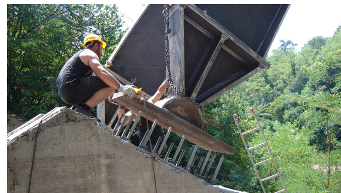
Fissaggio degli archi alla fondazione
