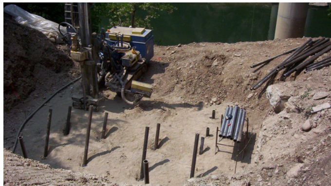
Infissione di micropali nel terreno
