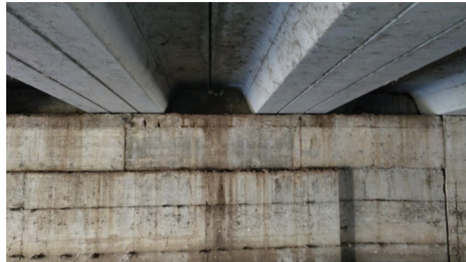
Vista di dettaglio delle travi prefabbricate
