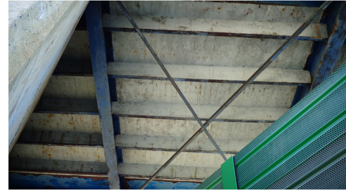
Vista intradossale del ponte
