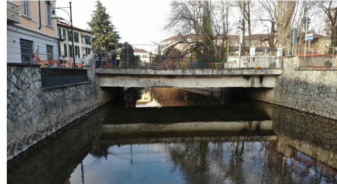
Vista da drone del ponte esistente
