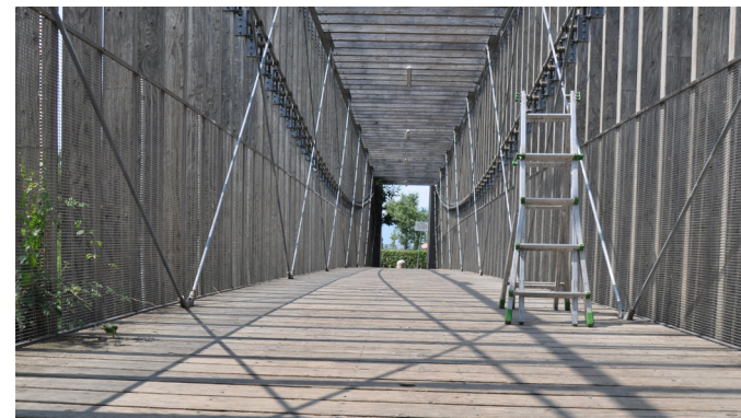
Vista dell'impalcato della passerella
