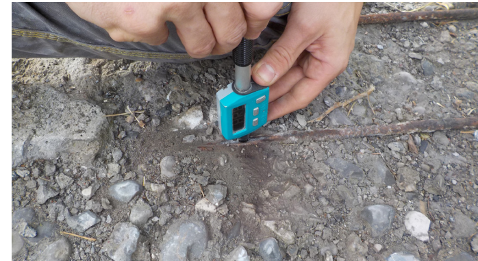
Prova con durometro su barra d'armatura
