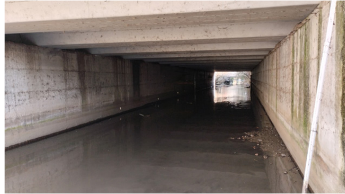
Vista dell'intradosso del ponte
