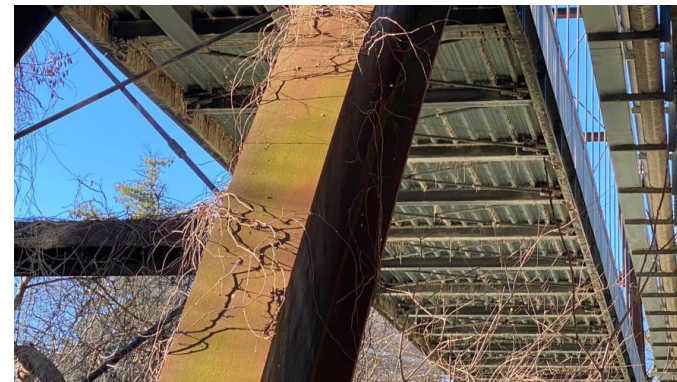
Vista dell'intradosso dell'impalcato
