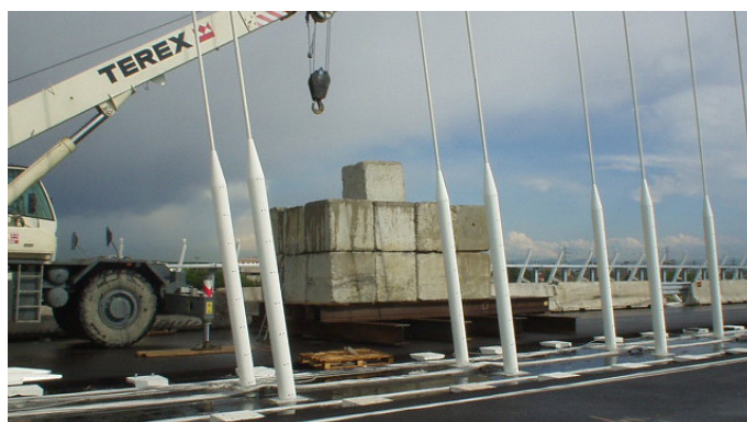
Prova di carico locale
