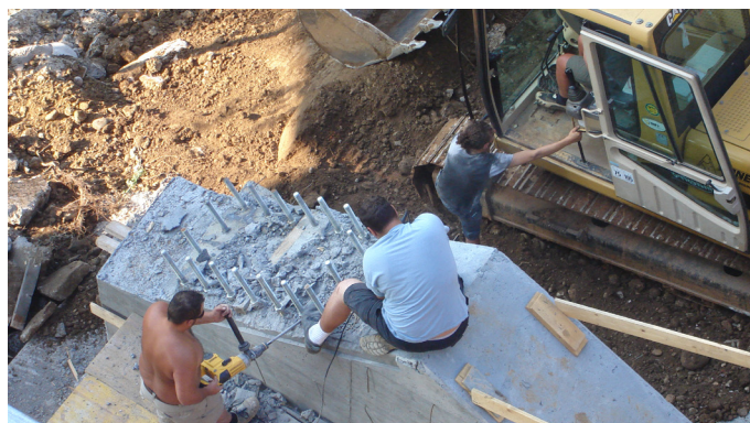
Posa della piastra di fissaggio degli archi
