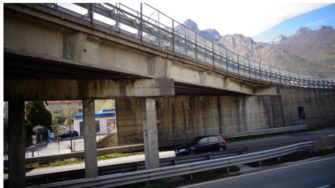
Vista d'insieme del ponte
