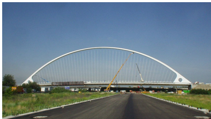
Vista d'insieme del ponte
