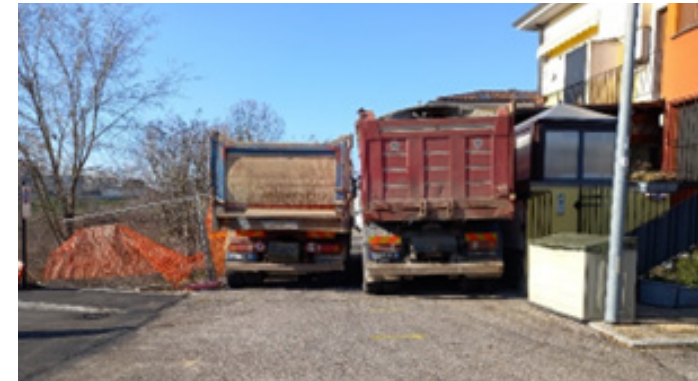
Prova di carico con automezzi sull'impalcato
