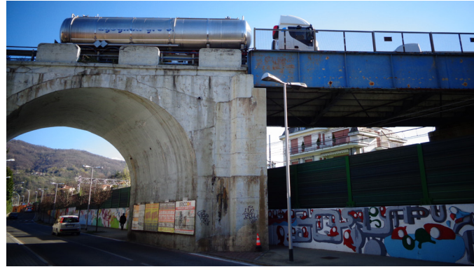
Vista d'insieme del ponte
