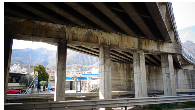
Vista intradossale del ponte
