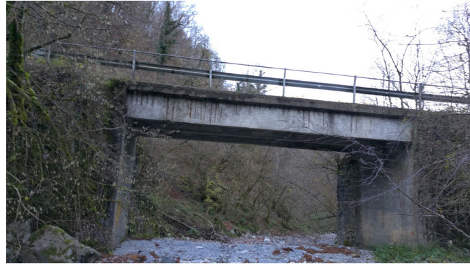
Vista d'insieme del ponte
