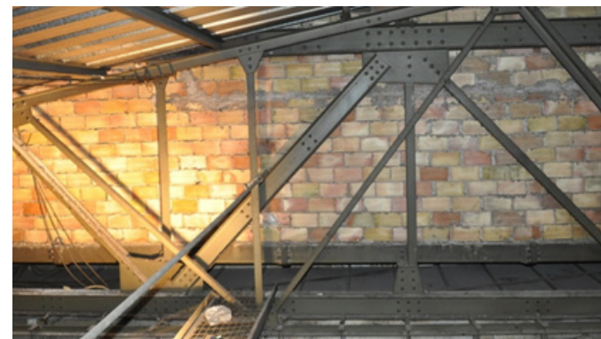
Vista della struttura della passerella lato ANAS
