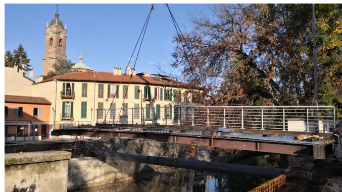
Posa del nuovo ponte
