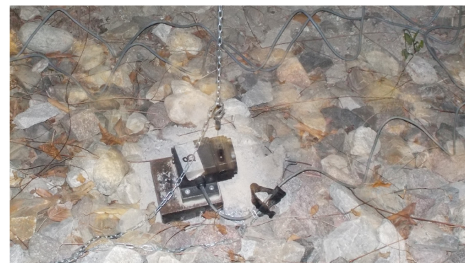
Strumenti di misura posizionati
