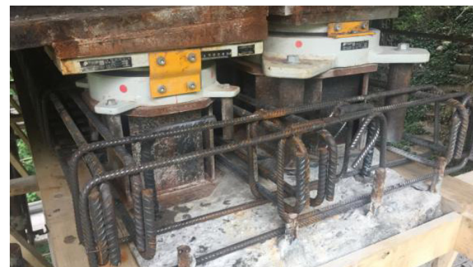
Realizzazione di nuovi baggioli
