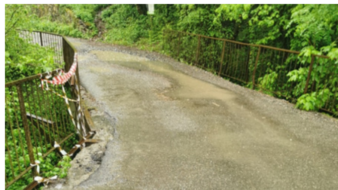
Vista dell'estradosso dell'impalcato
