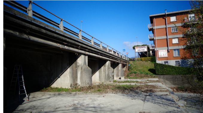
Vista d'insieme del ponte
