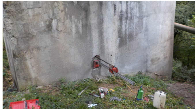
Esecuzione di carotaggio su pila in c.a.
