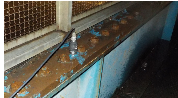
Strumenti di misura posizionati
