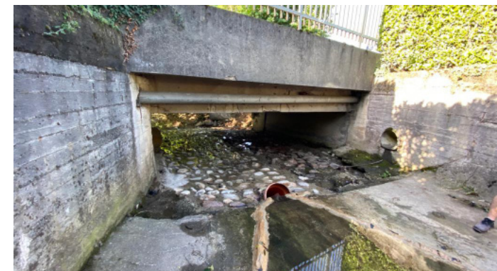
Intervento di ripristino del fondo dell'alveo
