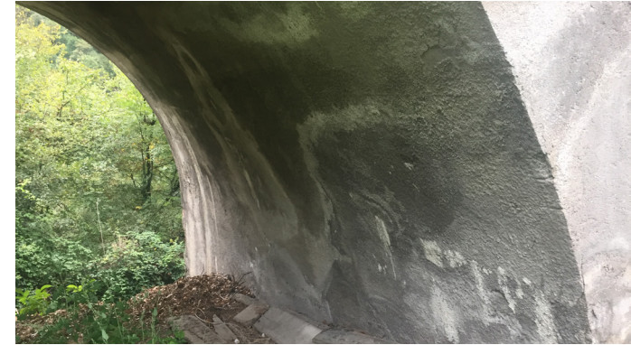
Vista intradossale di un'arcata del ponte
