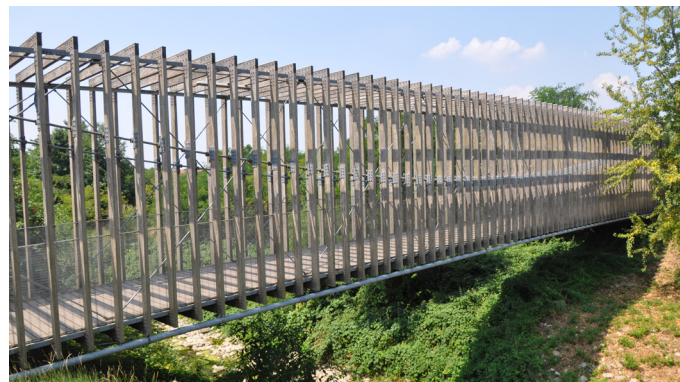
Vista d'insieme della passerella
