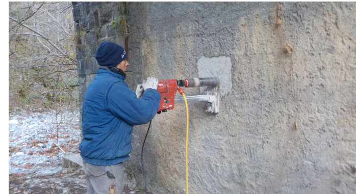
Esecuzione di carotaggio su spalla in c.a.
