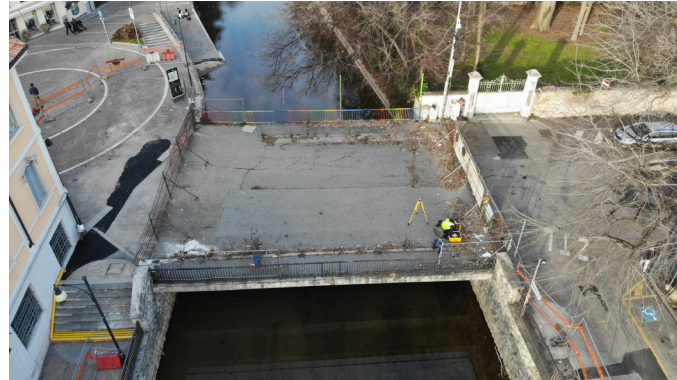
Vista da drone del ponte esistente
