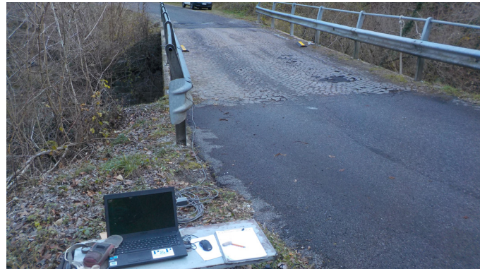
Esecuzione della prova dinamica
