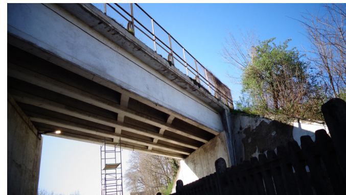
Vista intradossale del ponte
