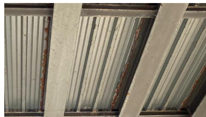
Rilievo del degrado della passerella metallica
