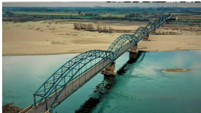
Vista d'insieme del ponte
