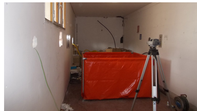
Esecuzione di prova di carico della passerella lato ANAS
