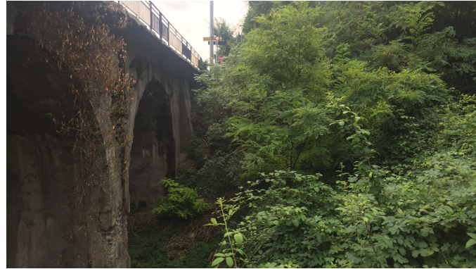
Vista d'insieme del ponte
