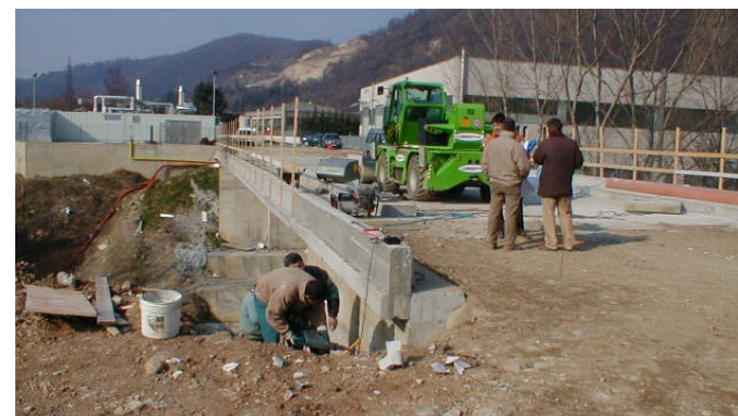
Ponte a lavori quasi ultimati
