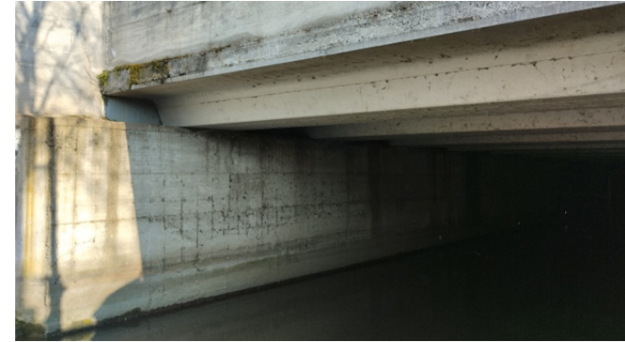
Vista di dettaglio della spalla
