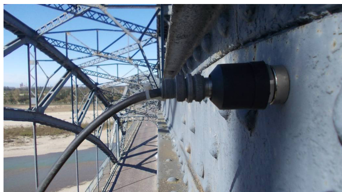
Dettaglio dell'accelerometro di misura su arco
