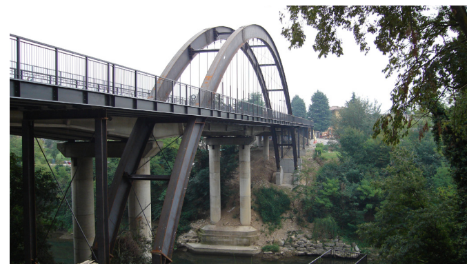
Passerella a lavori ultimati
