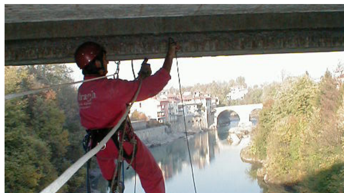
Esecuzione di una prova sinica
