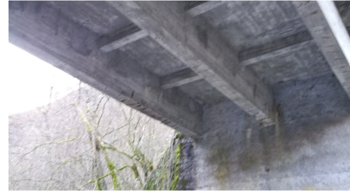
Vista intradossale del ponte
