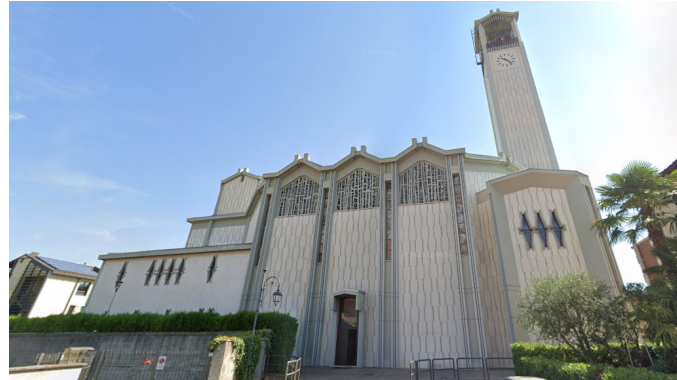
Vista degli esterni della chiesa oggetto di intervento
