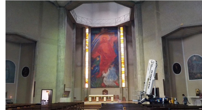
Ambienti interni della Chiesa oggetto di intervento
