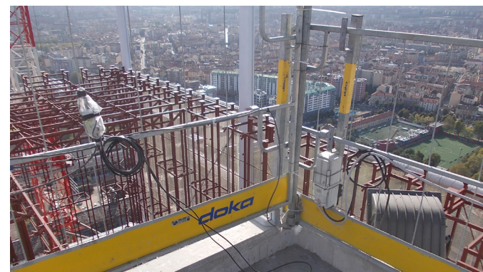
Posizione di accelerometro sulla copertura dell'edificio
