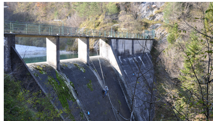
Istallazione delle accelerometri sulla diga
