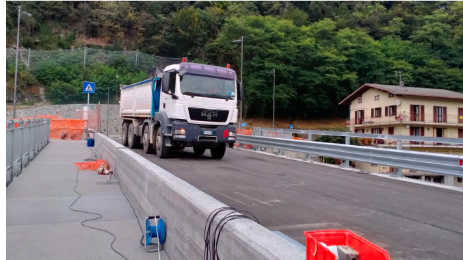
Vista del ponte durante prova dinamica con transito
