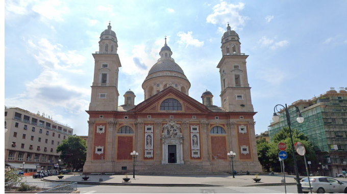
Vista esterna del fabbricato
