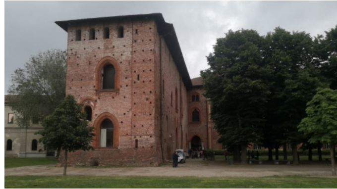
Vista esterna del fabbricato
