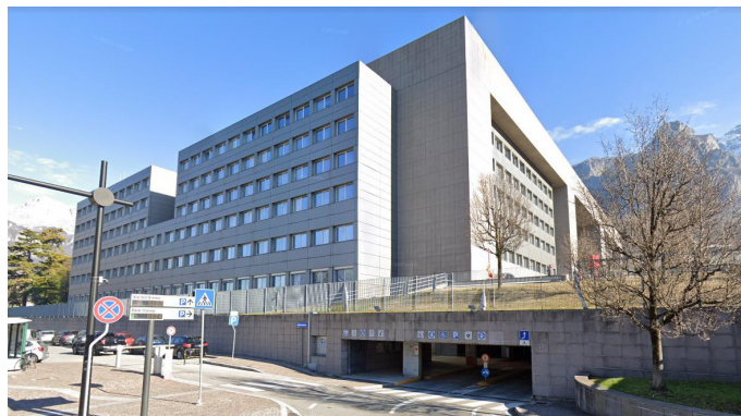
Vista esterna del fabbricato
