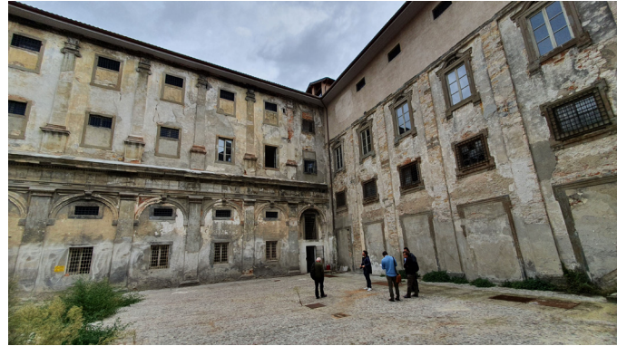
Vista esterna del fabbricato
