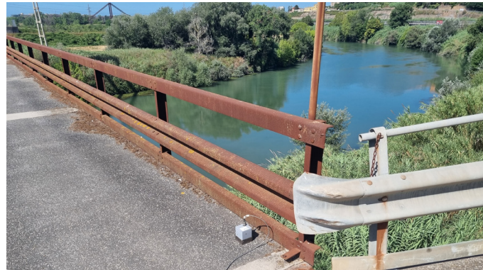
Posizione di accelerometro del ponte Magliana
