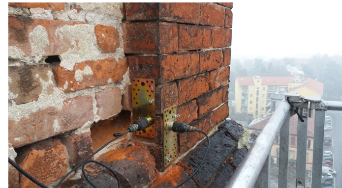
Posizione di accelerometro sulla torre
