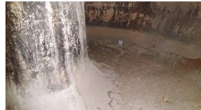
Terna accelerometrica all'interno del serbatoio
