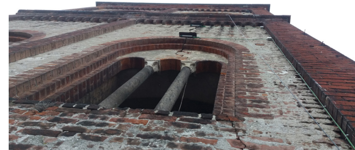
Posizione di accelerometro sulla torre
