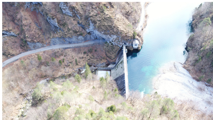
Vista dall'alto della diga
