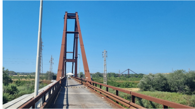
Vista del ponte Magliana
