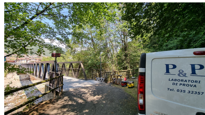
Viste della passerella ciclo-pedonale
