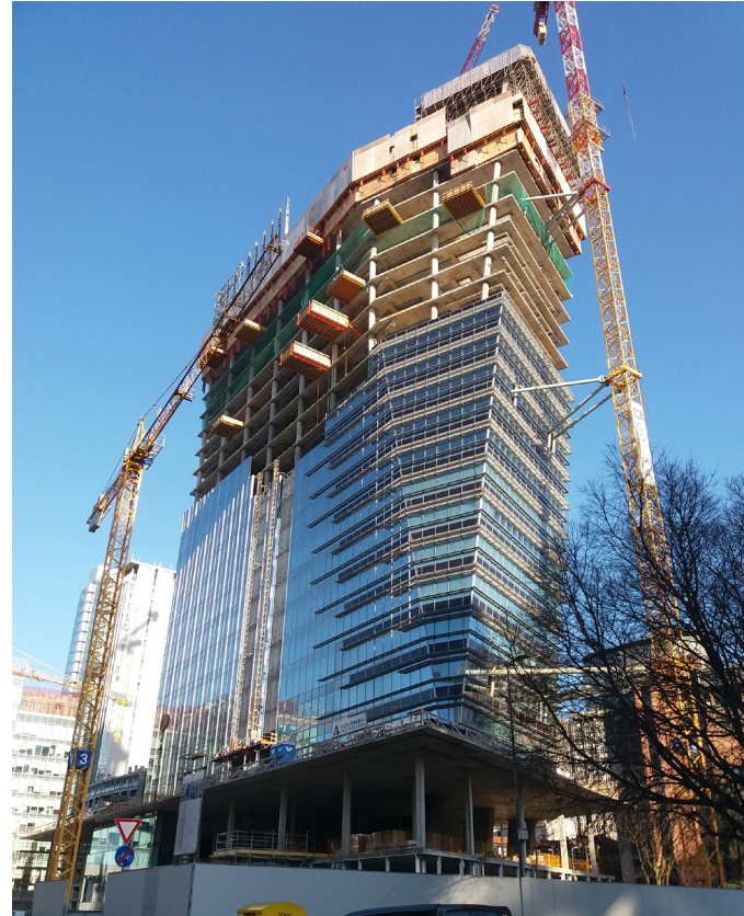
Vista dell'immobile in fase di costruzione
