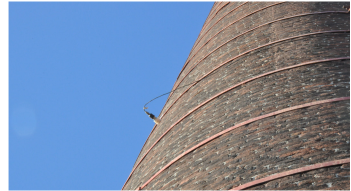
Posizione di accelerometro sulla ciminiera
