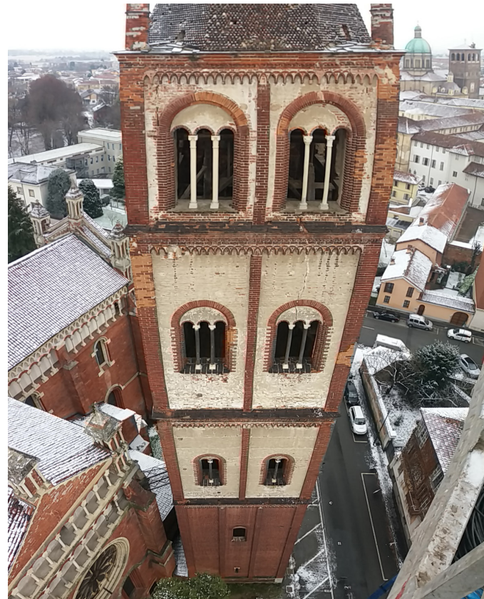
Vista esterna della torre campanaria
