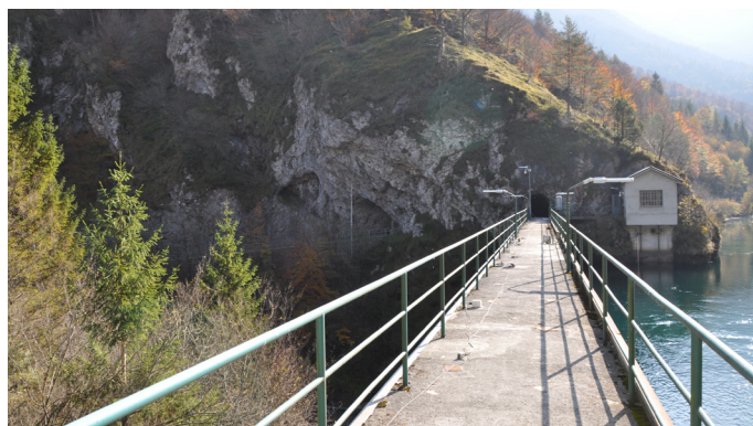
Posizione degli accelerometri sul camminamento della diga
