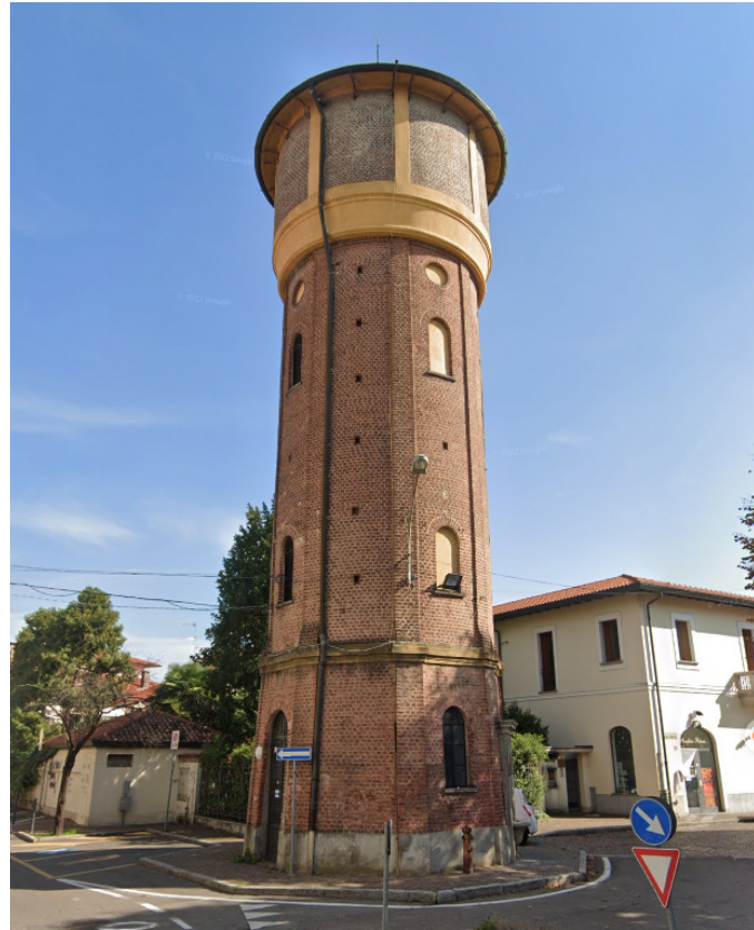
Vista esterna della torre piezometrica
