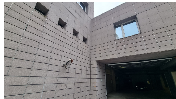
Vista esterna del fabbricato
