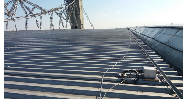
Posizione di terna accelerometrica sulla copertura
