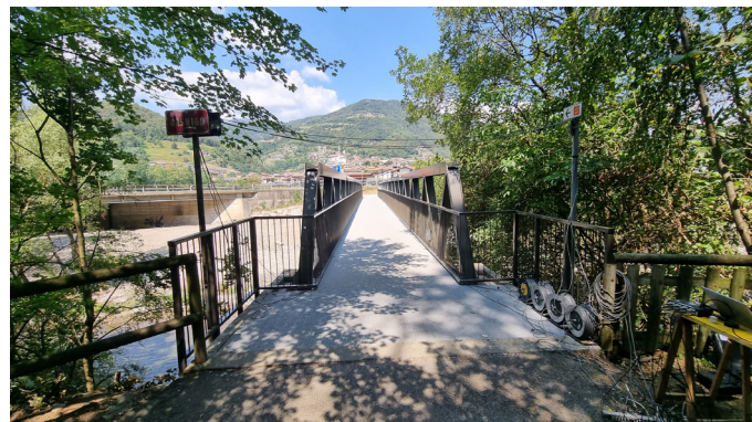
Viste della passerella ciclo-pedonale
