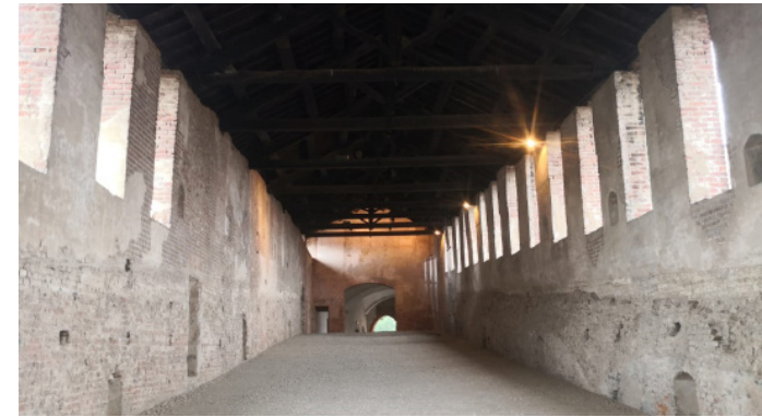
Vista interna del fabbricato
