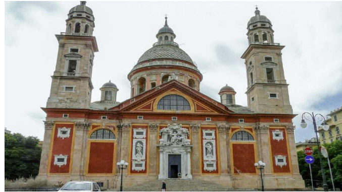
Facciata principale della Basilica di Carignano
