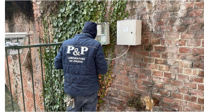
Fase di installazione strumentazione
