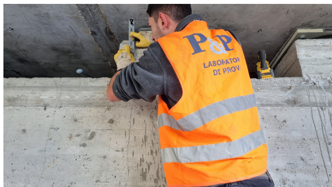
Fasi installazione della strumentazione
