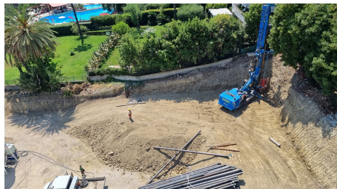
Vista aerea dell'area di cantiere
