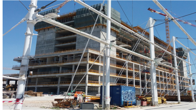
Vista d'insieme dell'edificio in fase di costruzione
