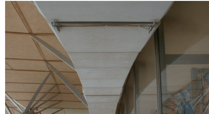
Deformometri installati all'intradosso
