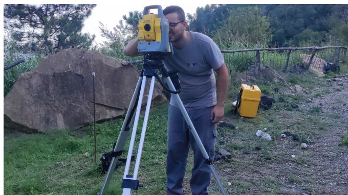
Operazione di lettura topografica con stazione totale
