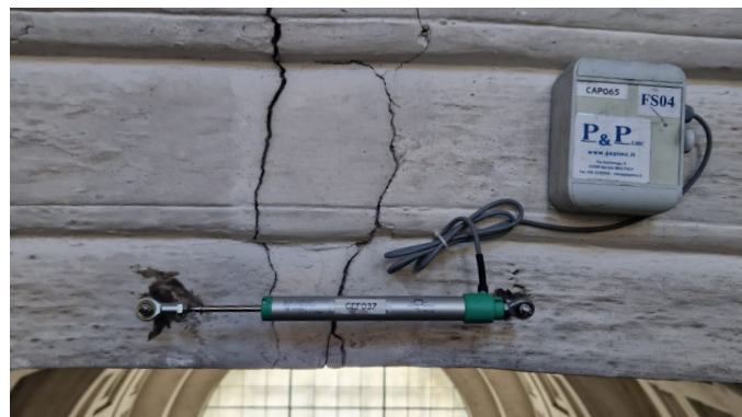
Posizione di fessurimetro
