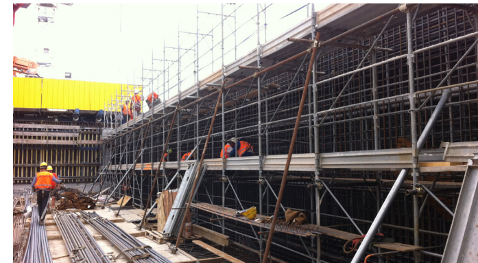
Trave di coronamento – Vista d'insieme
