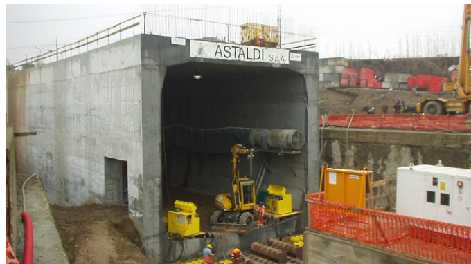
Monolite in fase di infissione
