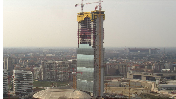
Vista d'insieme dell'edificio in fase di costruzione
