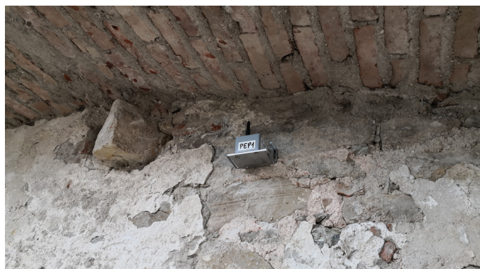
Vista installazione tipo vibrometro
