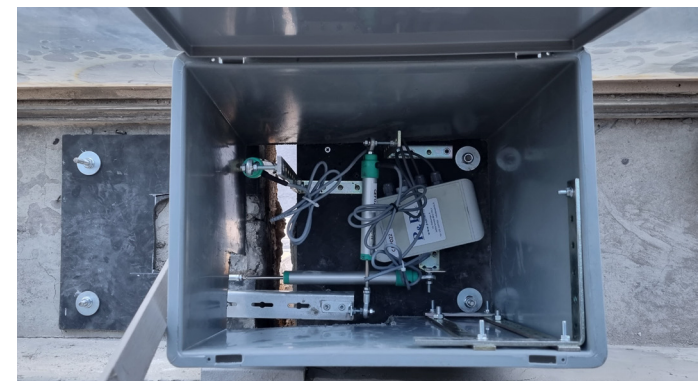
Dettaglio strumentazione quota calpestio
