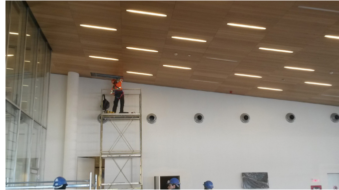
Fase installazione estensimetri
