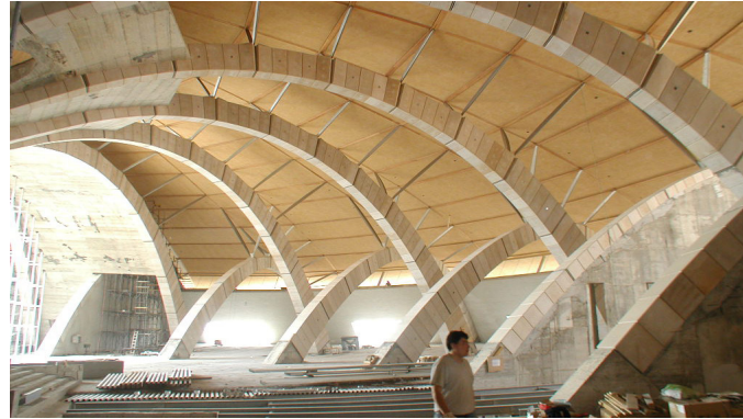
Vista d'insieme della copertura
