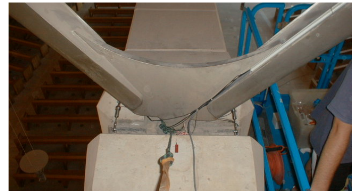
Deformometri installati all'estradosso
