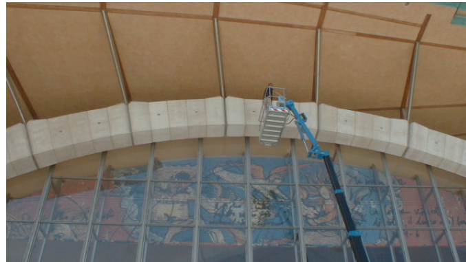
Fase di installazione della strumentazione
