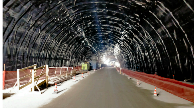
Vista interna della galleria
