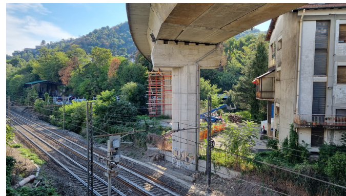
Vista della pila P14
