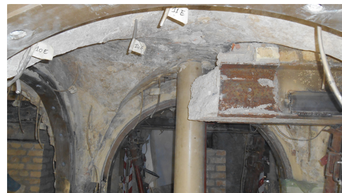
Demolizione della preesistente struttura di consolidamento
