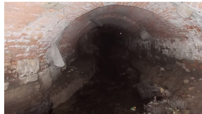
Canale del torrente Bova
