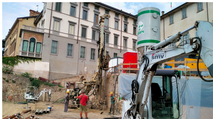
Vista d'insieme del cantiere
