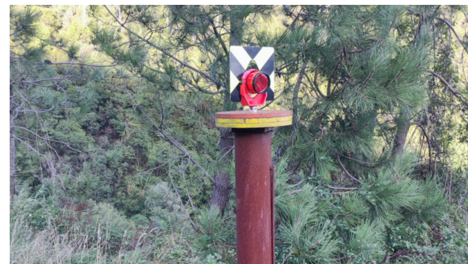
Mira su testa di tubo inclinometrico
