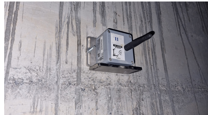
Installazione tipo inclinometro da parete
