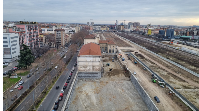
Vista aerea dell'area di cantiere
