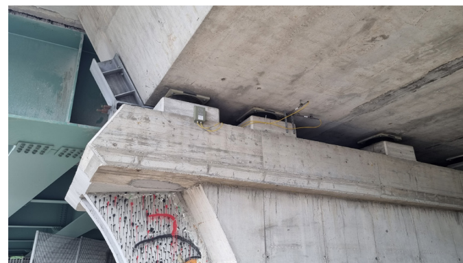
Dettaglio installazione pila P3
