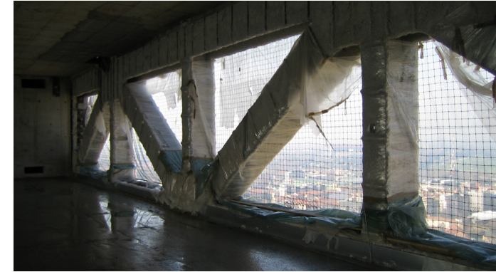
Belt Truss – Vista d'insieme
