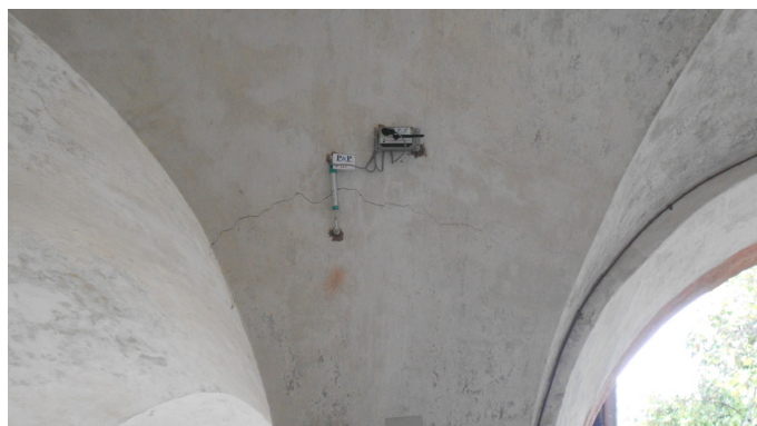
Monitoraggio lesione su una volta
