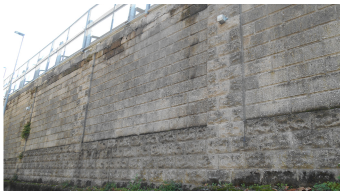
Muro della rampa d'accesso al cavalcavia
