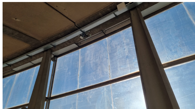
Vista d'insieme installazione in quota
