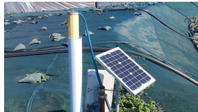
Testa di tubo inclinometrico oggetto del monitoraggio
