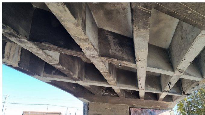
Vista dell'intradosso dell'impalcato
