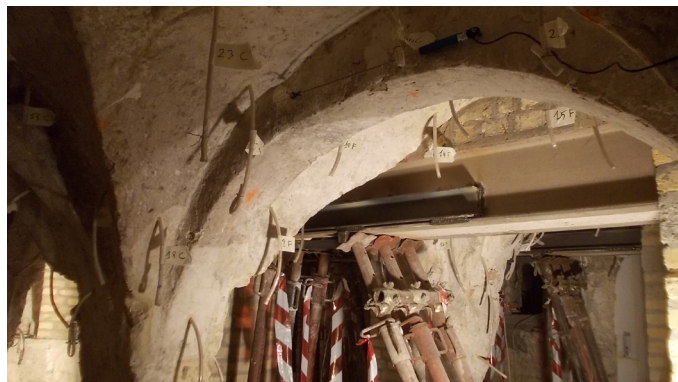
Monitoraggio fessurimetrico preliminare
