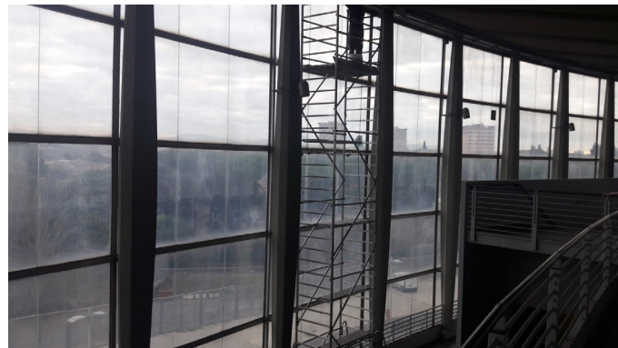
Fasi installazione strumentazione quota copertura
