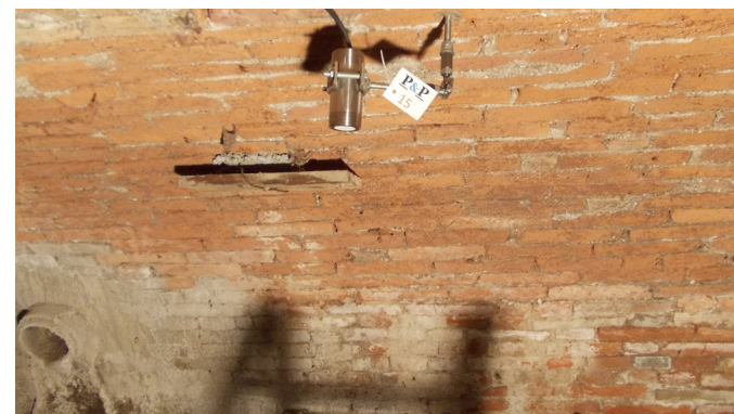
Misuratore di livello ad ultrasuoni
