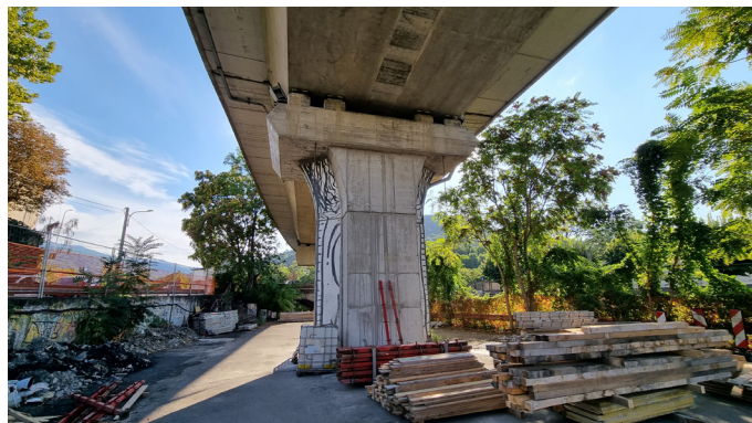
Vista della pila P12
