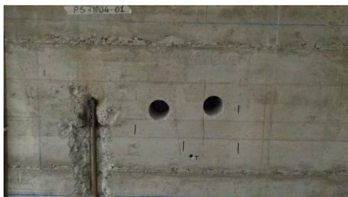
Esecuzione di saggio per prelievo di barra d'armatura
