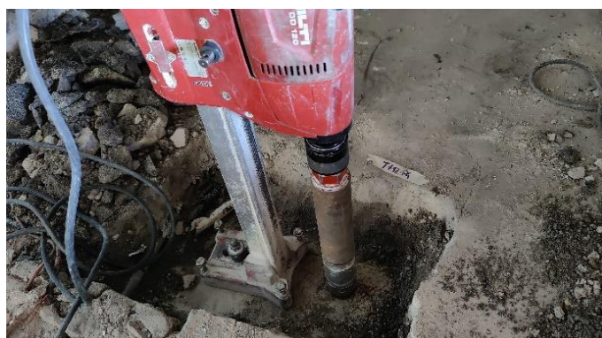
Esecuzione di carotaggi per prova di trazione
