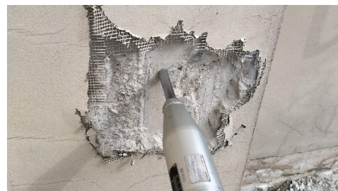
Prova sclerometrica su elemento verticale in c.a.
