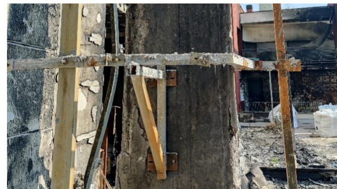
Analisi visiva sui pilastri
