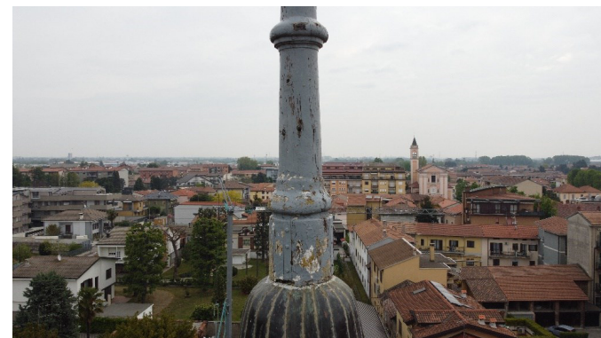
Vista della struttura lignea sommitale della torre
