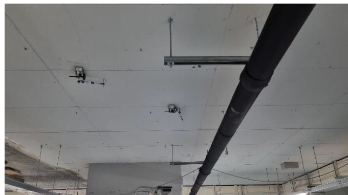
Monitoraggio fessurimetrico di solaio
