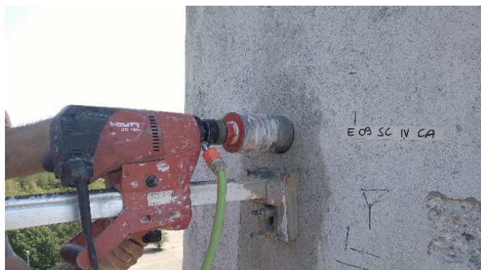
Carotaggio per prova di compressione del cls
