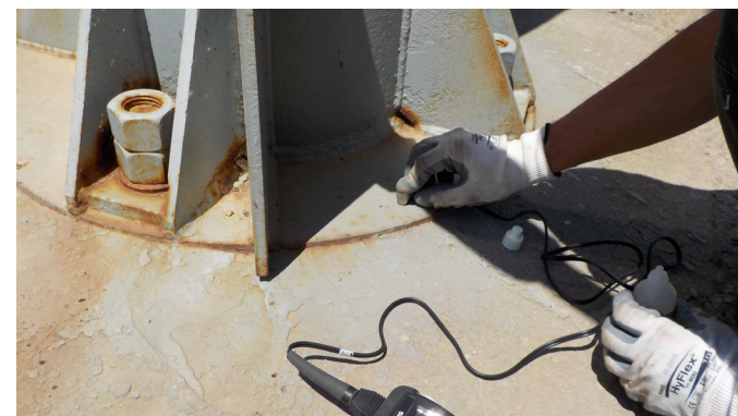
Misura spessimetrica delle carpenterie metalliche
