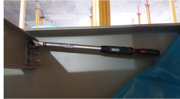
Verifica della coppia di serraggio dei bulloni
