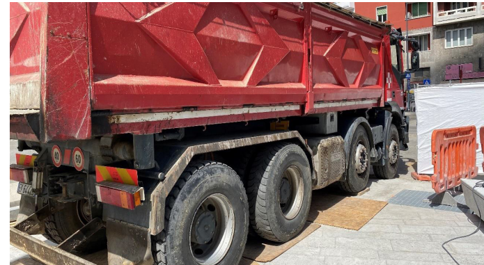
Esecuzione di prova di carico con automezzo
