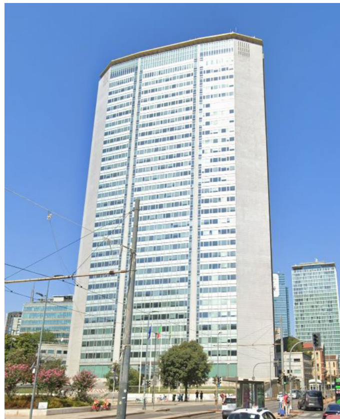
Vista d'insieme della torre radar
