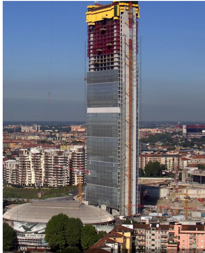
Vista dell'immobile in fase di costruzione
