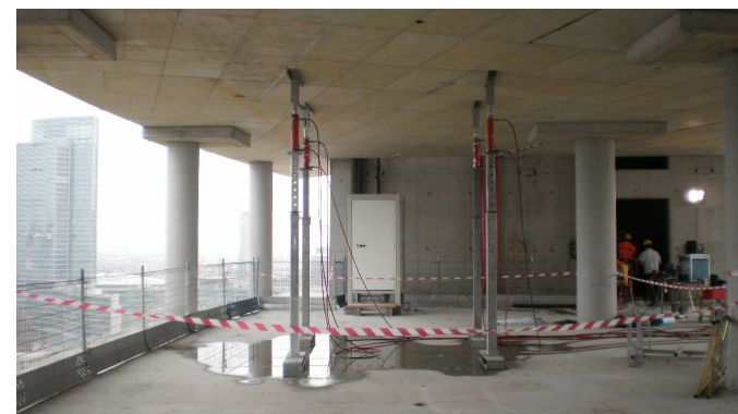
Prova di carico su solaio
