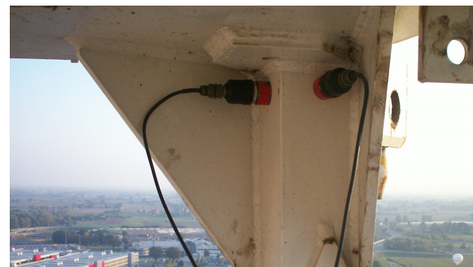
Installazione di accelerometri su elementi di carpenteria
