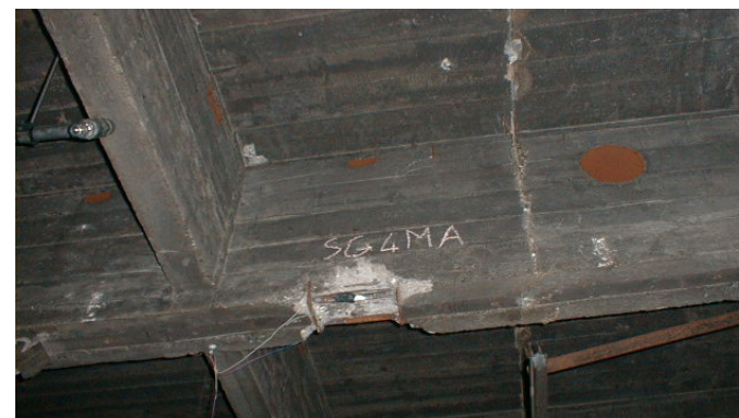
Monitoraggio degli sforzi tramite estensimetro
