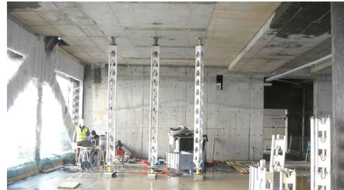
Prova di carico su solaio con pistoni
