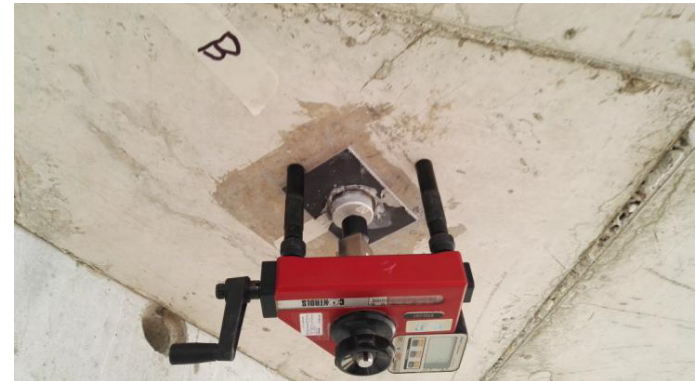
Fissaggio dello strumento di applicazione del carico
