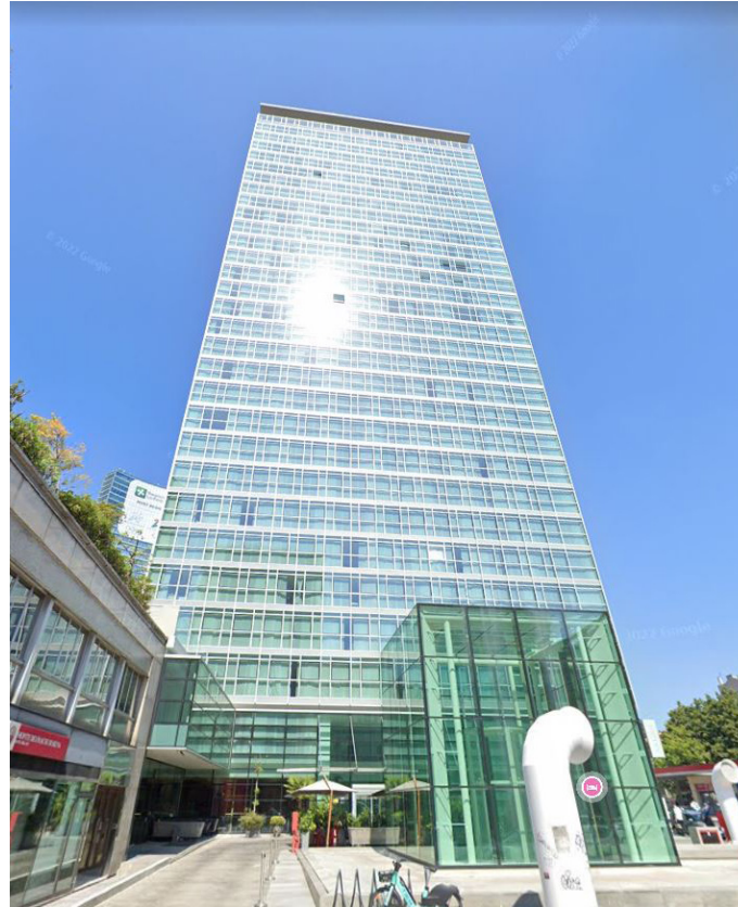
Vista d'insieme della Torre Galfa
