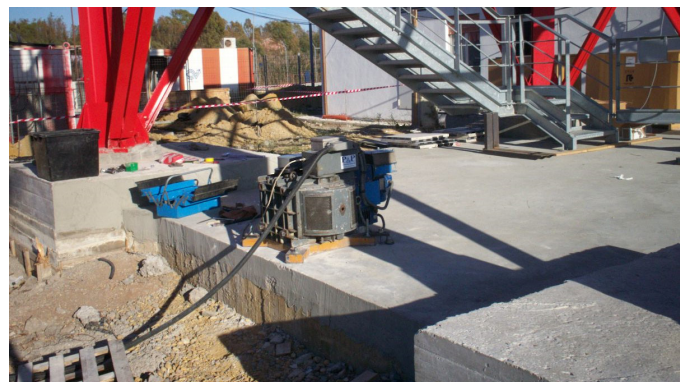
Posizionamento della vibroдина per prova dinamica
