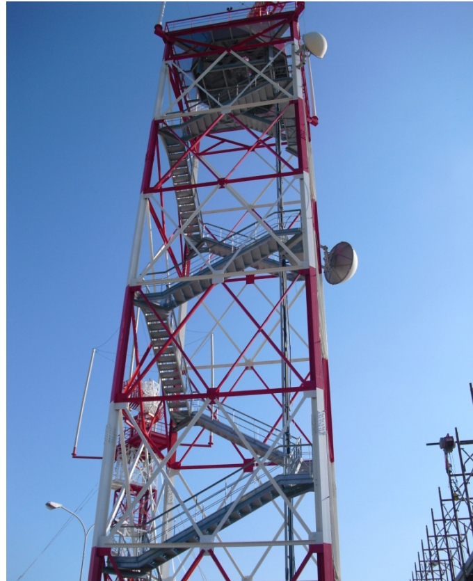
Vista d'insieme della torre radar
