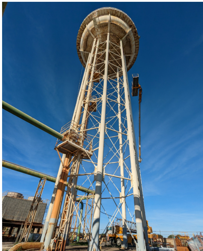
Vista d'insieme del serbatoio pensile
