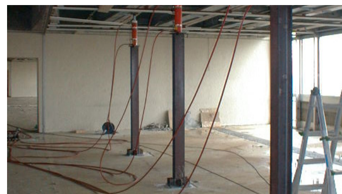
Applicazione del carico tramite martinetti idraulici
