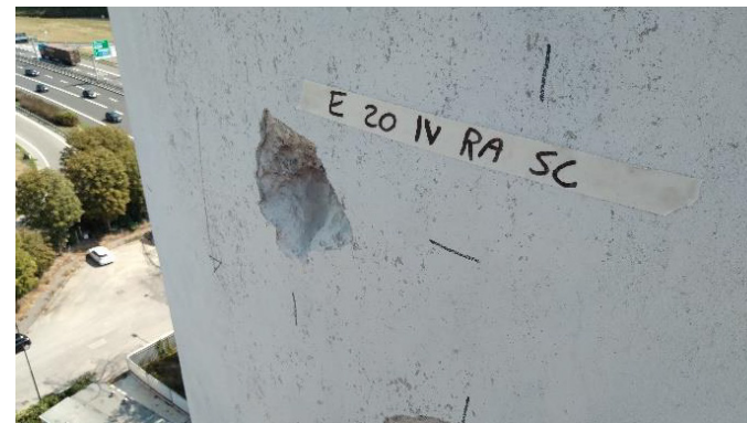
Saggio per misura diretta dell'armatura
