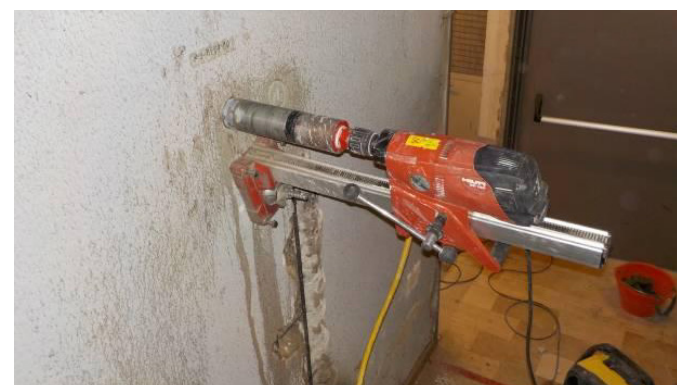
Carotaggio per prova di compressione sul calcestruzzo
