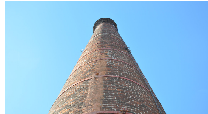
Posizione di accelerometri sulla ciminiera
