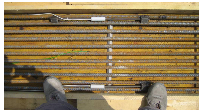
Estensimetro su armatura per monitoraggio in fase di getto
