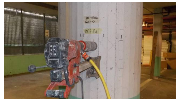
Carotaggio per prova di compressione sul calcestruzzo
