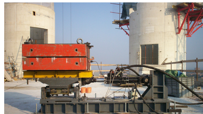
Installazione di vibrodina sulla copertura
