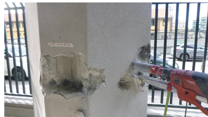
Carotaggio per prova di compressione sul calcestruzzo
