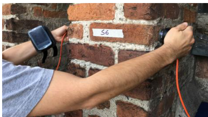
Indagine sonica su colonna in muratura
