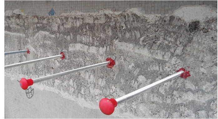
Barre d'ancoraggio oggetto di prova
