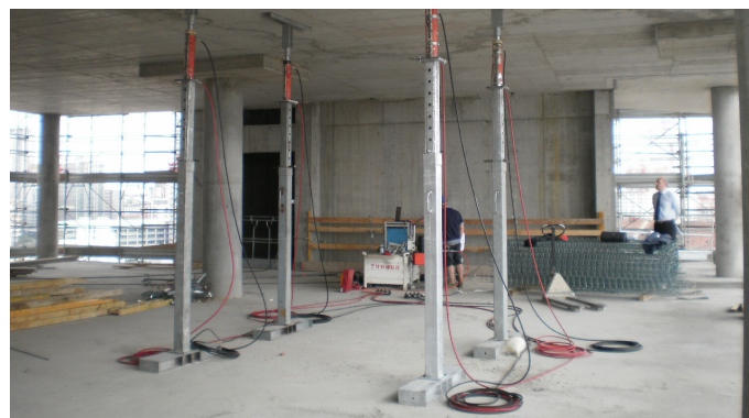
Prova di carico su solaio
