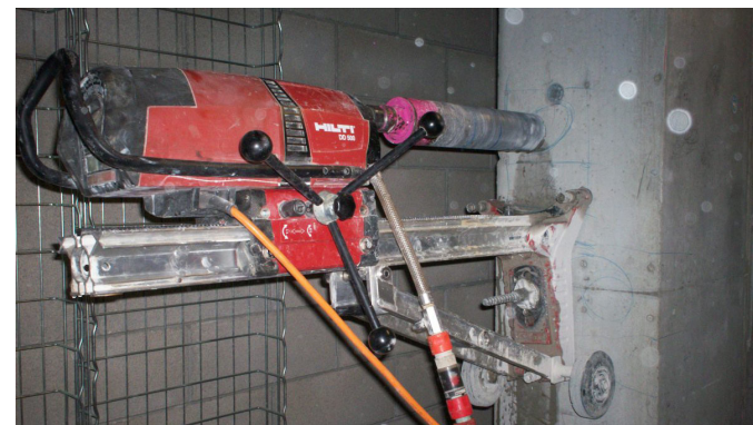
Carotaggio per prova di compressione sul calcestruzzo
