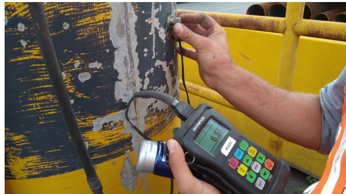
Misurazione spessimetrica del tubolare centrale di torre faro
