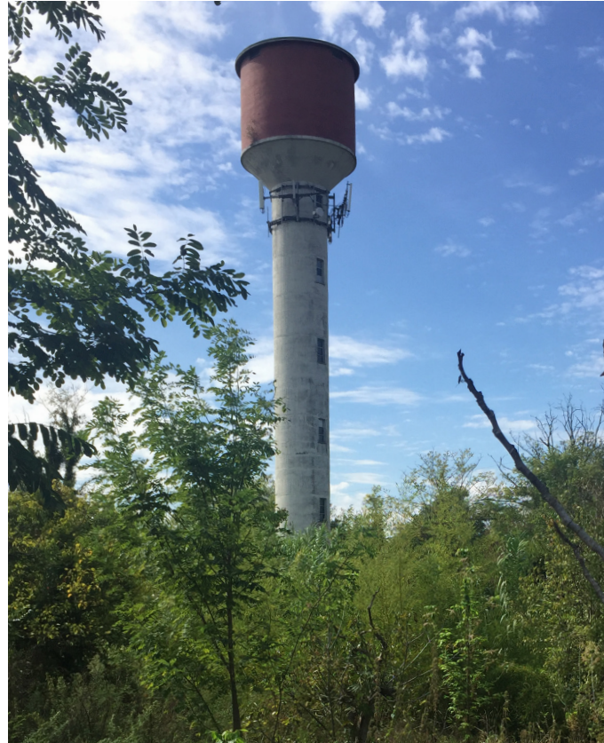
Vista d'insieme del serbatoio pensile
