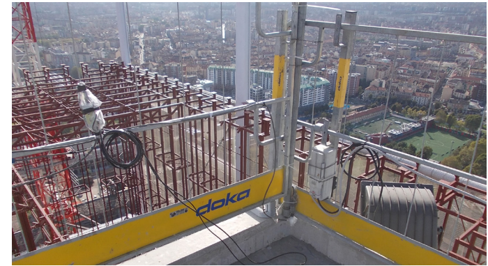
Posizione di accelerometro sulla copertura dell'edificio
