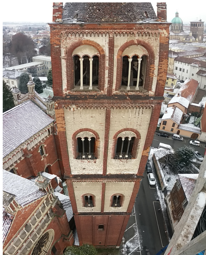
Vista esterna della torre campanaria
