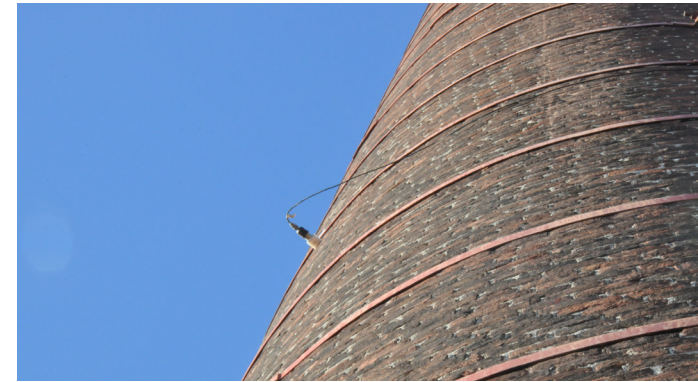
Posizione di accelerometro sulla ciminiera
