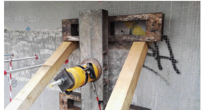
Fissaggio dello strumento di applicazione del carico
