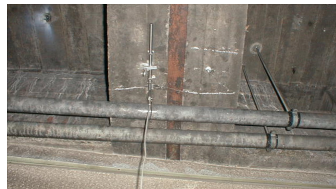
Monitoraggio della deformata tramite sensore di spostamento
