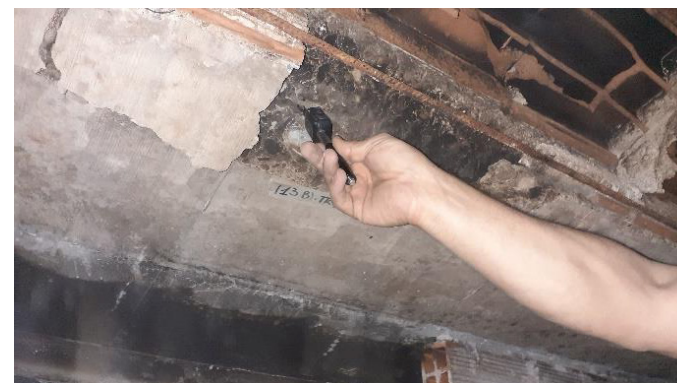
Indagine durometrica su barre d'armatura
