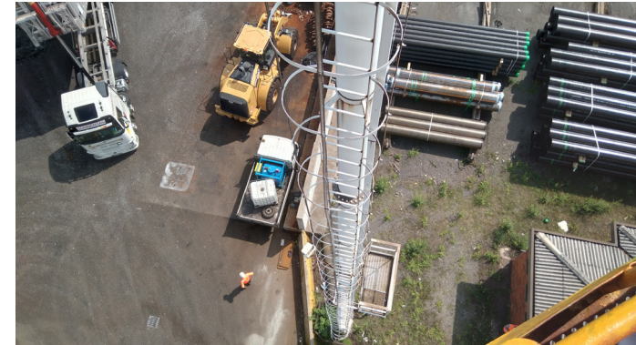
Vista dall'alto di torre faro durante l'attività di rilievo
