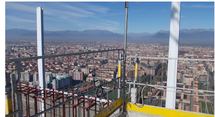
Installazione di tacogonioanemometro in copertura
