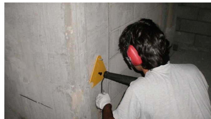
Esecuzione di prova con pistola Windsor
