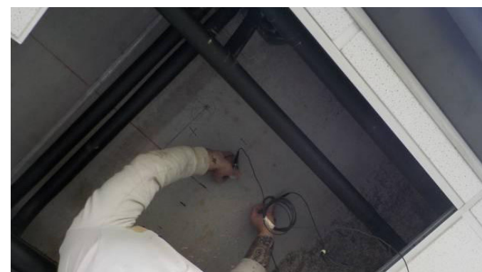
Indagine sonica su solaio in c.a.
