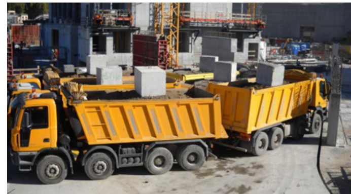
Prova di carico su solaio con autocarri
