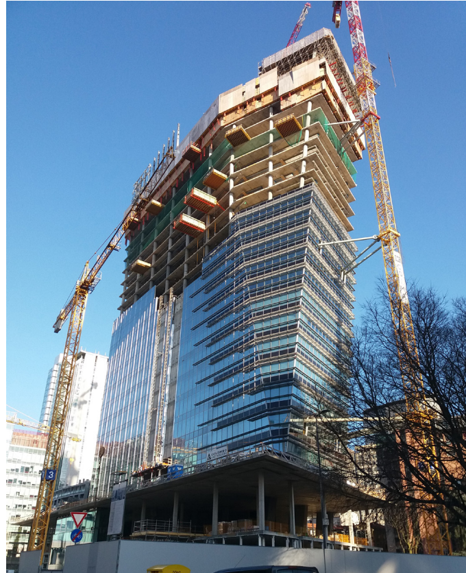
Vista dell'immobile in fase di costruzione
