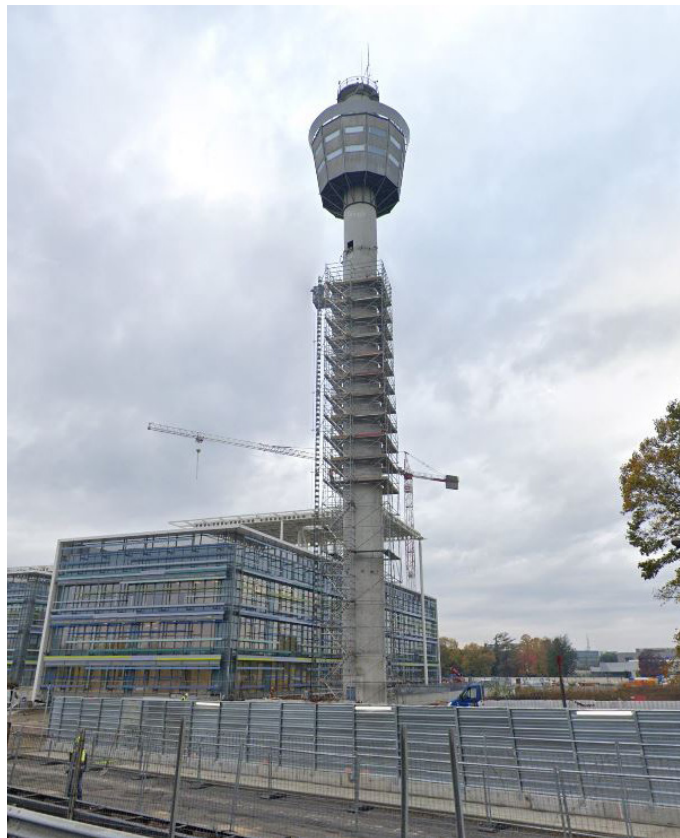
Vista d'insieme della Torre della Telettra
