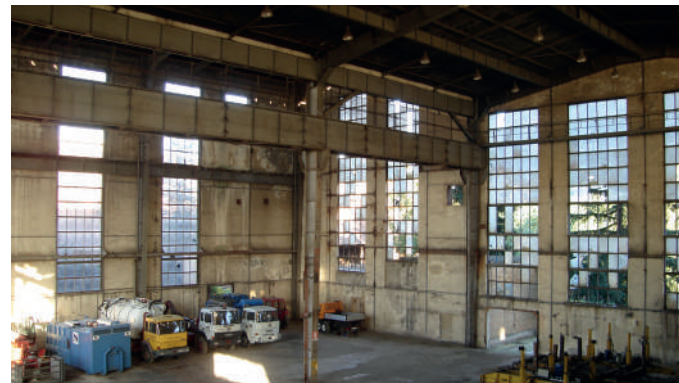
Vista interna dell'immobile
