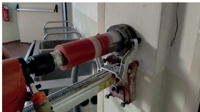
Esecuzione di carotaggi per caratterizzazione del calcestruzzo
