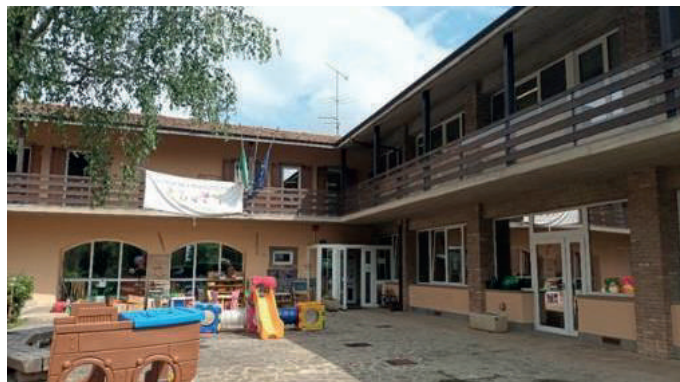
Vista esterna della scuola materna
