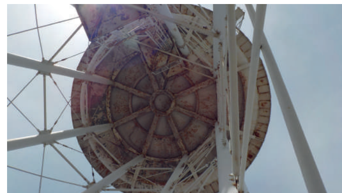
Vista dell'intradosso del serbatoio della torre piezometrica
