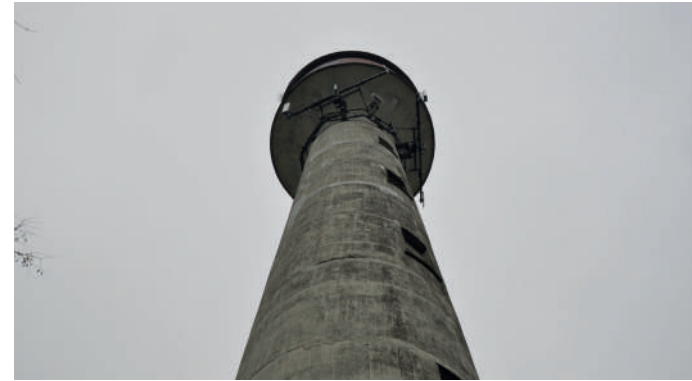
Vista del fusto della torre piezometrica
