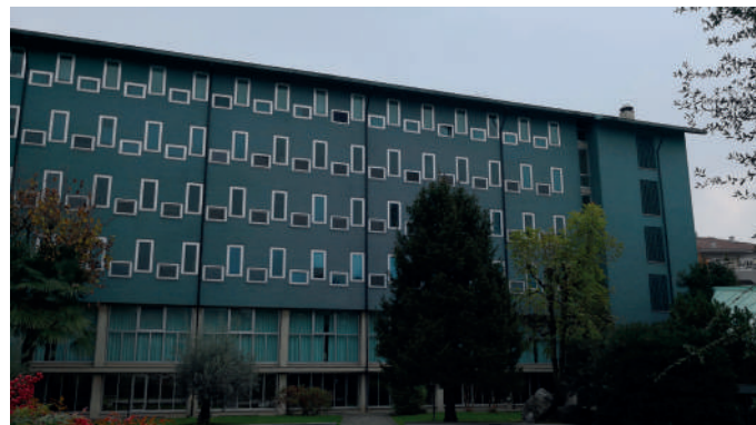
Vista esterna dell'immobile - Palazzina Comando
