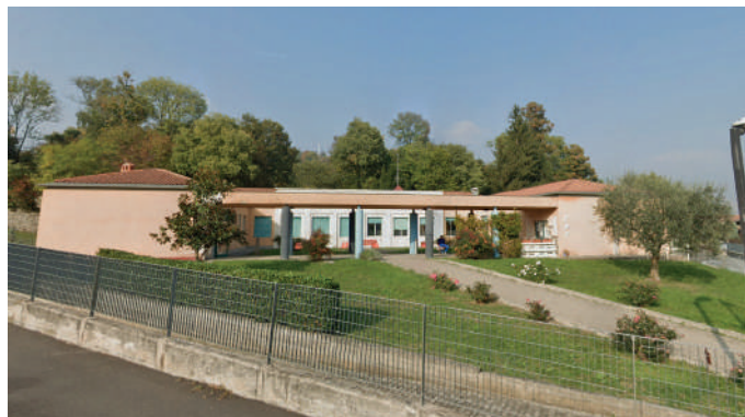
Vista esterna dell'edificio allo stato di fatto
