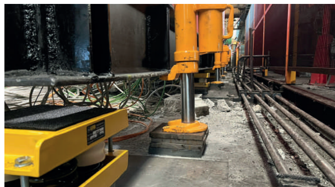
Sollevamento di cabina con blinde per installazione isolatori
