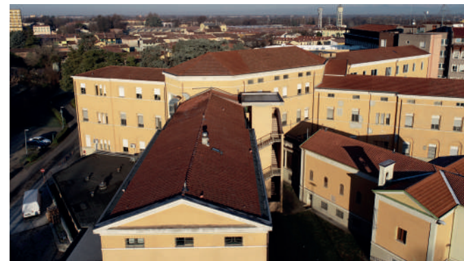
Immagini da drone del complesso ospedaliero
