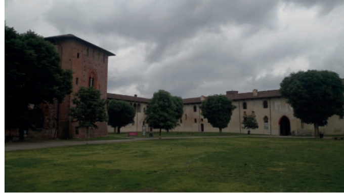
Vista esterna dell'edificio allo stato di fatto
