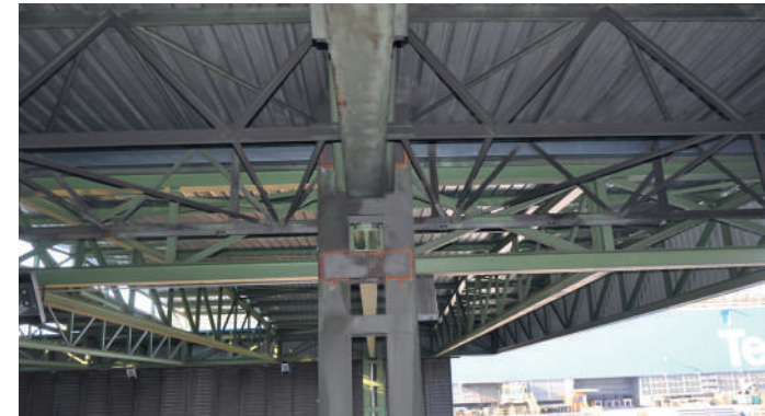
Vista interna dell'immobile
