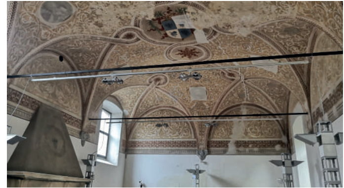
Vista interna dell'edificio allo stato di fatto
