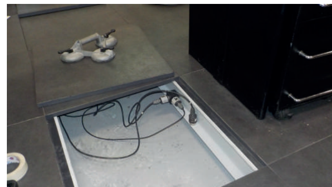
Posa di terna accelerometrica sull'impalcato della cabina
