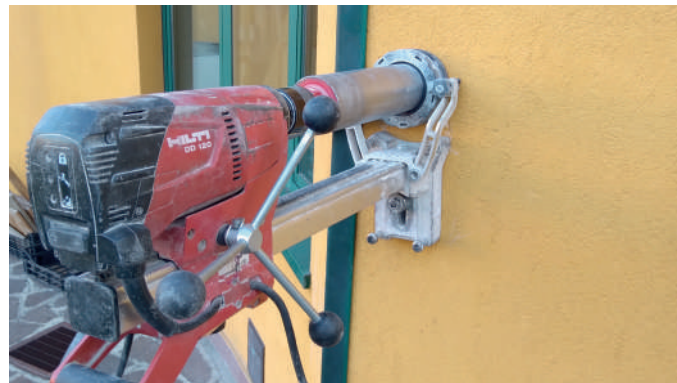
Esecuzione di carotaggio su elemento in c.a.
