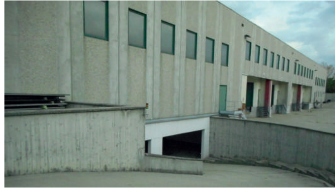
Vista esterna del complesso industriale
