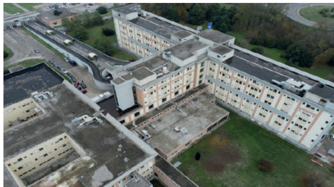
Vista esterna del Corpo Degenza
