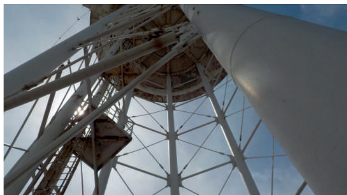
Vista esterna della torre piezometrica
