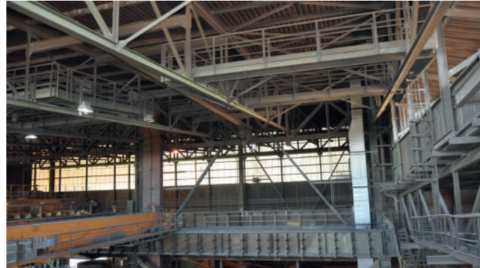
Vista interna dell'immobile
