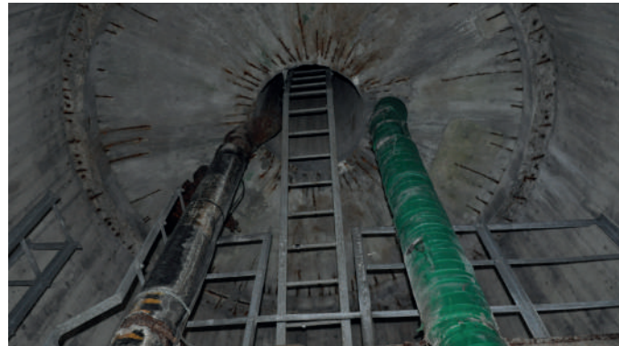
Vista dell'intradosso del serbatoio della torre piezometrica
