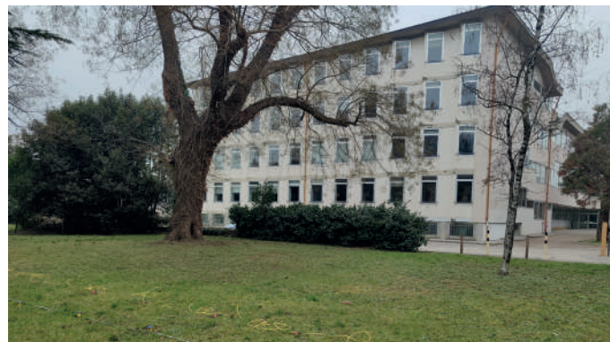
Vista esterna dell'Istituto Percoto
