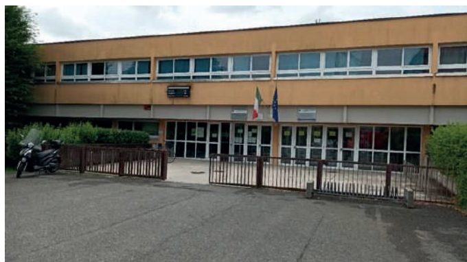
Vista esterna della scuola secondaria
