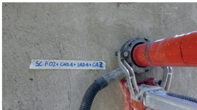
Carotaggio per caratterizzazione del calcestruzzo
