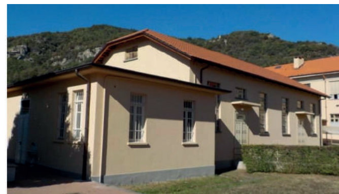
Vista esterna dell'immobile
