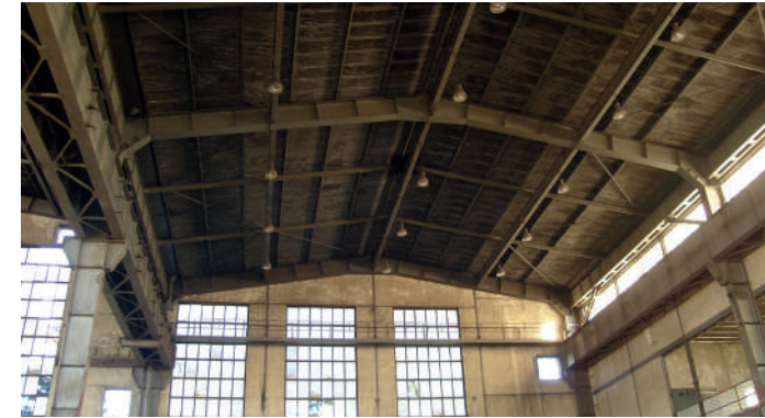
Vista interna dell'immobile
