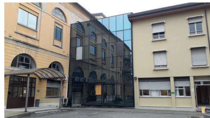
Vista esterna dell'immobile - ala moderna
