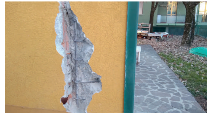
Saggio per indagare le armature su pilastro
