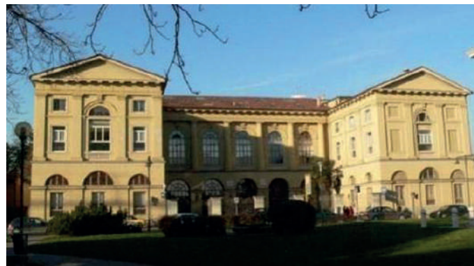
Vista esterna dell'immobile - ala storica
