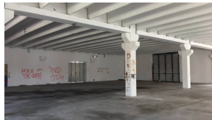
Vista interna dell'immobile
