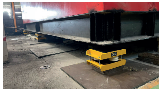
Inserimento dei dispositivi isolatori antivibranti
