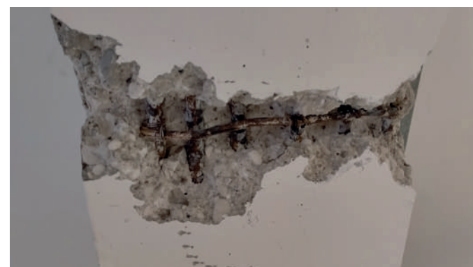
Saggio per indagare le armature su pilastro
