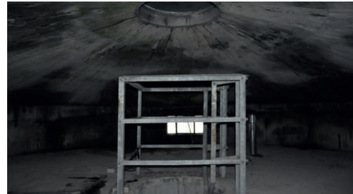
Vista interna al serbatoio della torre piezometrica
