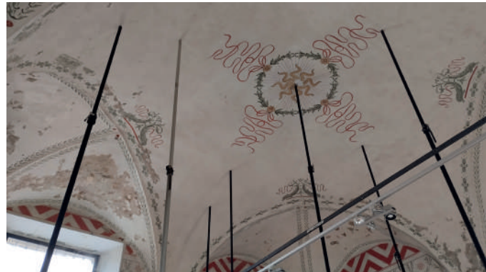
Sensori per l'esecuzione di prova di carico statica
