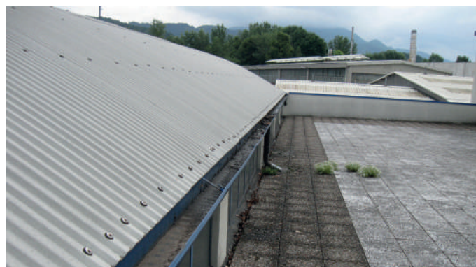
Vista della copertura dell'immobile
