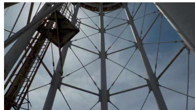
Vista esterna della torre piezometrica
