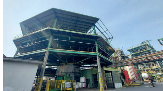
Vista esterna dell'impianto pastigliatrici
