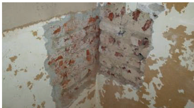
Verifica dell'ammorsamento tra le murature
