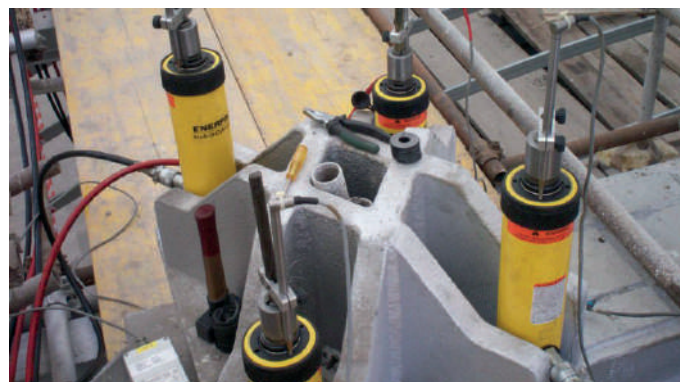
Sistema di tesatura con n. 4 martinetti
