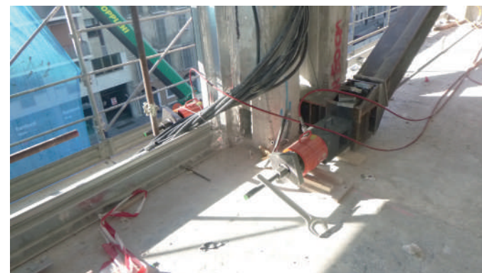
Attuatori idraulici per tensionamento di barre di contrasto
