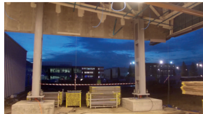
Vista delle colonne in prossimità dei nodi
