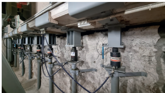
Vista dei martinetti idraulici installati
