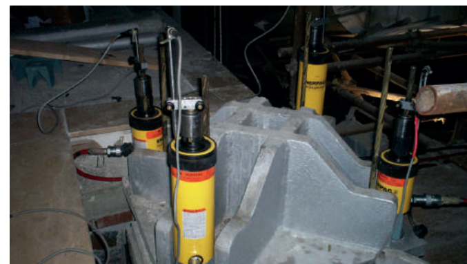
Sistema di tesatura con n. 4 martinetti
