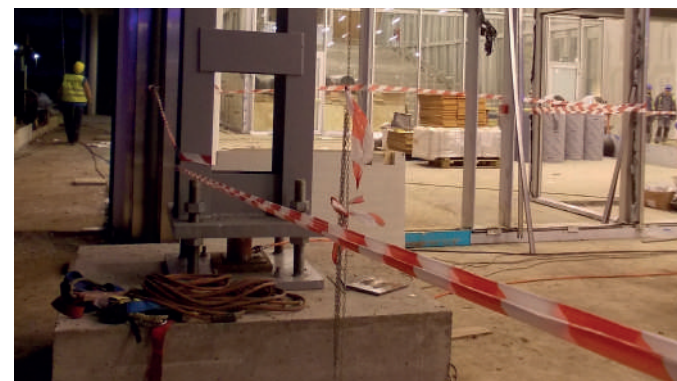
Vista di dettaglio del martinetto al di sotto della colonna
