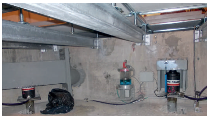
Vista dei martinetti idraulici installati
