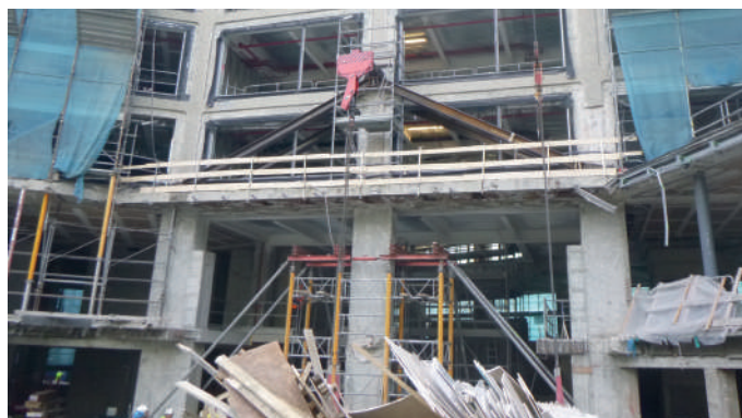
Vista di uno dei pilastri da rimuovere
