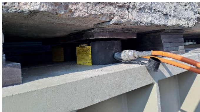
Martinetti per il sollevamento verticale di trave esistente
