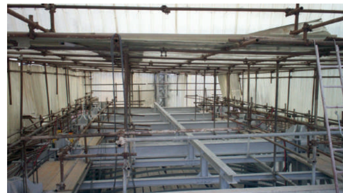
Vista generale della zona di lavoro a piano copertura
