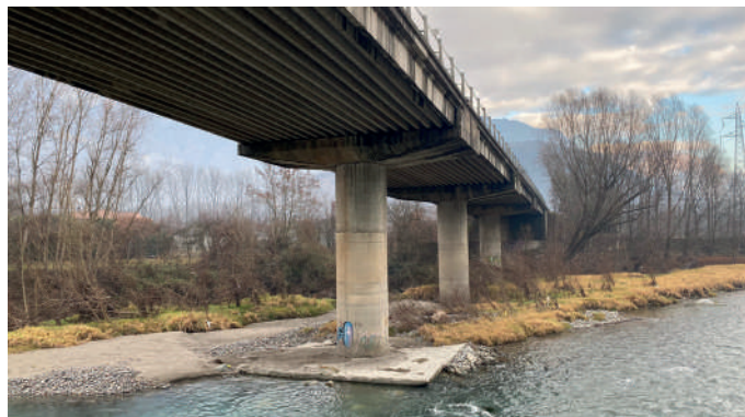
Vista del viadotto
