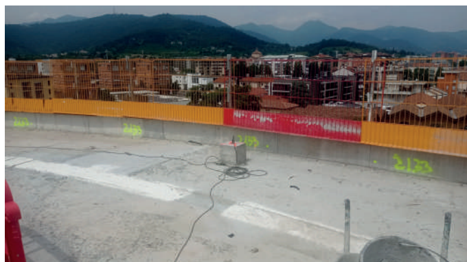
Posa di terna accelerometrica in copertura per prova dinamica
