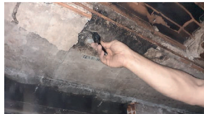
Indagine durometrica su barre d'armatura
