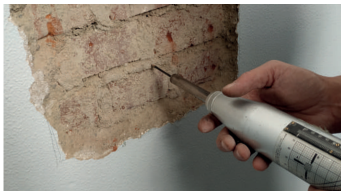
Prova penetrometrica su corso di malata
