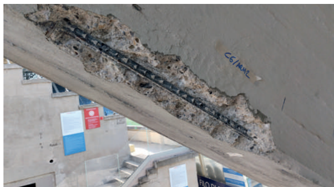
Estrazione di barra d'armatura su trave esistente
