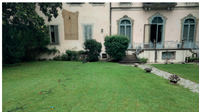
Esecuzione di indagine MASW
