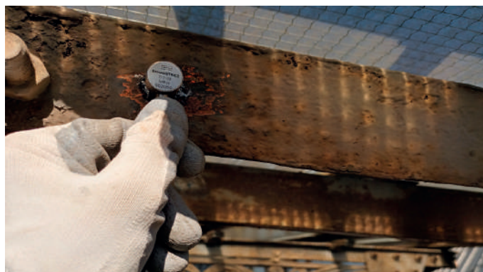
Prove diagnostiche sugli acciai degli arconi della copertura
