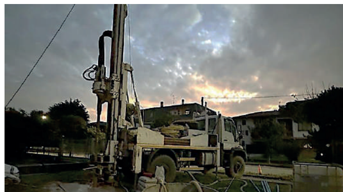
Esecuzione di sondaggio geognostico
