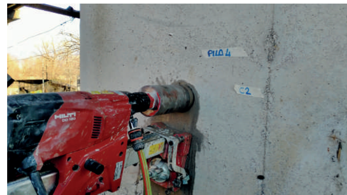
Operazione di carotaggio su pila
