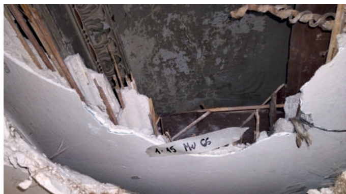
Rilievo di dettaglio costruttivo di solaio
