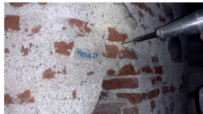
Prova penetrometrica su giunto di malta
