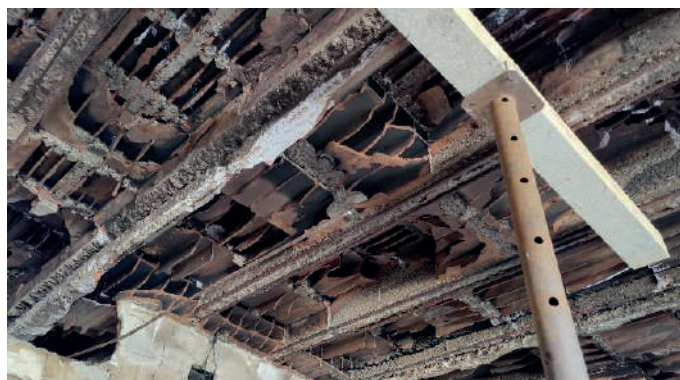
Analisi visiva sui solai
