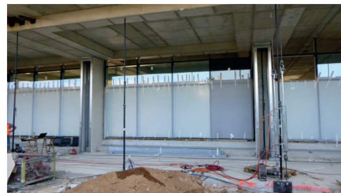
Esecuzione di prova a tiro
