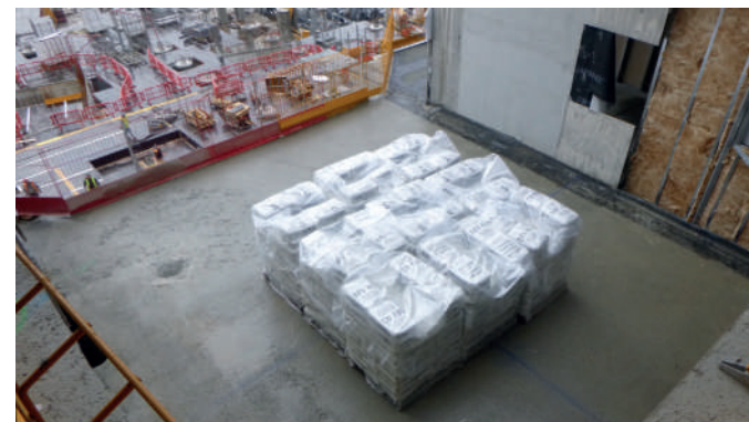
Esecuzione di prova di carico con zavorre
