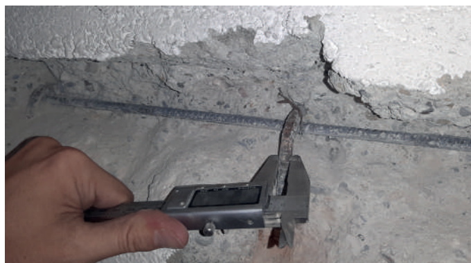
Rilievo delle armatura mediante saggi localizzati
