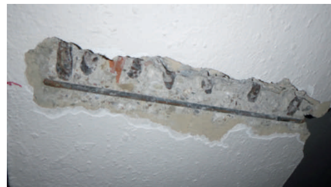
Saggio su elemento in c.a. per il rilievo dell'armatura
