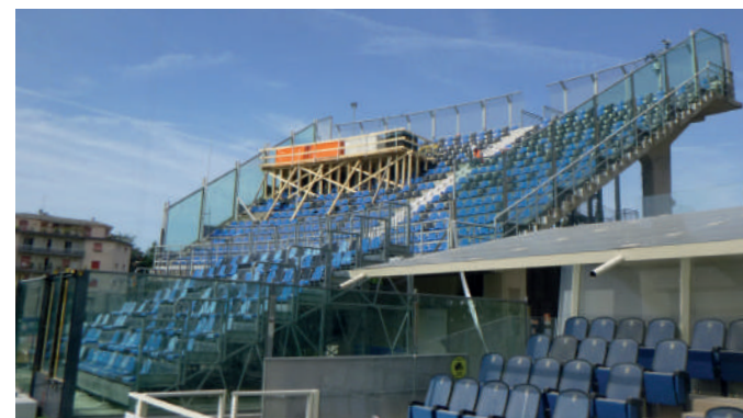
Prova di carico con acqua su gradonata esistente
