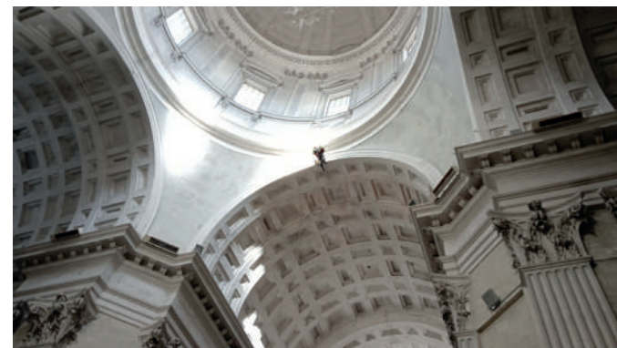
Posizionamento di fessurimetro
