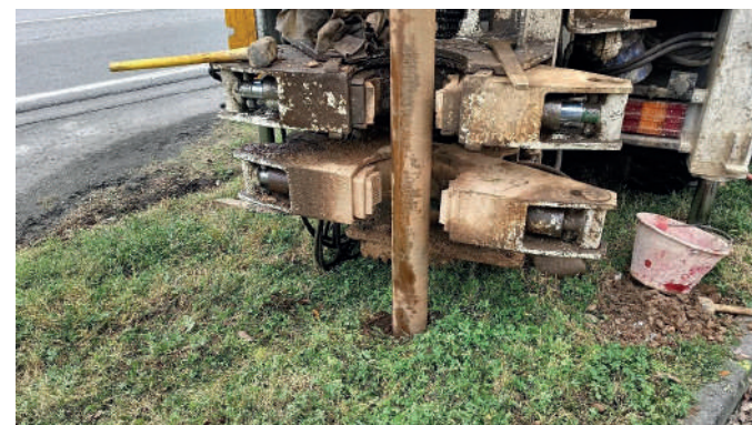
Esecuzione di sondaggio geognostico
