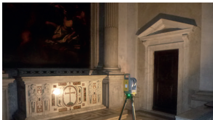
Rilievo laser scanner per cedimenti della pavimentazione
