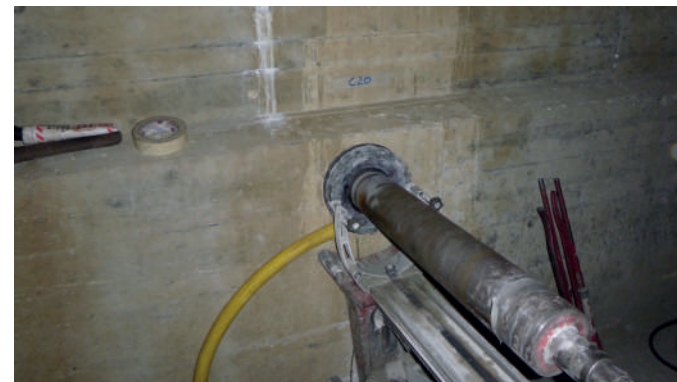
Prelievo di carotaggi dal corpo diga
