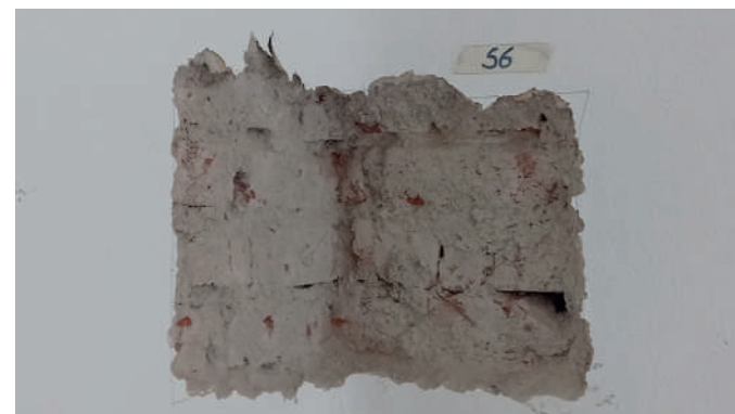
Saggio su muratura per verifica di ammassamento
