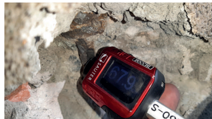
Prova durometrica su barra d'armatura
