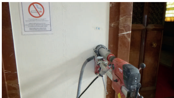
Esecuzione di carotaggio su elemento in calcestruzzo
