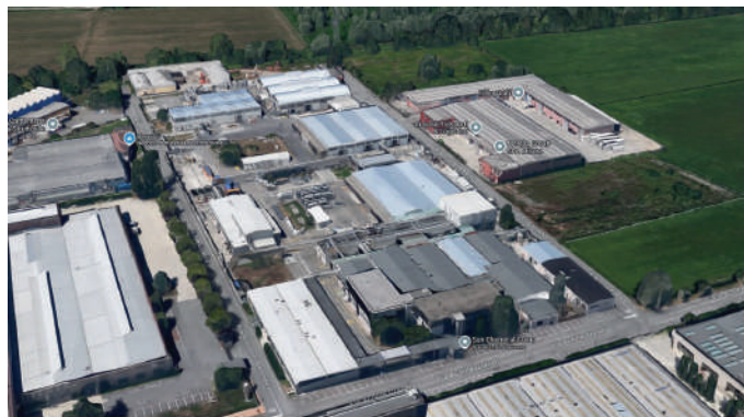
Vista dall'alto del complesso industriale Sun Chemical
