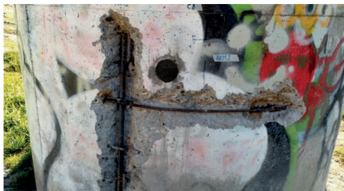
Operazione di estrazione di barra d'armatura su pila
