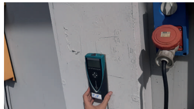
Indagini pacometriche su pilastro in calcestruzzo
