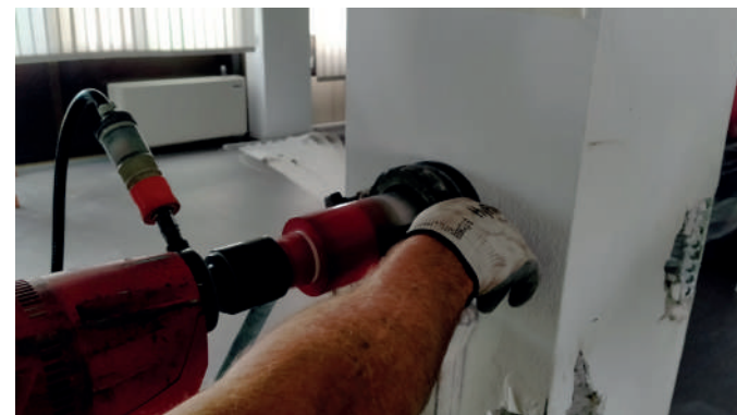
Carotaggio su pilastro
