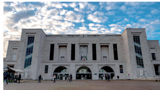
Ingresso dell'ospedale dal Padiglione 1, oggetto di indagini
