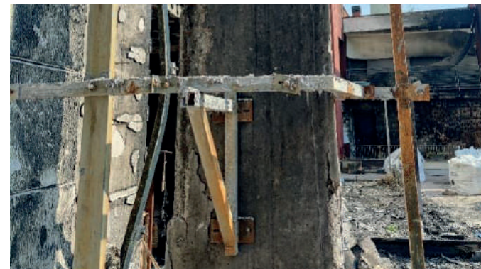
Analisi visiva sui pilastri
