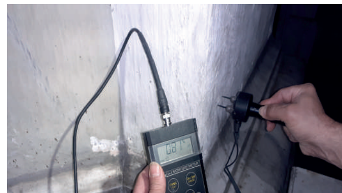
Misurazione igrometrica su muratura
