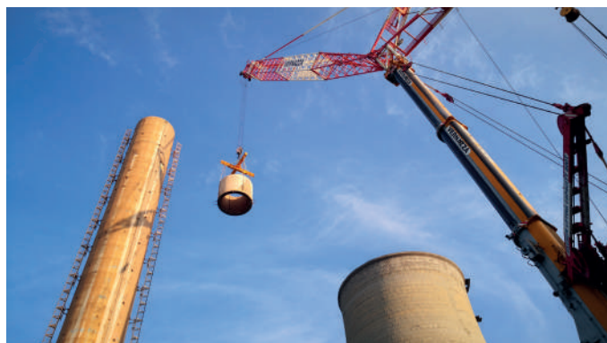
Demolizioni a conchi della ciminiera tramite gru
