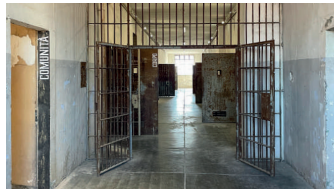
Vista del corridoio delle celle dell'ex carcere
