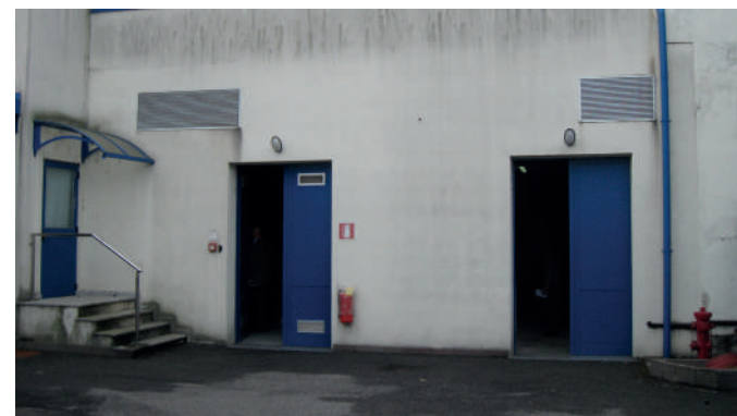
Vista esterna dell'immobile
