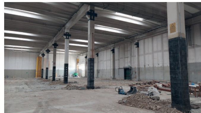
Placcaggio dei pilastri in c.a. esistenti
