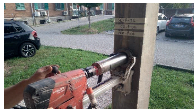
Carotaggio per valutazione della resistenza del calcestruzzo
