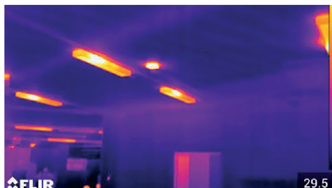
Termocamera per rilievo della struttura portante
