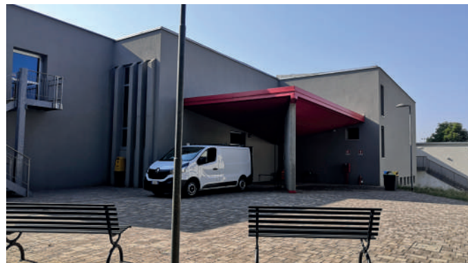
Vista esterna dell'immobile allo stato di fatto
