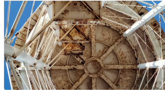
Vista dell'intradosso della cisterna del serbatoio
