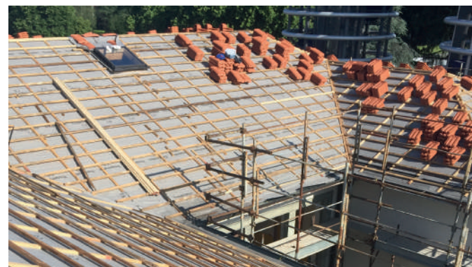
Rifacimento della copertura
