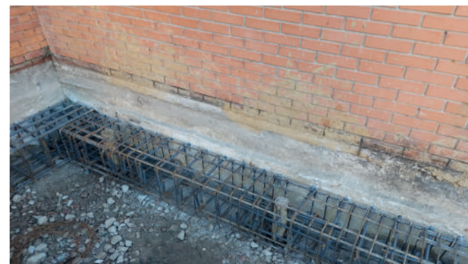
Armatura del cordolo in c.a. di rinforzo alle fondazioni
