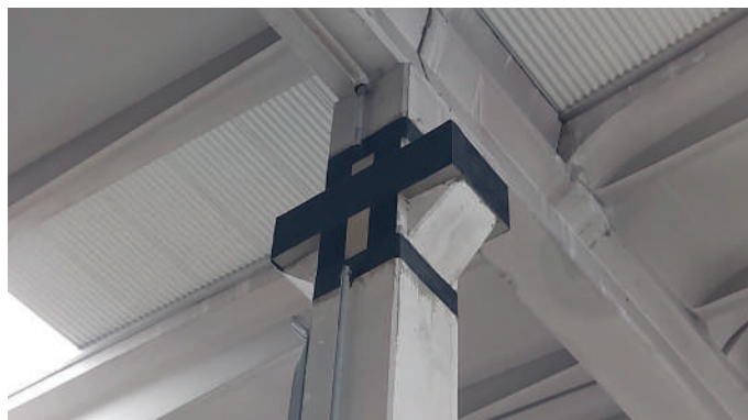
Placcaggio del nodo trave-pilastro
