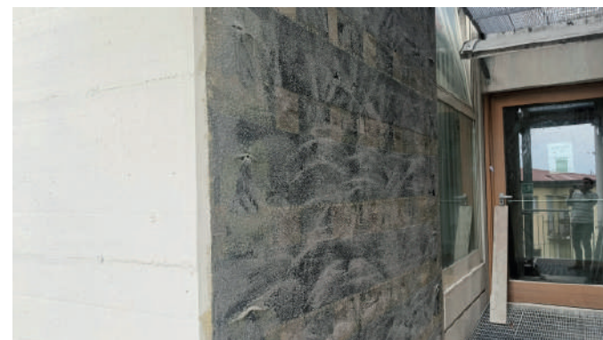
Rinforzo setti in c.a. con CFRP
