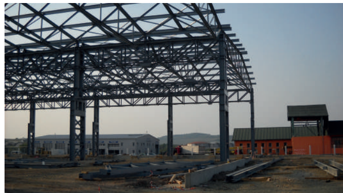
Realizzazione della struttura in carpenteria metallica
