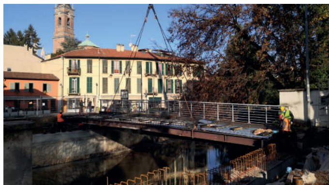
Posa della struttura portante del nuovo ponte
