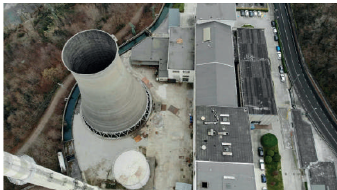
Vista da drone della centrale ante demolizione
