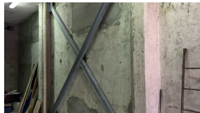
Nuovi controventi di rinforzo
