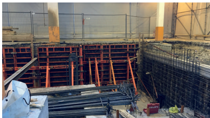
Messa in sicurezza degli scavi per la vasca
