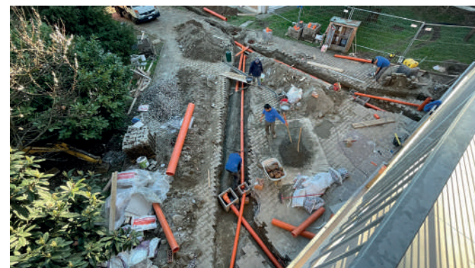
Direzione lavori delle opere edili esterne
