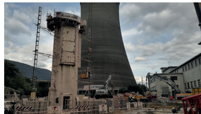
Opere di demolizione della base della ciminiera
