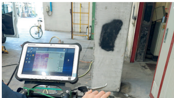
Indagine georadar alla base del pilastro
