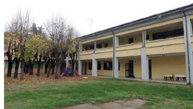
Vista degli esterni del corpo secondario della scuola materna
