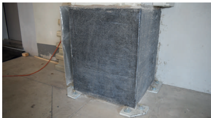
Rinforzo di pilastri prefabbricati esistenti tramite fasciatura
