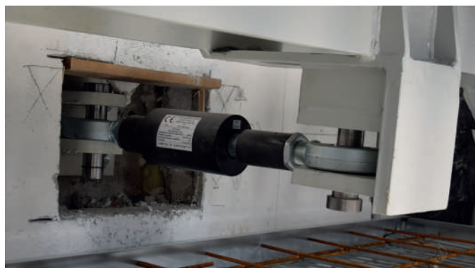
Messa in opera di accoppiatori idraulici antisismici
