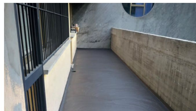
Impermeabilizzazione dei balconi esistenti
