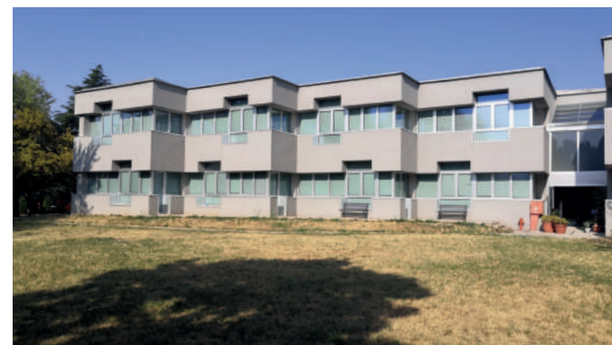
Vista esterna dell'immobile allo stato di fatto
