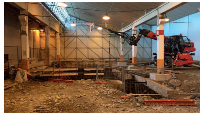
Realizzazione in corso d'opera di vasca interrata
