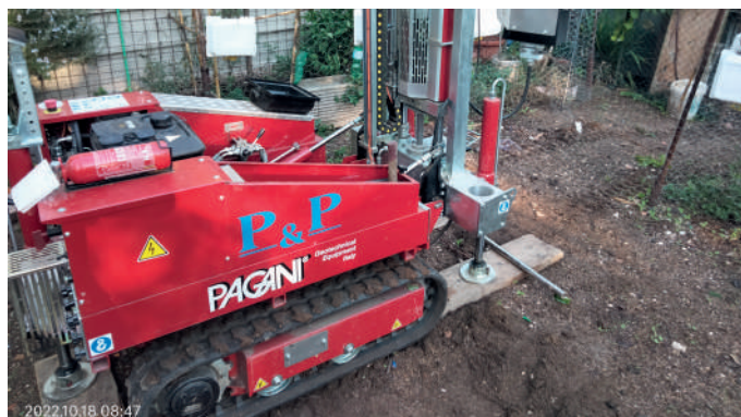
Esecuzione di indagini geognostiche
