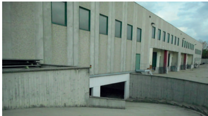
Vista esterna del complesso industriale
