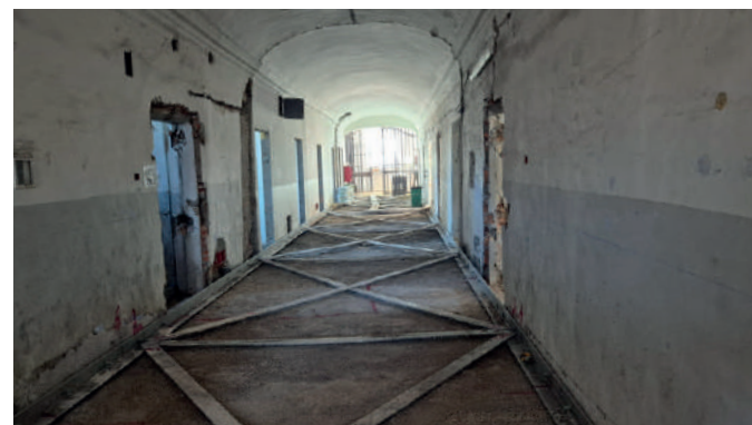
Cerchiature metalliche di piano
