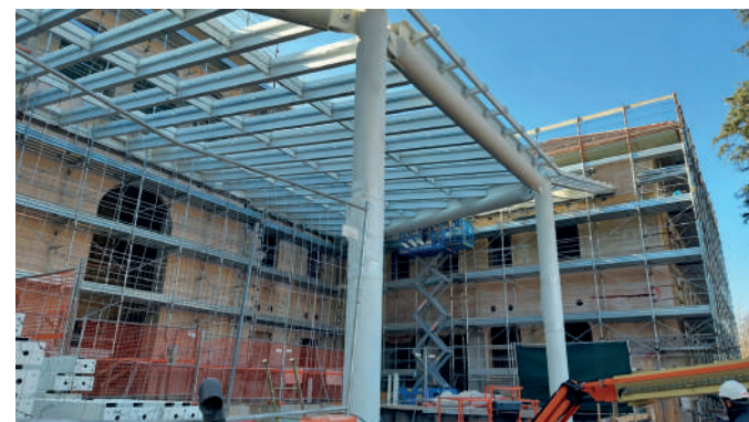
Posa delle carpenterie metalliche della corte vetrata
