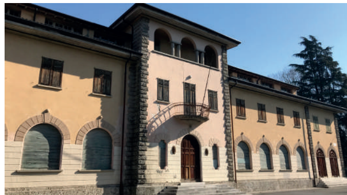
Vista esterna dell'immobile allo stato di fatto
