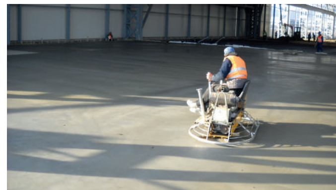
Lisciatura della pavimentazione in calcestruzzo
