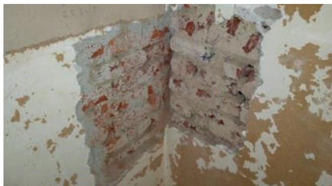
Verifica dell'ammorsamento tra le murature
