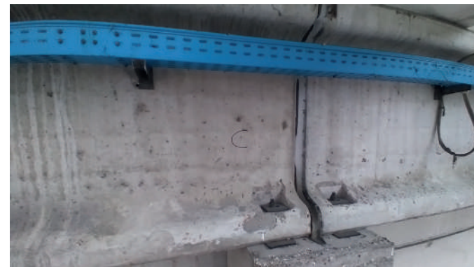
Dissesti sull'appoggio delle travi riconducibili al cedimento
