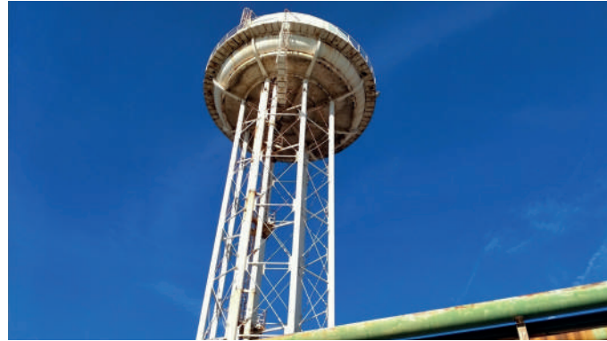
Vista del serbatoio pensile
