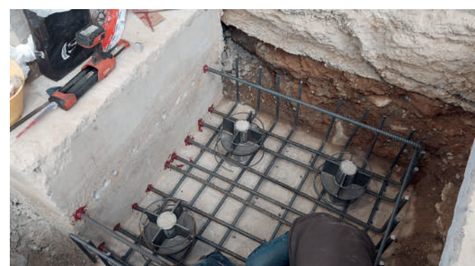
Esecuzione del rinforzo fondazionale del plinto
