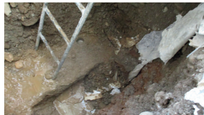
Saggio in fondazione alla base del pilastro
