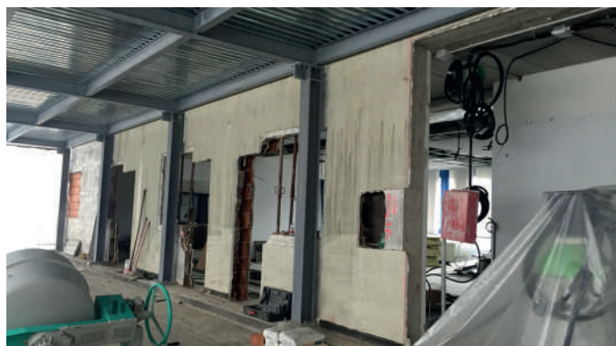
Vista intradossale del nuovo solaio in lamiera grecata
