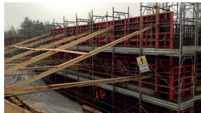
Casseratura delle pareti della vasca
