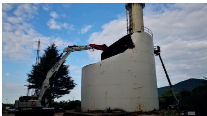
Demolizione di silos tramite mezzi cingolati dotati di pinze
