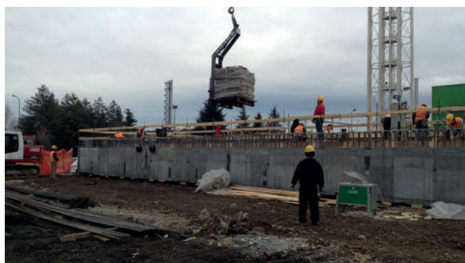
Opere di ultimazione della copertura della vasca
