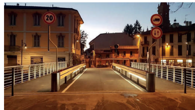
Vista del ponte post intervento
