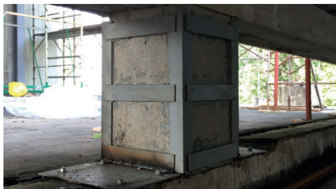
Vista della copertura dell'immobile
