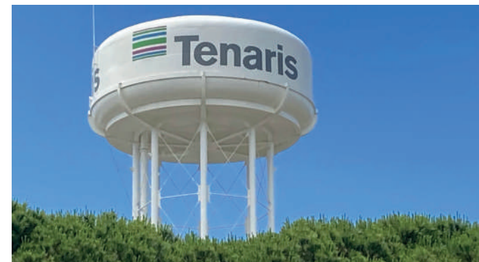
Serbatoio a fine lavori
