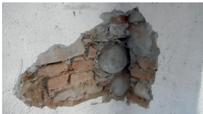
Saggi murari per la valutazione degli ammorsamenti
