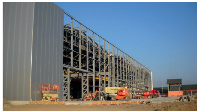
Vista del tamponamento angolare
