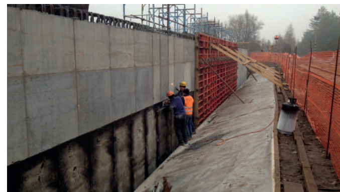
Realizzazione delle pareti verticali in c.a.
