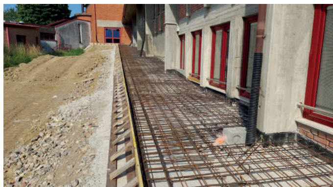
Getto del cordolo in c.a. di rinforzo alle fondazioni
