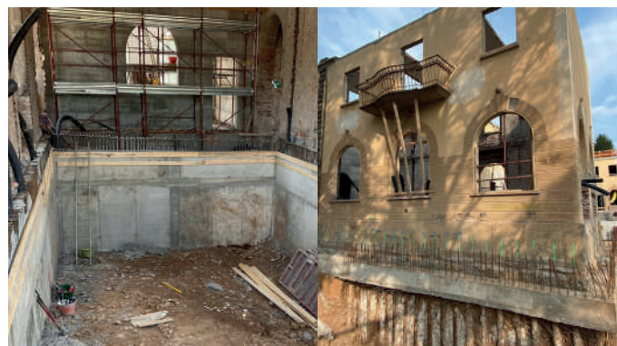
Opere di sottomurazione e di rinforzo fondazionale
