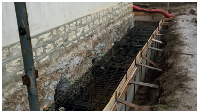
Armatura con cordolo in c.a.
