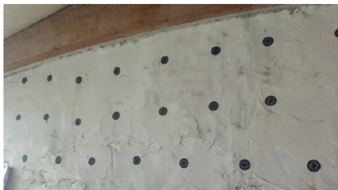
Intervento di rinforzo CFRM sui setti in muratura
