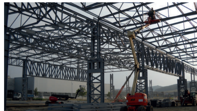
Realizzazione della struttura in carpenteria metallica
