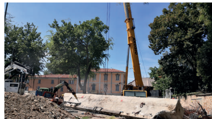
Opere di demolizione del ponte esistente
