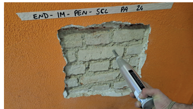
Prova penetrometrica sui giunti di malta
