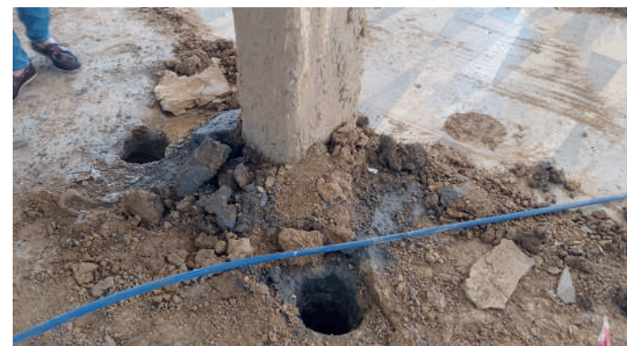
Realizzazione di nuovi micropali di fondazione
