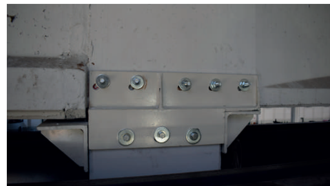
Rinforzo del collegamento tra trave e pilastro
