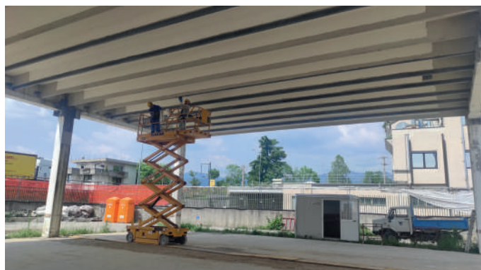
Rinforzo tegoli di copertura con CFRP
