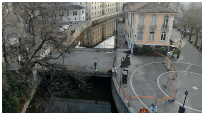
Vista da drone del ponte ante demolizione
