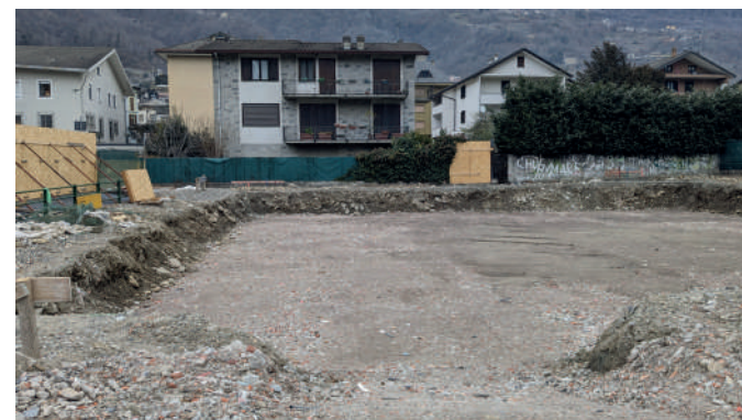
Direzione Lavori dell'attività di scavo
