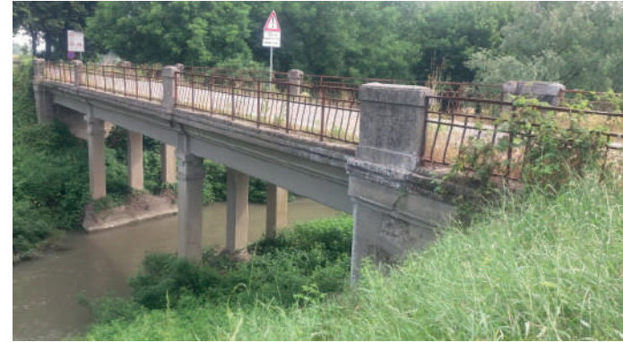
Vista del ponte n.4
