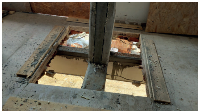
Rinforzo di travi e pilastri esistenti
