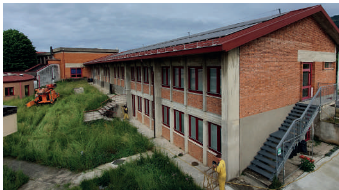
Vista dell'immobile allo stato di fatto
