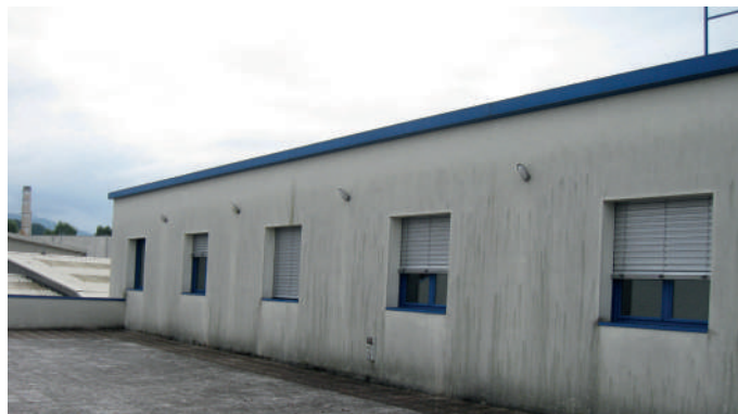
Vista esterna dell'immobile
