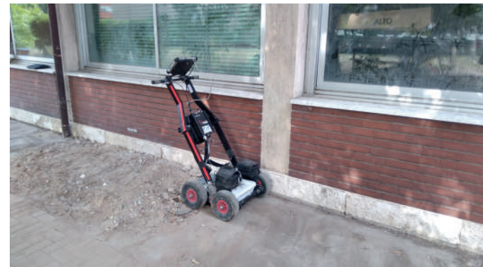
Esecuzione di indagine georadar
