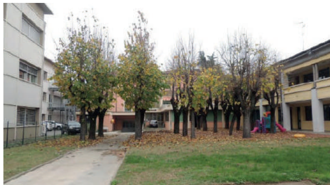
Vista degli esterni del corpo principale della scuola materna
