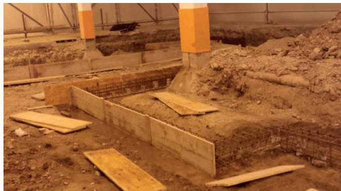
Vista interna del capannone ante intervento
