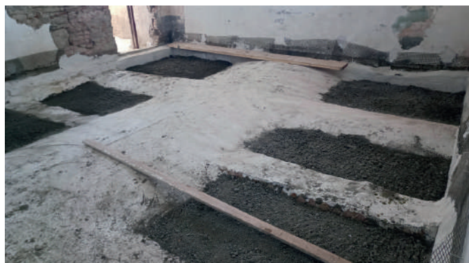
Intervento di rinforzo CFRM delle volte in muratura
