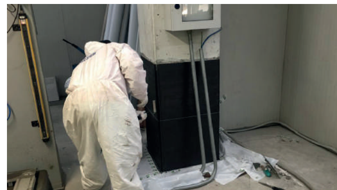
Rinforzo di pilastri prefabbricati esistenti tramite fasciatura
