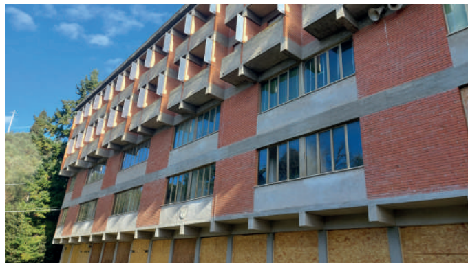
Vista esterna dell'immobile allo stato di fatto
