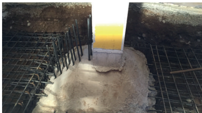
Rinforzo fondazionale dei plinti esistenti
