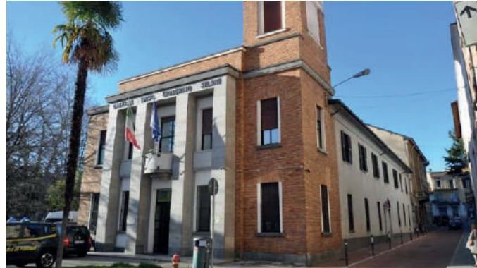
Vista della facciata principale della caserma
