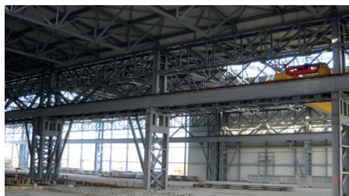
Realizzazione avanzata della struttura in carpenteria metallica
