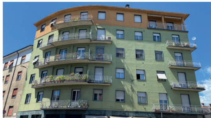
Vista esterna dell'immobile
