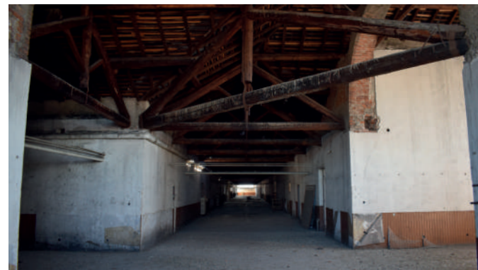
Vista delle capriate oggetto di indagine
