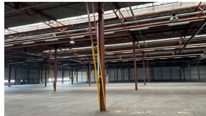
Vista interna del fabbricato
