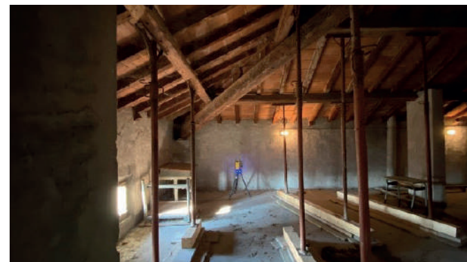
Operazione di rilievo con Laser Scanner
