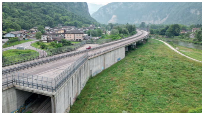
Ispezione tramite drone di infrastruttura ferroviaria
