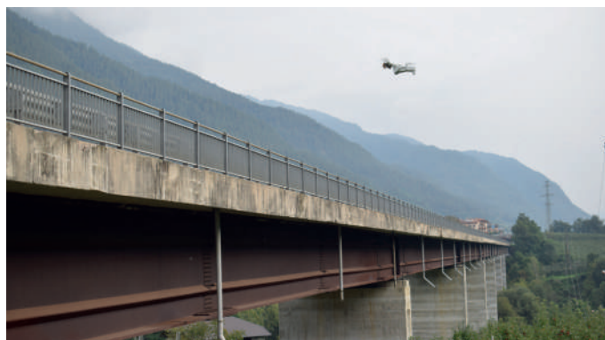
Rilievo fotogrammetrico di manufatto stradale
