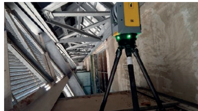
Operazione di rilievo con Laser Scanner
