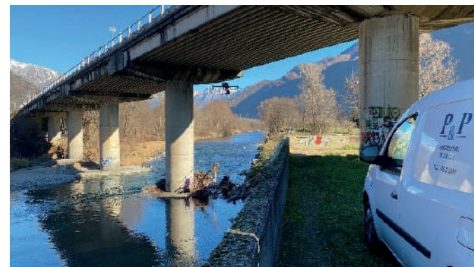
Operazione di rilievo con Laser Scanner
