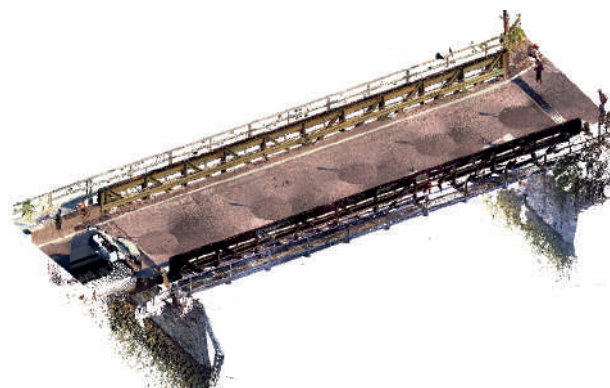
Nuvola di punti dell'estradosso del ponte
