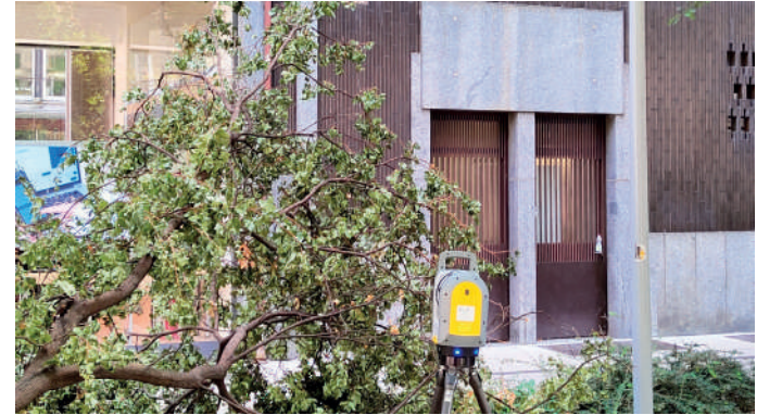
Operazione di rilievo degli esterni dell'immobile
