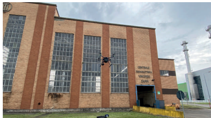
Vista esterna dell'immobile durante il rilievo con drone
