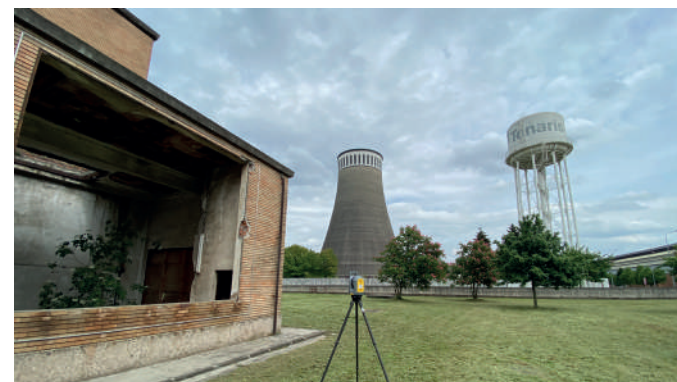
Operazioni di rilievo con Laser Scanner
