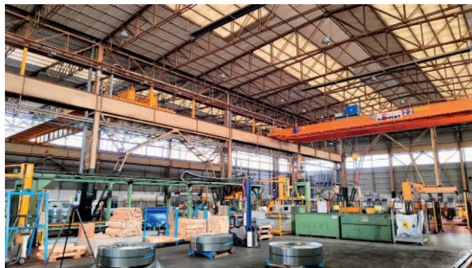
Vista interna del fabbricato
