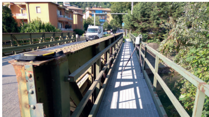
Operazione di rilievo con Laser Scanner
