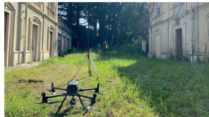
Operazione di rilievo con Laser Scanner
