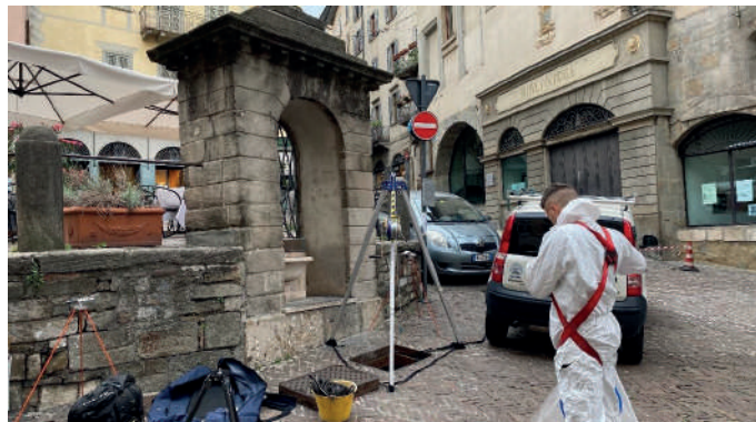
Botola di ingresso del cunicolo
