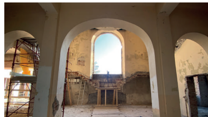
Operazione di rilievo con Laser Scanner
