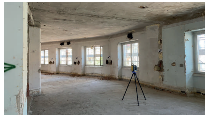
Operazioni di rilievo con Laser Scanner
