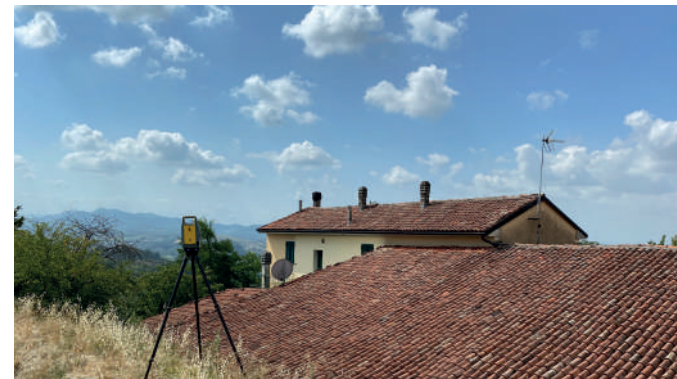
Operazione di rilievo con Laser Scanner
