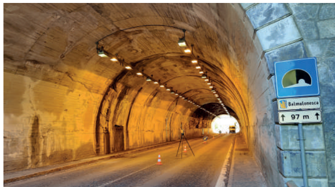
Operazione di rilievo con Laser Scanner
