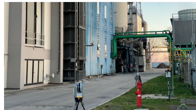
Operazione di rilievo con Laser Scanner
