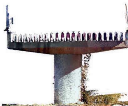
Nuvola di punti di una delle pile del viadotto
