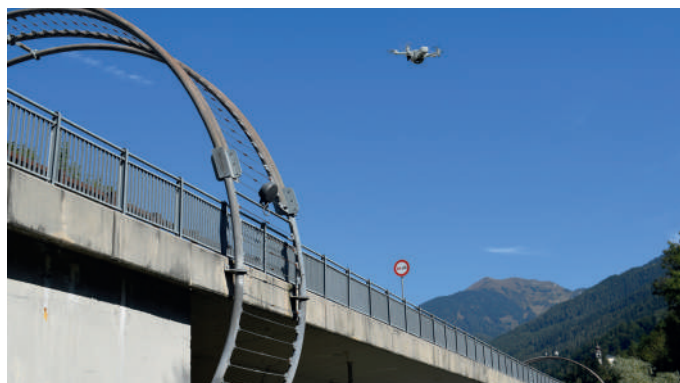
Rilievo fotogrammetrico di manufatto stradale
