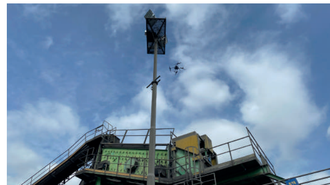
Operazione di rilievo con Laser Scanner
