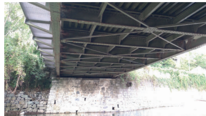
Vista intradossale del ponte
