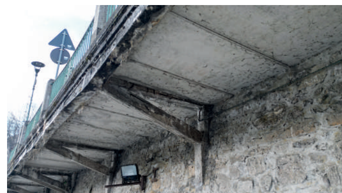
Ispezione tramite drone di marciapiede a sbalzo
