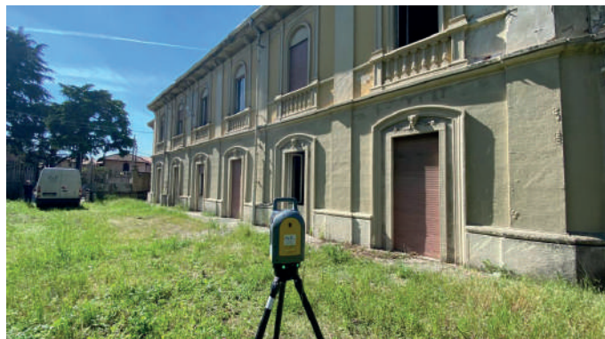
Operazione di rilievo con Laser Scanner
