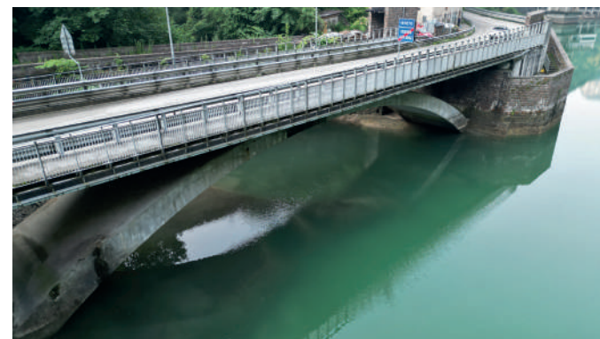
Ispezione tramite drone di infrastruttura stradale
