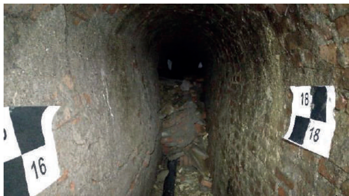
Operazioni di rilievo con il Laser Scanner all'interno del cunicolo
