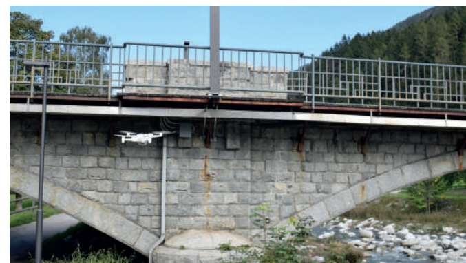
Rilievo fotogrammetrico di manufatto stradale
