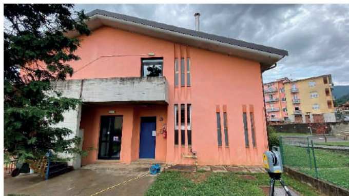
Operazione di rilievo con Laser Scanner
