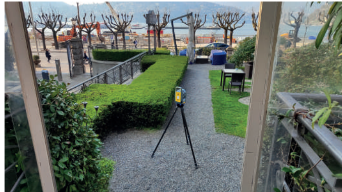
Operazione di rilievo degli esterni dell'immobile
