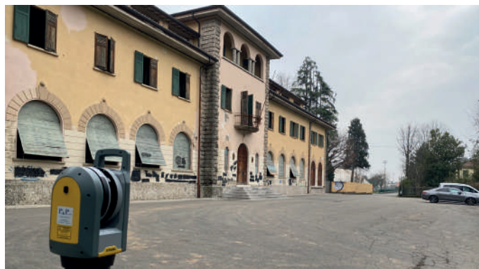
Operazione di rilievo con Laser Scanner
