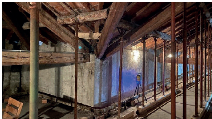
Operazione di rilievo con Laser Scanner
