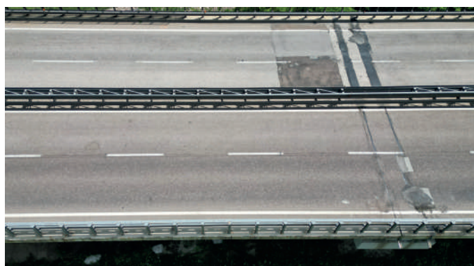
Ispezione tramite drone di impalcato stradale
