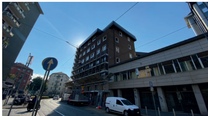
Vista esterna dell'immobile
