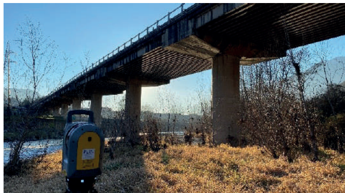
Operazione di rilievo con Laser Scanner
