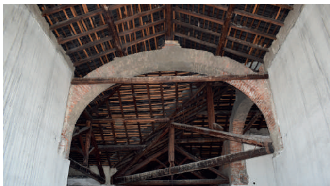
Vista delle capriate oggetto di indagine
