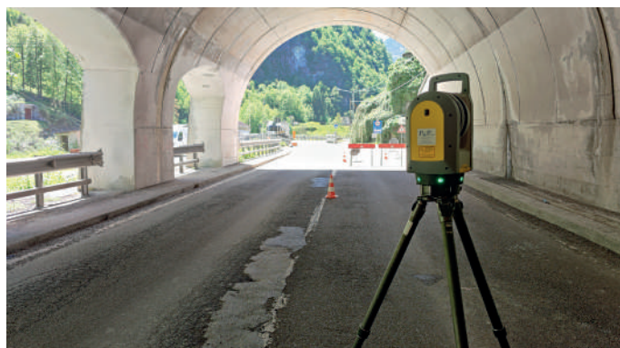
Operazione di rilievo con Laser Scanner
