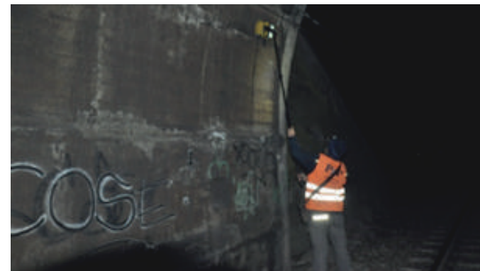
Esecuzione di indagine georadar
