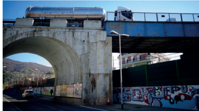
Vista d'insieme del ponte
