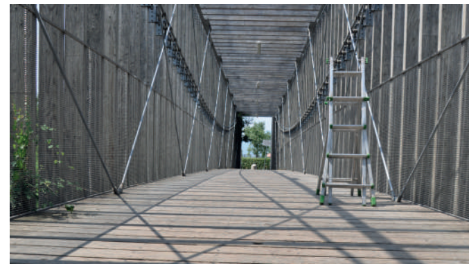
Vista dell'impalcato della passerella
