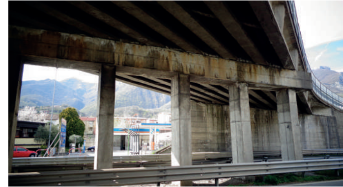
Vista intradossale del ponte
