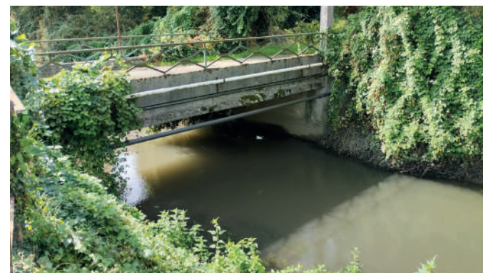
Ripresa fotografica da drone su ponte oggetto di censimento
