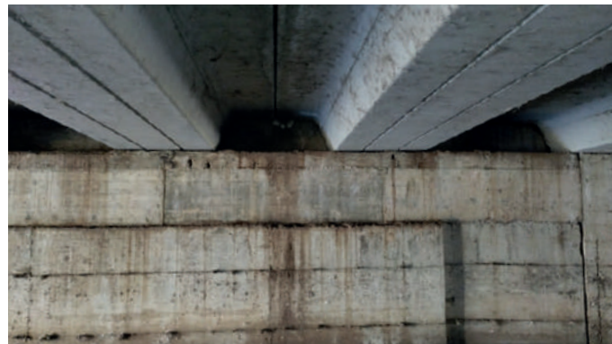
Vista di dettaglio delle travi prefabbricate
