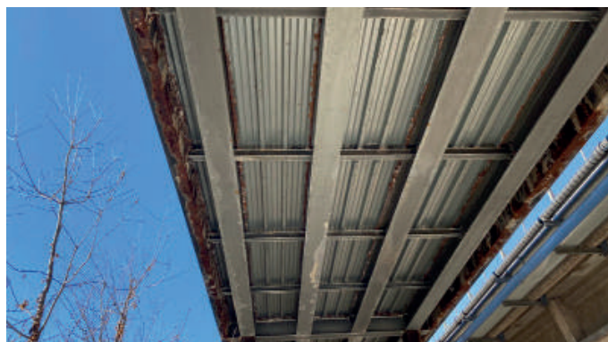
Rilievo del degrado dei cosciali
