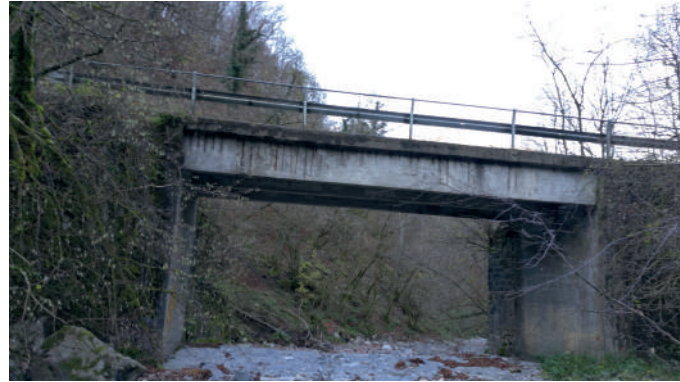
Vista d'insieme del ponte
