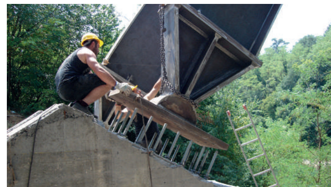
Fissaggio degli archi alla fondazione
