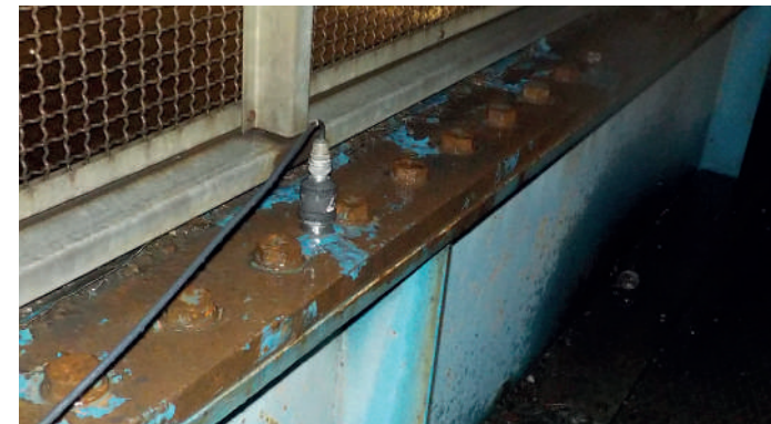
Strumenti di misura posizionati
