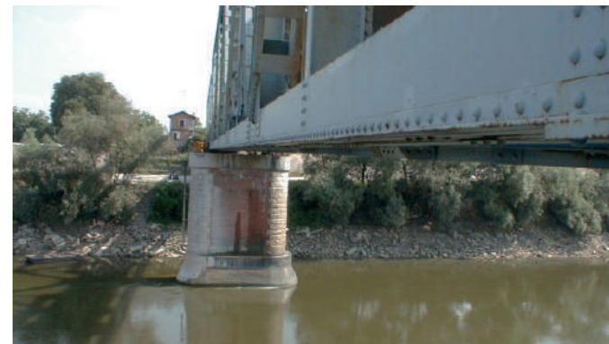
Vista di una pala oggetto di indagini
