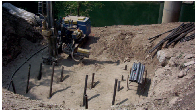
Infissione di micropali nel terreno
