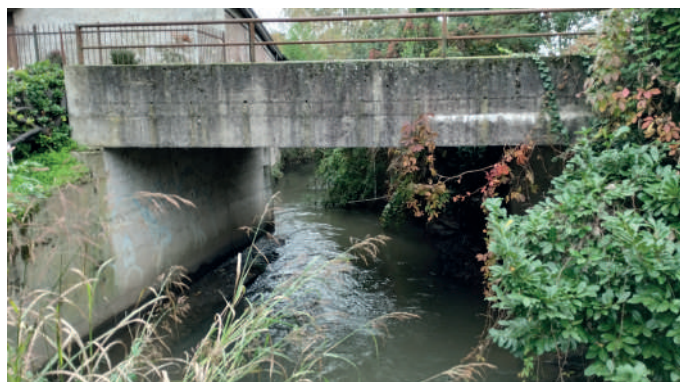
Ripresa fotografica da drone su ponte oggetto di censimento
