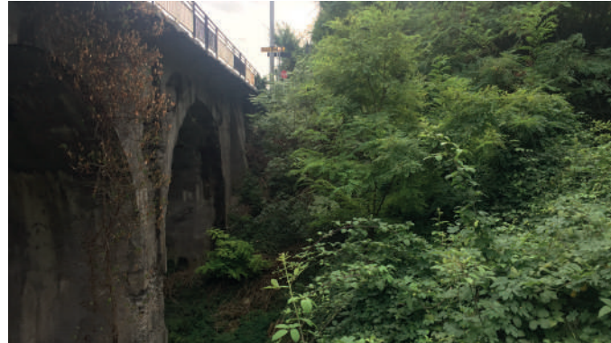
Vista d'insieme del ponte
