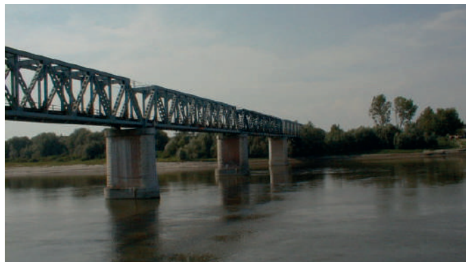
Vista d'insieme del ponte
