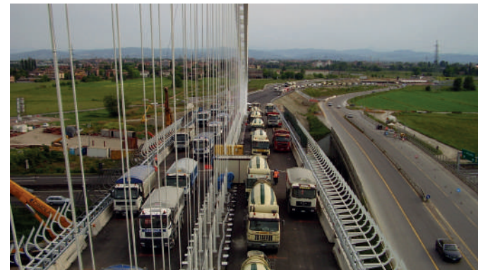
Prova di carico globale
