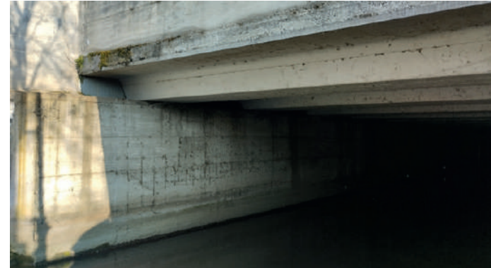
Vista di dettaglio della spalla
