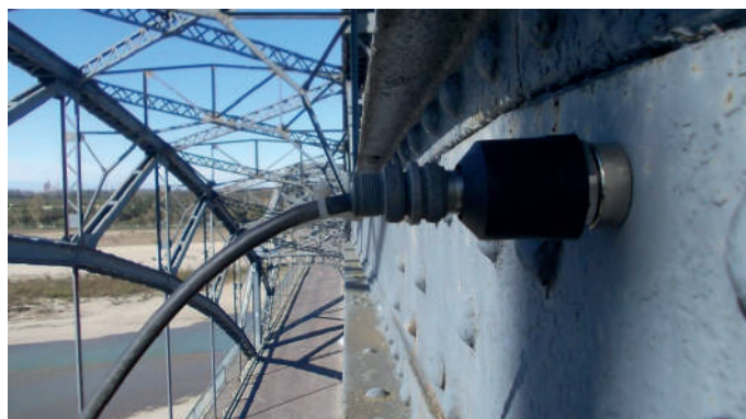
Dettaglio dell'accelerometro di misura su arco
