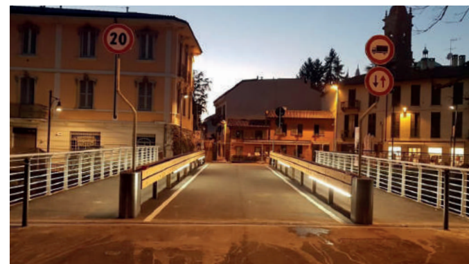
Nuovo ponte a lavori ultimati
