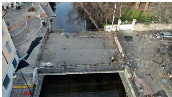
Vista da drone del ponte esistente
