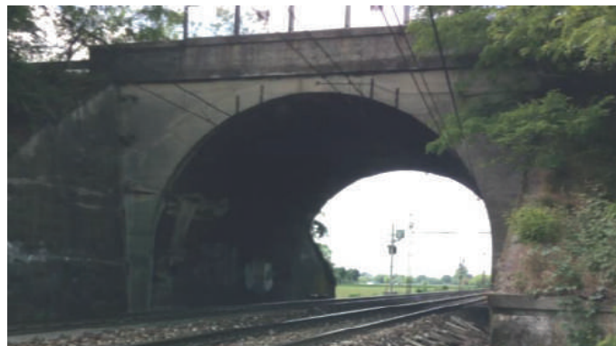
Vista del ponte dal sedime ferroviario
