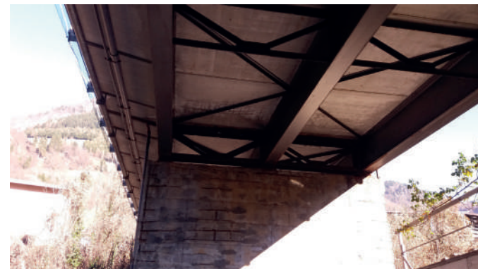
Vista intradossale dell'impalcato
