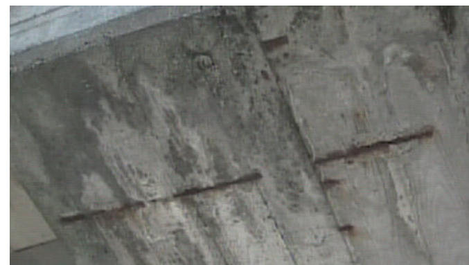
Barre a vista prima degli interventi
