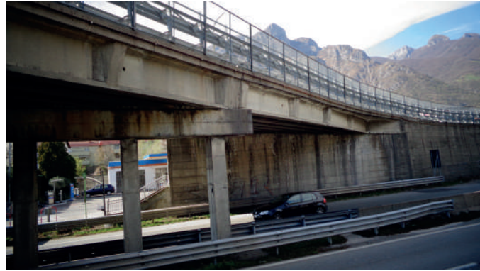
Vista d'insieme del ponte
