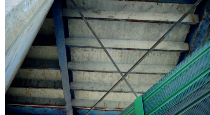
Vista intradossale del ponte
