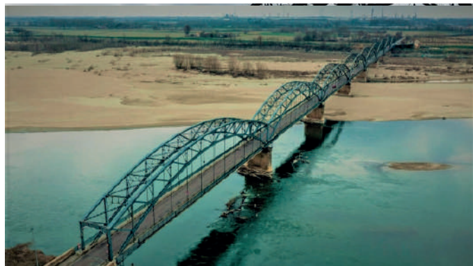
Vista d'insieme del ponte
