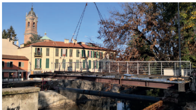
Posa del nuovo ponte
