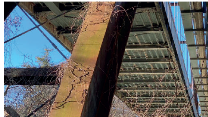
Vista dell'intradosso dell'impalcato
