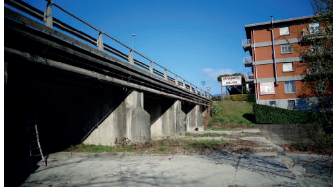
Vista d'insieme del ponte
