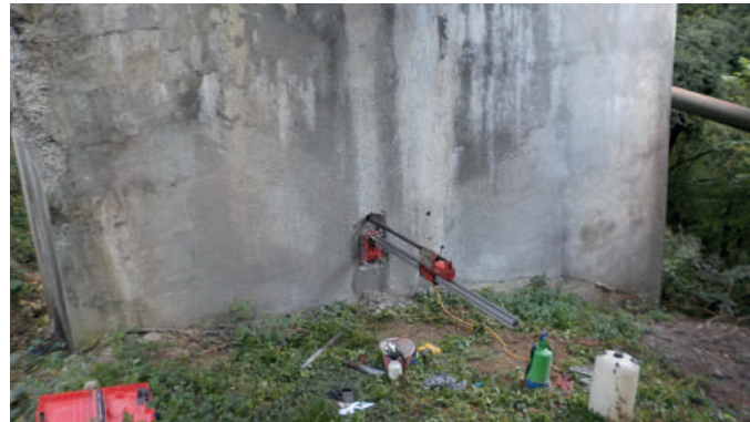
Esecuzione di carotaggio su pila in c.a.
