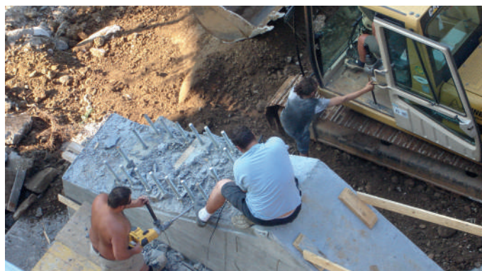
Posa della piastra di fissaggio degli archi
