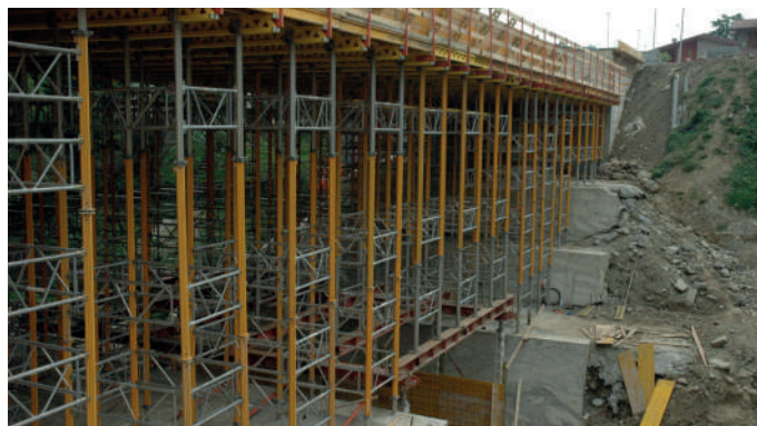
Opera di puntellazione per il getto
