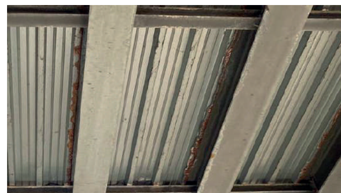
Rilievo del degrado della passerella metallica
