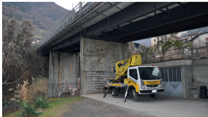
Vista d'insieme del ponte
