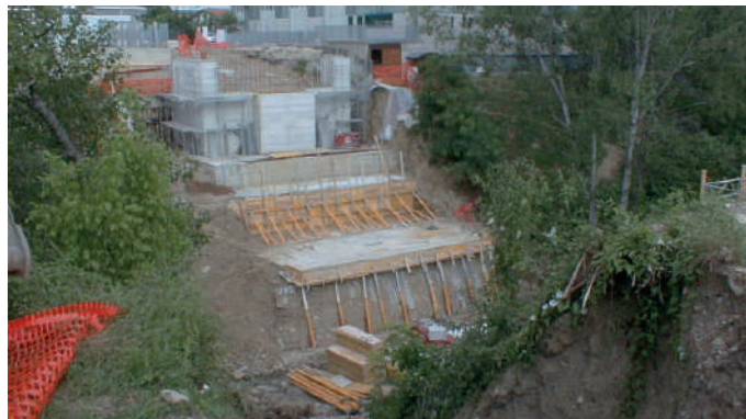
Realizzazione delle spalle
