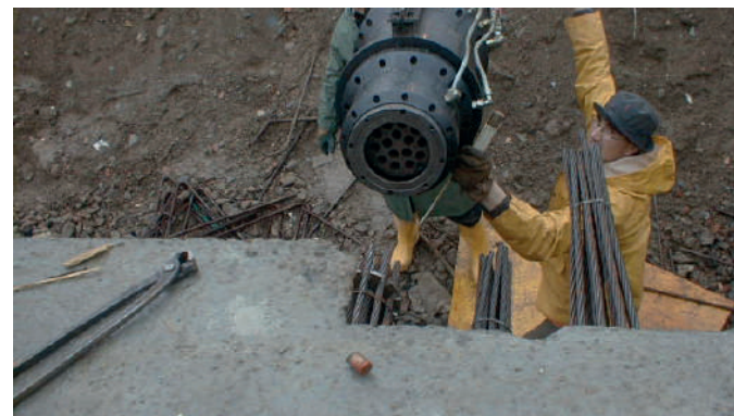
Messa in tensione dei trefoli
