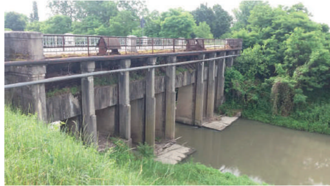
Vista del ponte n.1
