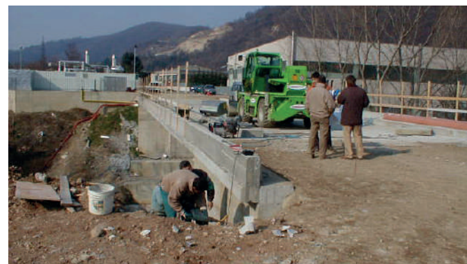
Ponte a lavori quasi ultimati
