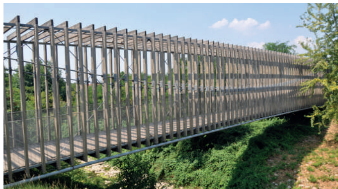
Vista d'insieme della passerella
