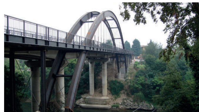
Passerella a lavori ultimati
