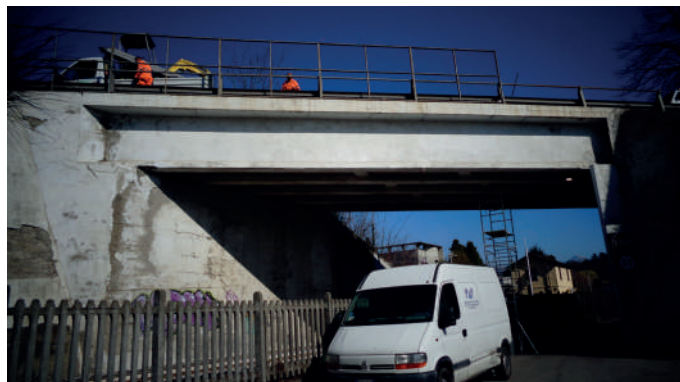
Vista d'insieme del ponte
