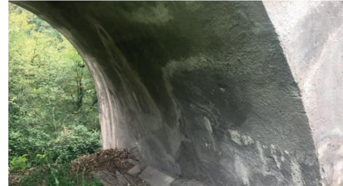
Vista intradossale di un'arcata del ponte
