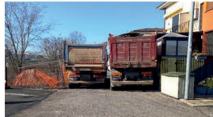
Prova di carico con automezzi sull'impalcato
