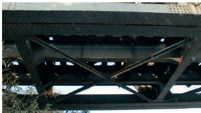
Struttura portante dell'impalcato
