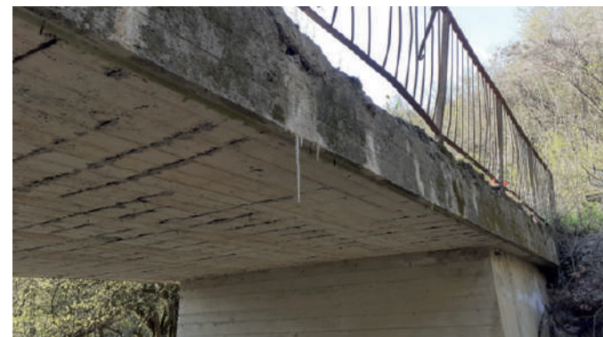
Vista dell'intradosso dell'impalcato
