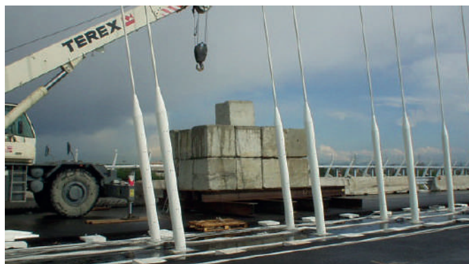
Prova di carico locale
