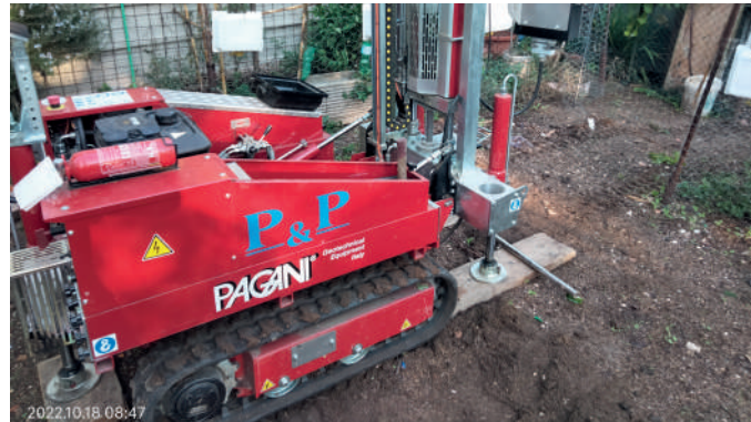
Esecuzione di indagini geognostiche
