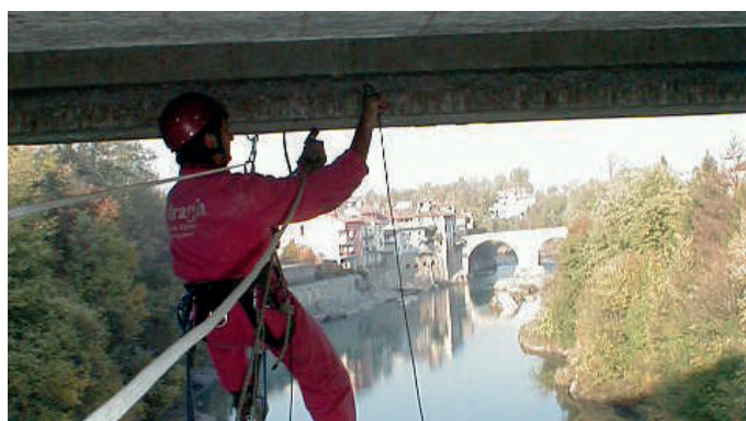
Esecuzione di una prova sinica
