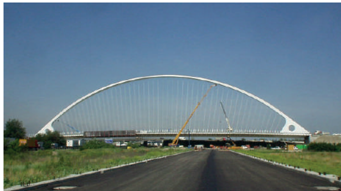
Vista d'insieme del ponte
