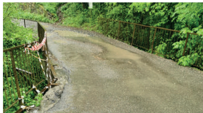
Vista dell'estradosso dell'impalcato
