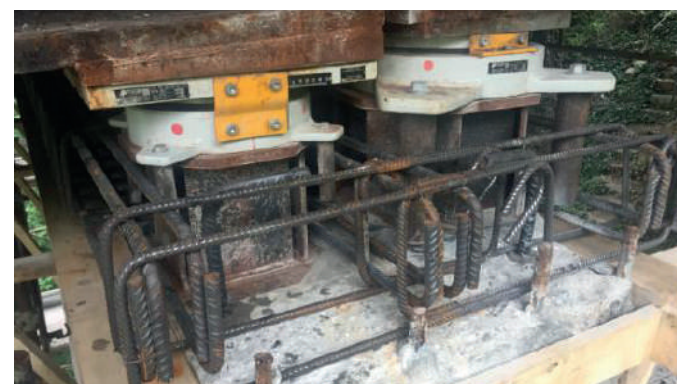
Realizzazione di nuovi baggioli
