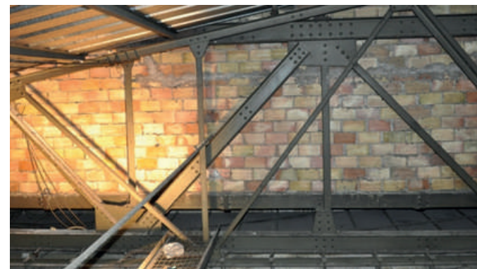
Vista della struttura della passerella lato ANAS
