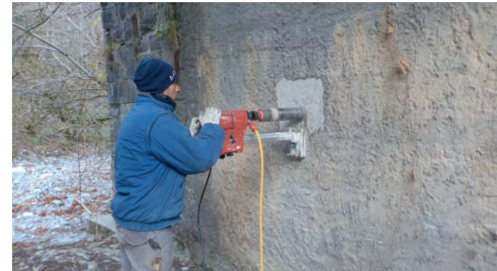
Esecuzione di carotaggio su spalla in c.a.
