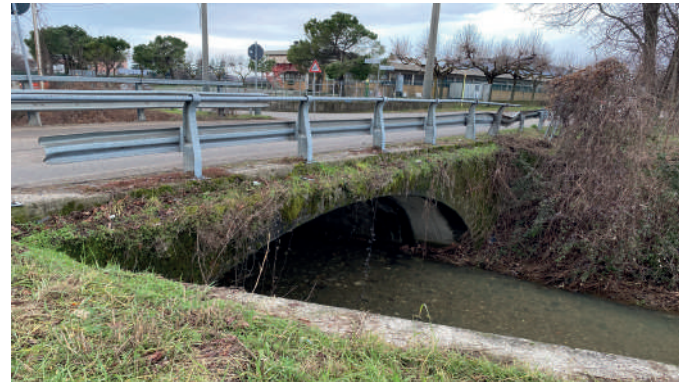
Vista del ponte
