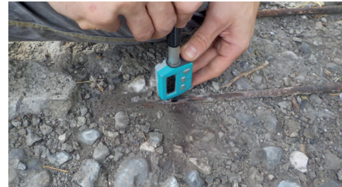
Prova con durometro su barra d'armatura
