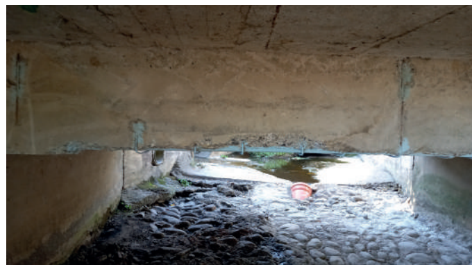
Opere di passivazione delle armature delle travi in c.a.
