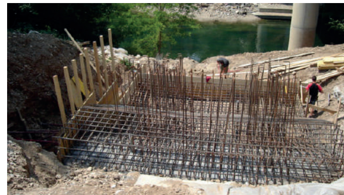
Posa di ferri di armatura per le fondazioni
