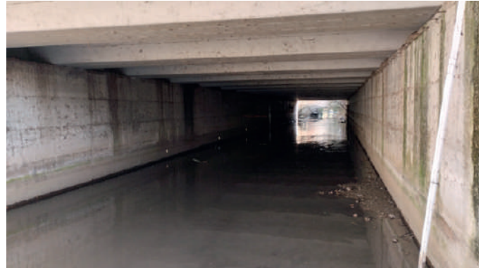
Vista dell'intradosso del ponte
