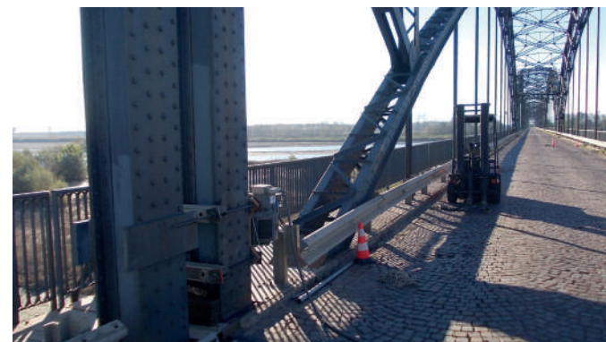
Posizione della vibrodina per l'esecuzione di prova dinamica
