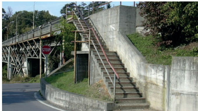
Vista del ponte
