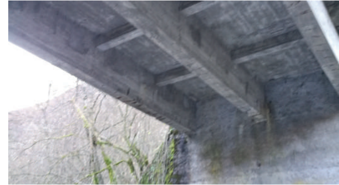
Vista intradossale del ponte
