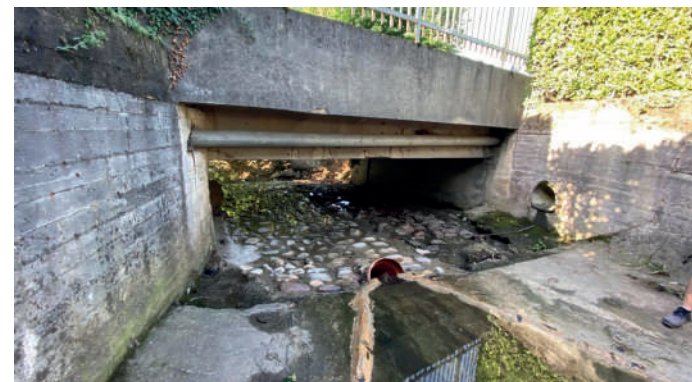
Intervento di ripristino del fondo dell'alveo
