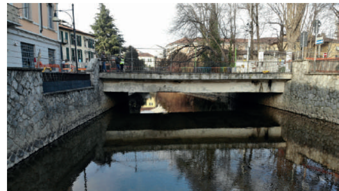
Vista da drone del ponte esistente
