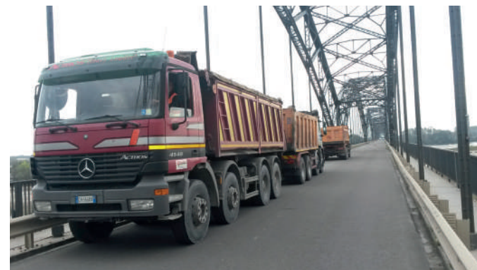
Prova di carico con autocarri
