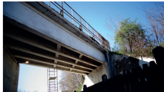
Vista intradossale del ponte
