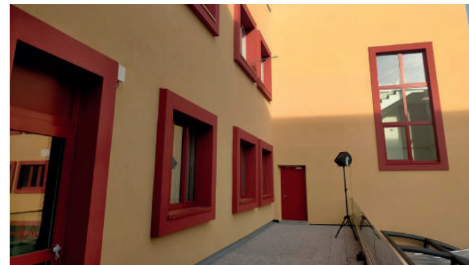
Misura del potere fonoisolante di facciata
