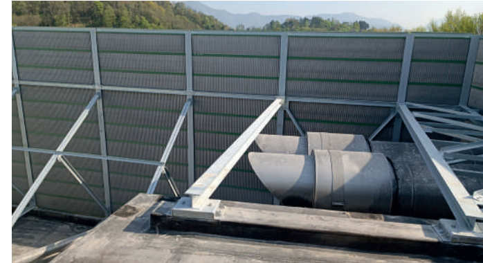
Barriera acustica di nuova realizzazione
