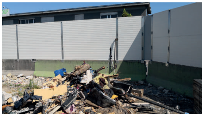
Postazione di misura fonometrica al confine del cantiere
