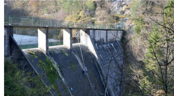
*Istallazione delle accelerometri sulla diga*
