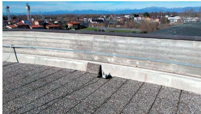
*Posizione di accelerometro in copertura*
