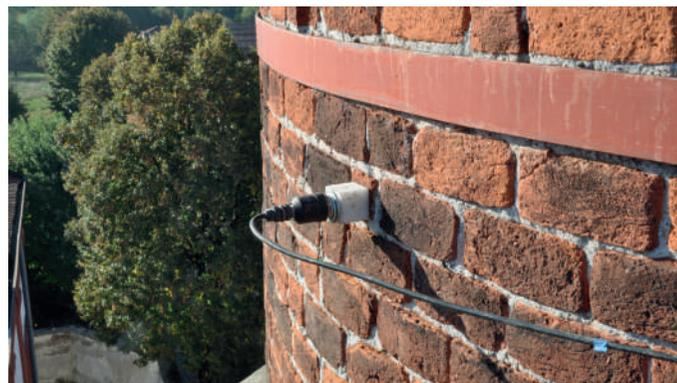
*Dettaglio dell'ancoraggio dell'accelerometro*
