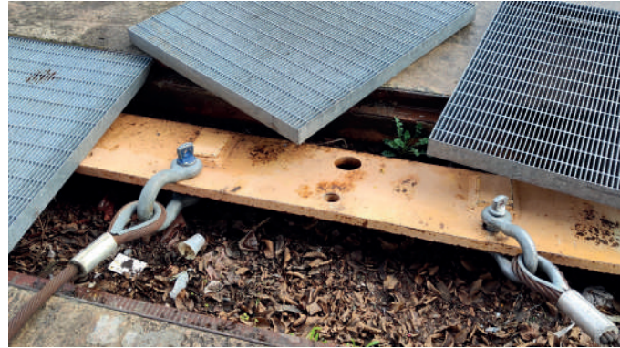
Vista della piastra di ancoraggio
