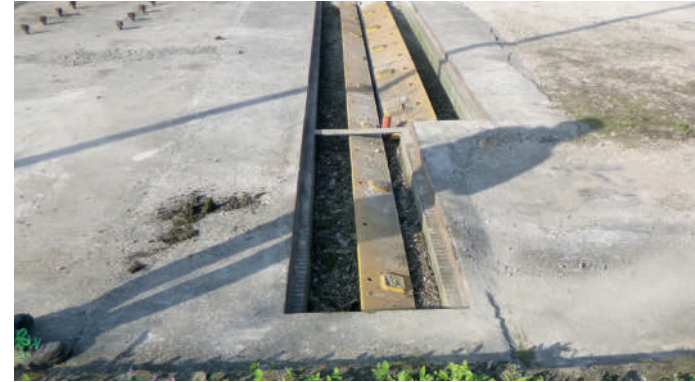
Vista della piastra di ancoraggio
