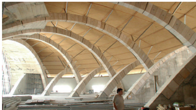
Vista d'insieme della copertura
