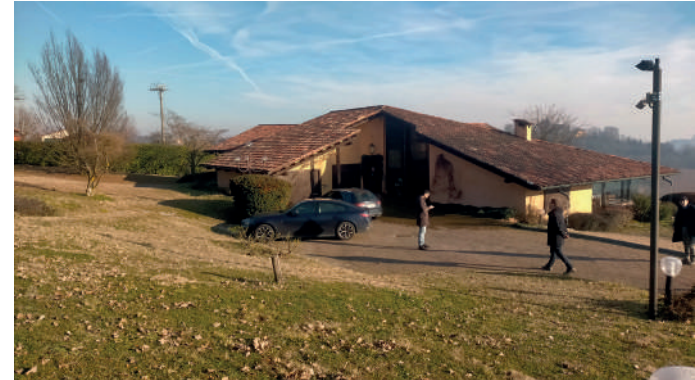
Edificio in prossimità del cantiere
