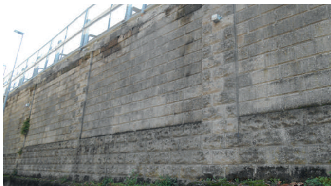
Muro della rampa d'accesso al cavalcavia
