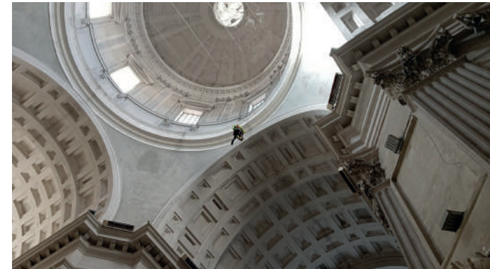
Installazione di fessurimetro ad opera di operatore su fune
