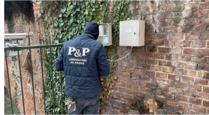
Fase di installazione strumentazione
