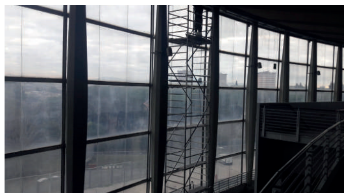
Fasi installazione strumentazione quota copertura
