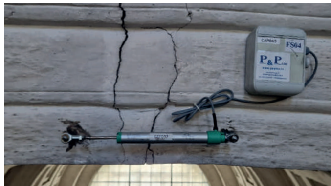
Posizione di fessurimetro
