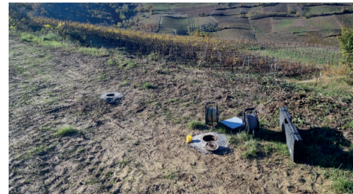
Frana nel Comune di Codevilla
