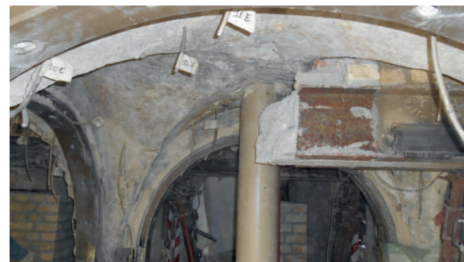
Demolizione della preesistente struttura di consolidamento
