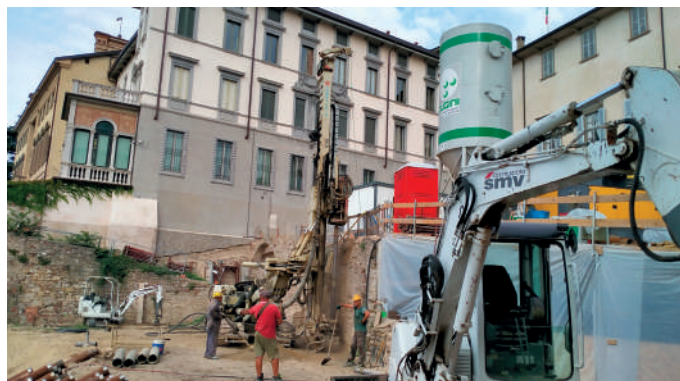
Vista d'insieme del cantiere
