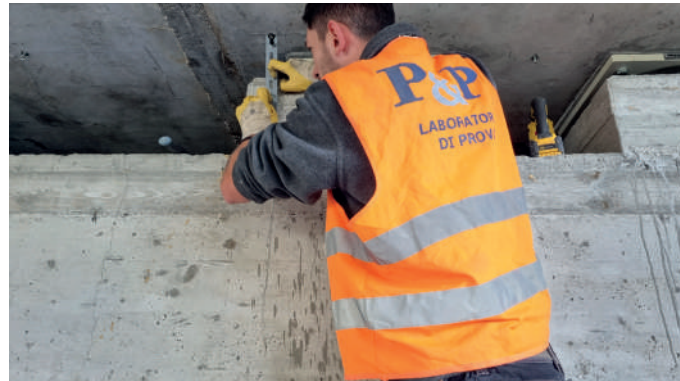
Fasi installazione della strumentazione
