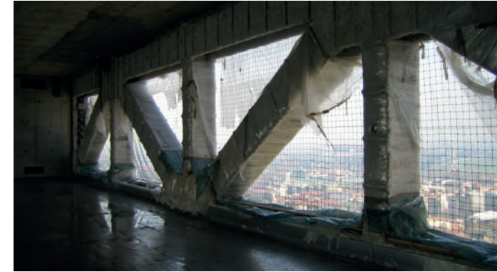
Belt Truss – Vista d'insieme
