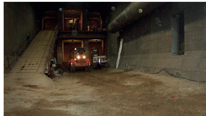
Opere di scavo del passante
