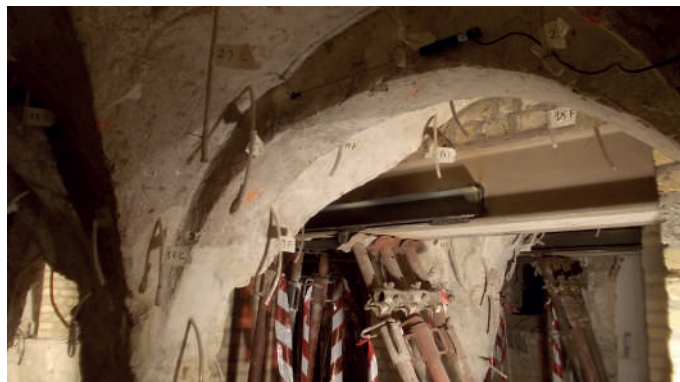
Monitoraggio fessurimetrico preliminare
