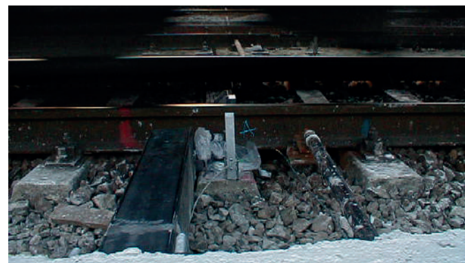
Acquisizione durante il transito di convoglio ferroviario
