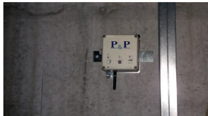
Inclinometro su vano ascensore centrale
