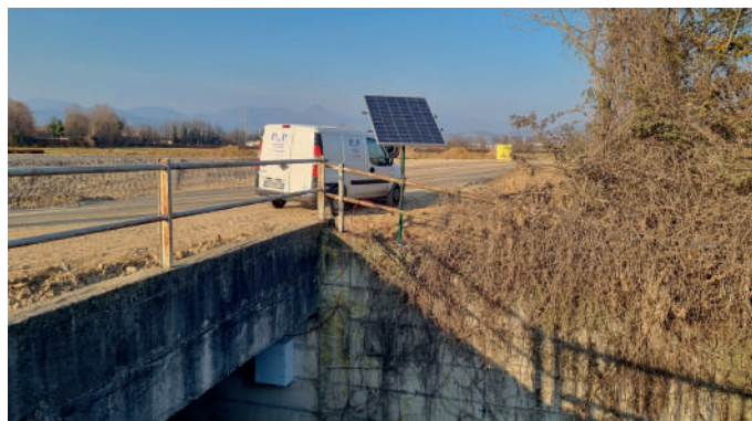
Vista d'insieme ingresso tombotto
