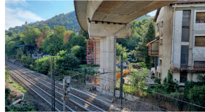
Vista della pila P14
