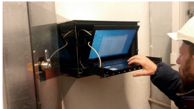
Test del sistema di monitoraggio estensimetrico
