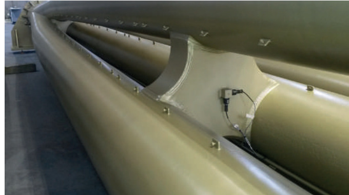
Fase di installazione e test strumentazione
