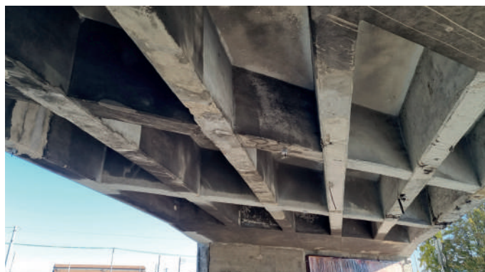
Vista dell'intradosso dell'impalcato
