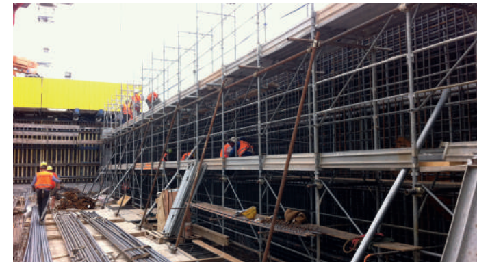
Trave di coronamento – Vista d'insieme
