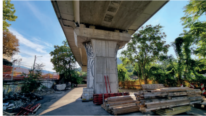
Vista della pila P12
