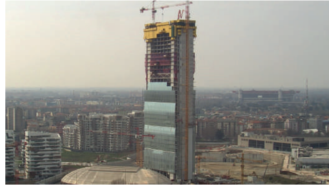
Vista d'insieme dell'edificio in fase di costruzione
