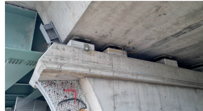
Dettaglio installazione pila P3
