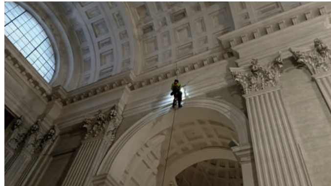
Installazione di fessurimetro ad opera di operatore su fune
