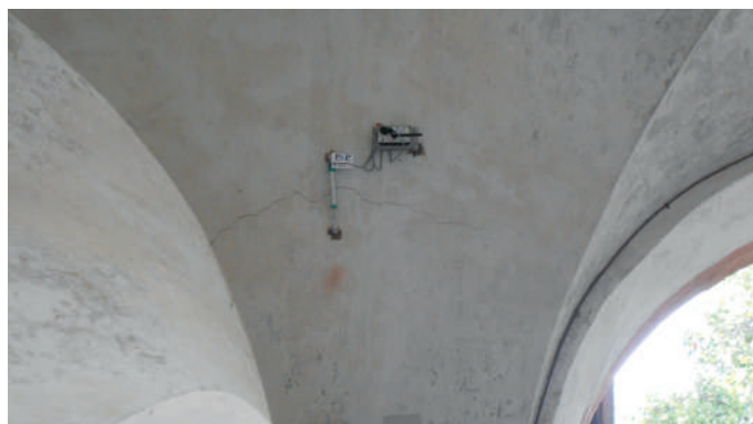
Monitoraggio lesione su una volta
