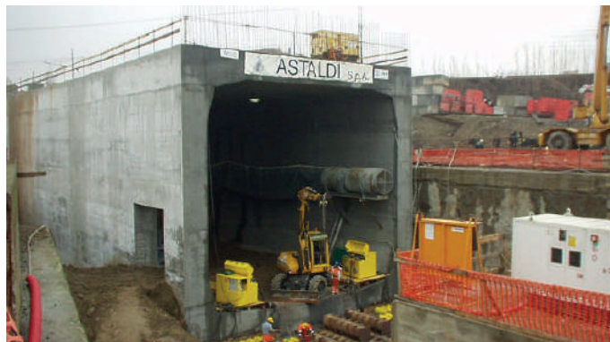
Monolite in fase di infissione
