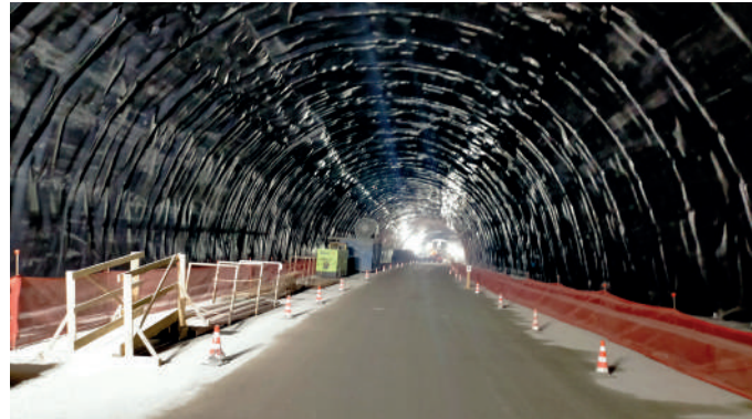
Vista interna della galleria
