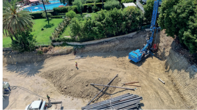
Vista aerea dell'area di cantiere
