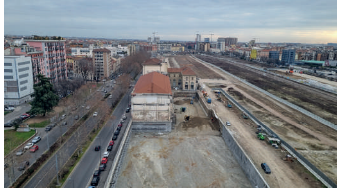
Vista aerea dell'area di cantiere
