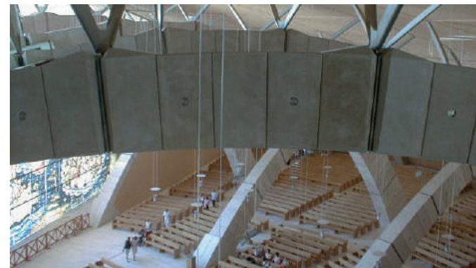
Vista ravvicinata della copertura
