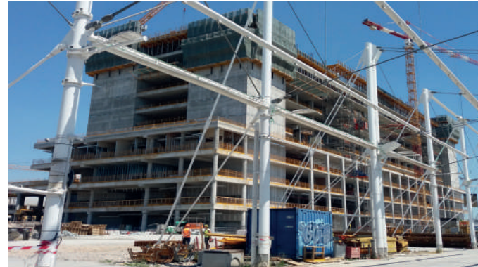
Vista d'insieme dell'edificio in fase di costruzione
