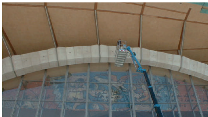
Fase di installazione della strumentazione
