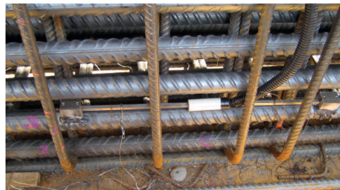
Trave di coronamento – Estensimetri in fase di installazione
