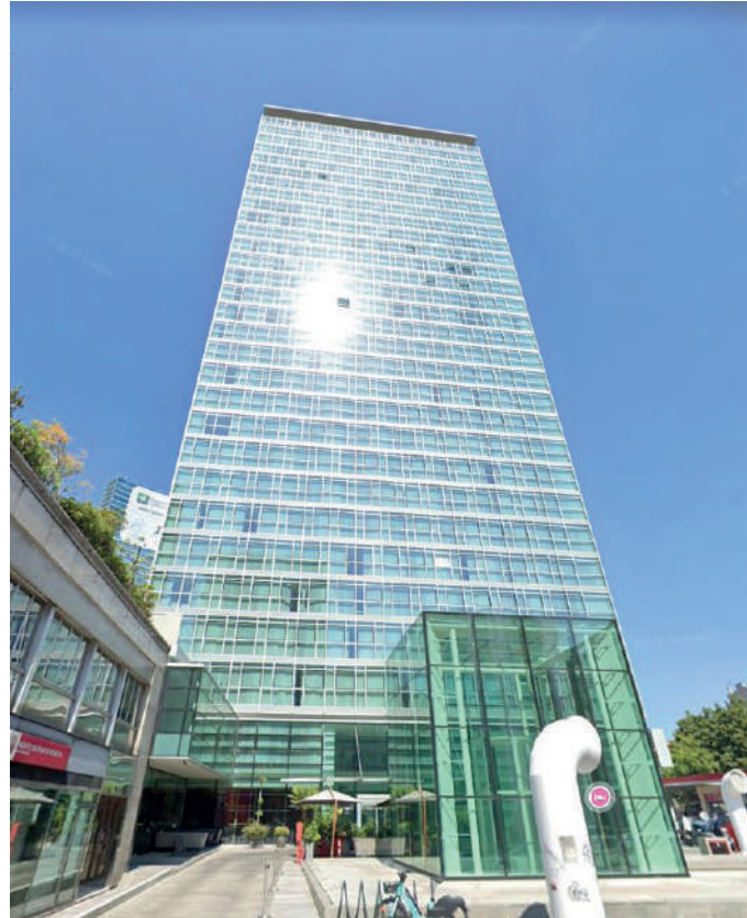
Vista d'insieme della Torre Galfa
