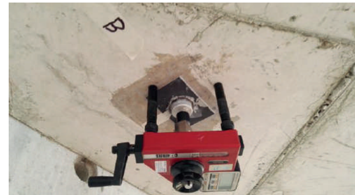
Fissaggio dello strumento di applicazione del carico
