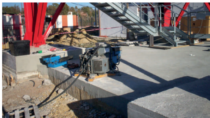
Posizionamento della vibroдина per prova dinamica
