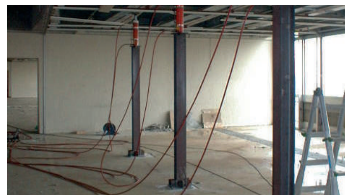
Applicazione del carico tramite martinetti idraulici
