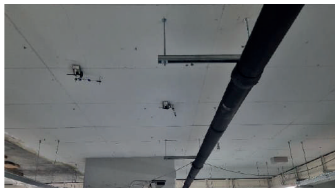
Monitoraggio fessurimetrico di solaio
