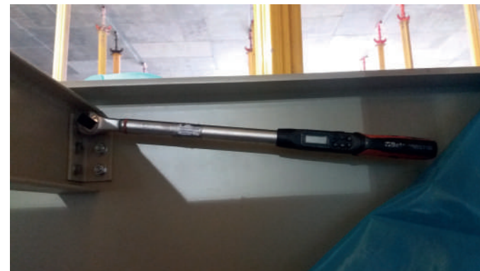
Verifica della coppia di serraggio dei bulloni
