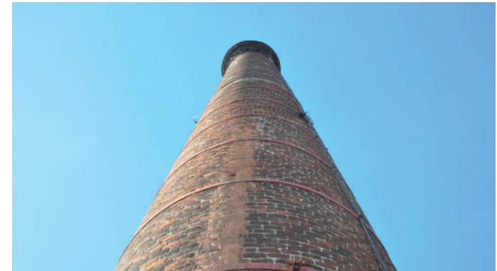
Posizione di accelerometri sulla ciminiera
