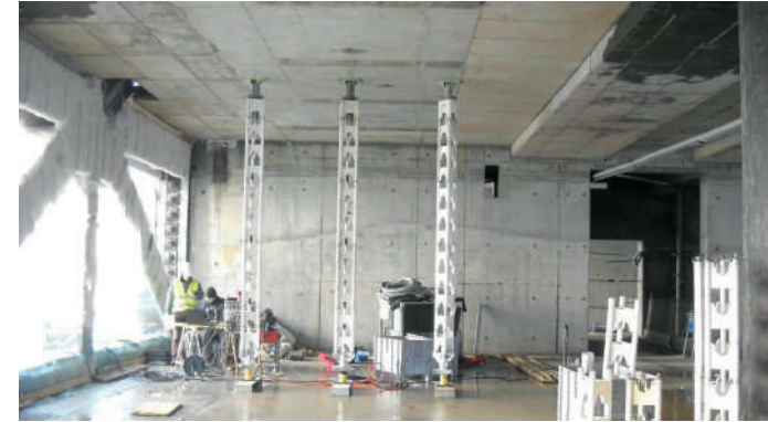
Prova di carico su solaio con pistoni
