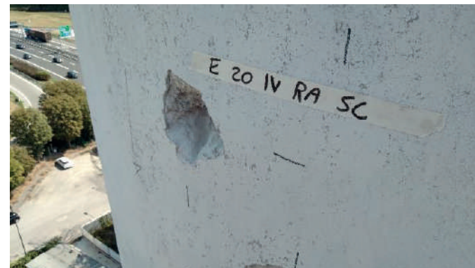
Saggio per misura diretta dell'armatura
