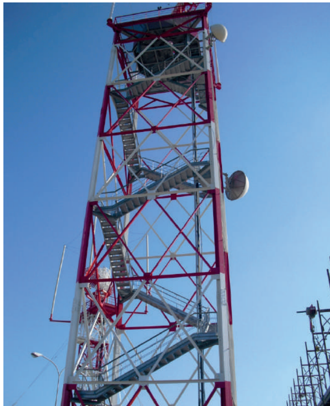
Vista d'insieme della torre radar
