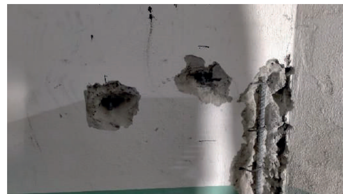
Scasso per prelievo di barra d'armatura
