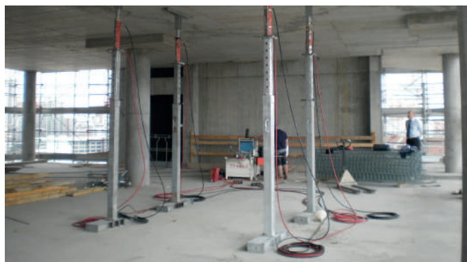
Prova di carico su solaio
