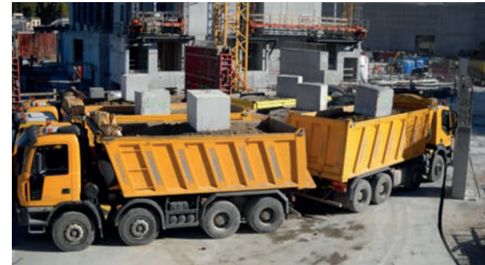
Prova di carico su solaio con autocarri
