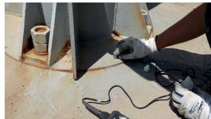
Misura spessimetrica delle carpenterie metalliche
