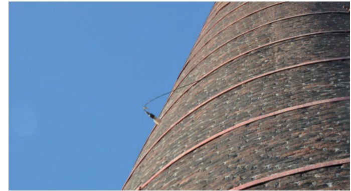
Posizione di accelerometro sulla ciminiera
