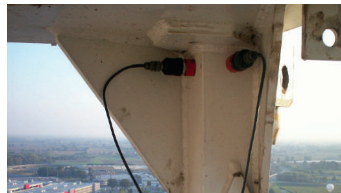
Installazione di accelerometri su elementi di carpenteria
