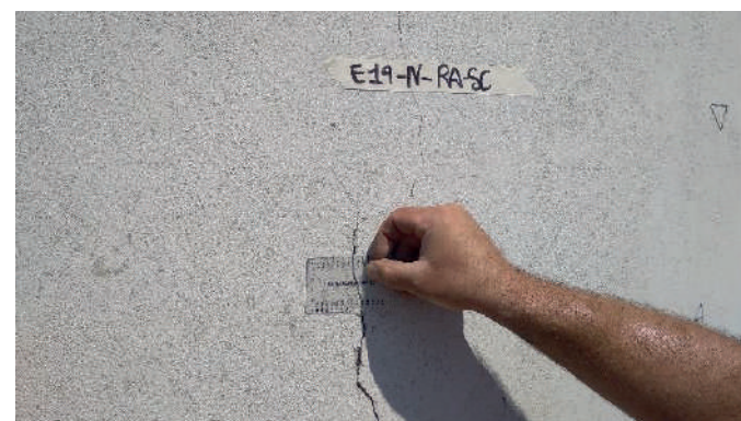
Rilievo fessurimetrico
