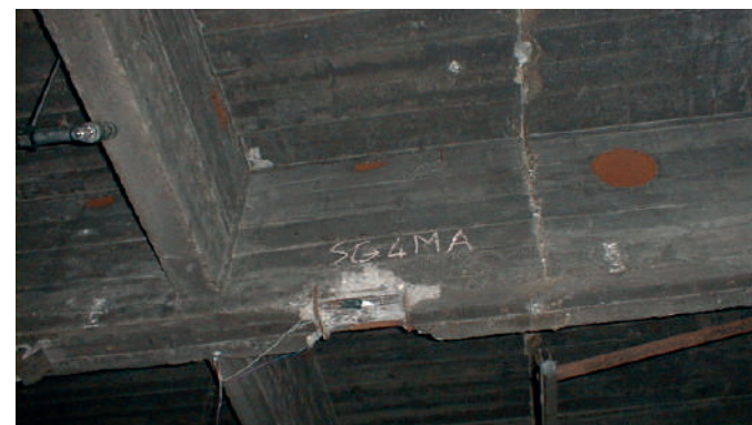
Misura di sollecitazione tramite sensore di deformazione
