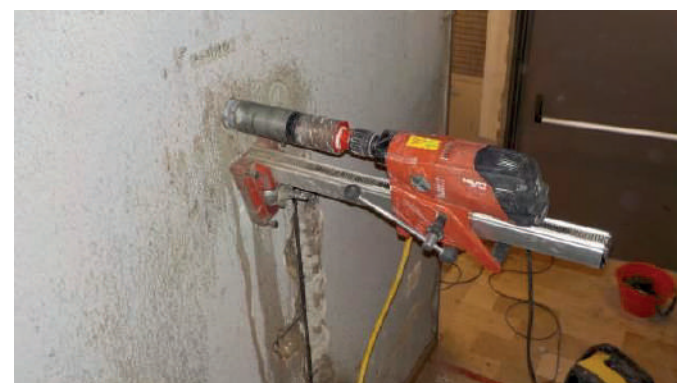
Carotaggio per prova di compressione sul calcestruzzo
