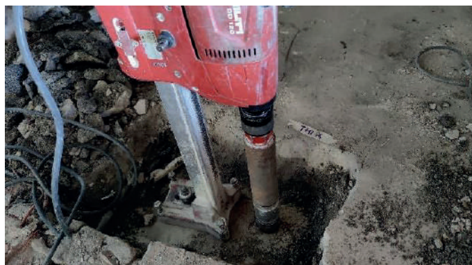
Esecuzione di carotaggi per prova di trazione
