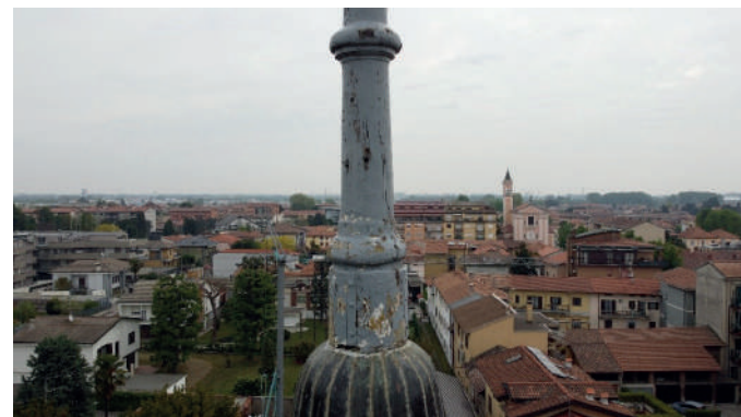
Vista della struttura lignea sommitale della torre
