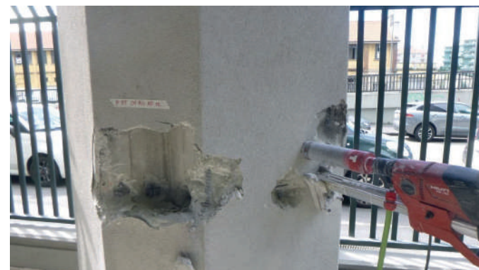
Carotaggio per prova di compressione sul calcestruzzo
