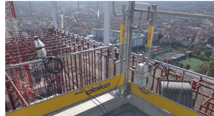
Posizione di accelerometro sulla copertura dell'edificio
