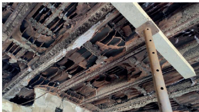
Analisi visiva sui solai
