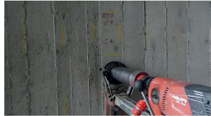
Esecuzione di carotaggio per prova di compressione
