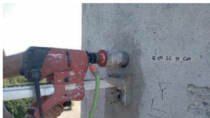
Carotaggio per prova di compressione del cls
