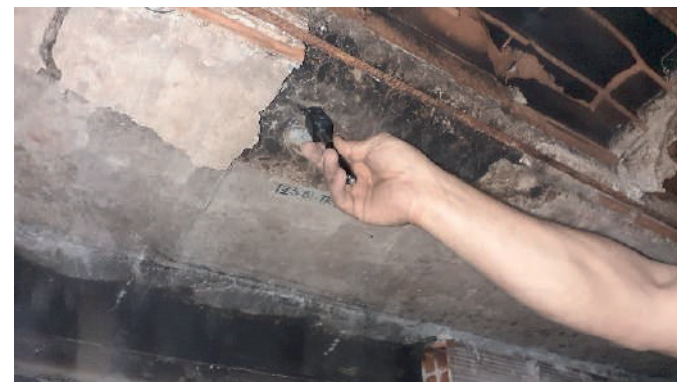
Indagine durometrica su barre d'armatura
