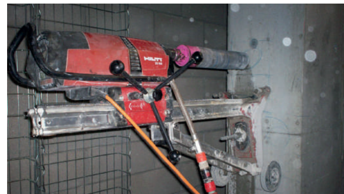
Carotaggio per prova di compressione sul calcestruzzo
