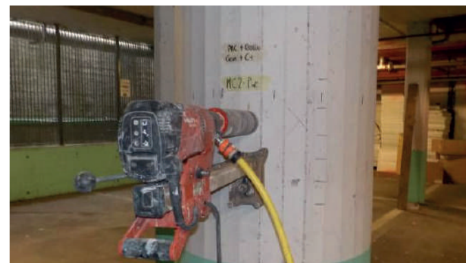
Carotaggio per prova di compressione sul calcestruzzo
