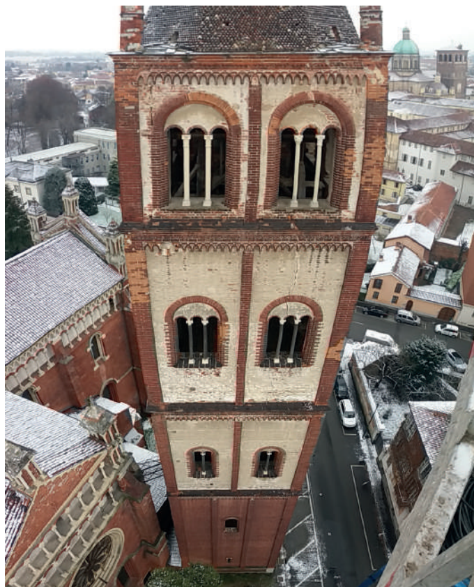
Vista esterna della torre campanaria
