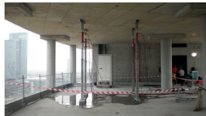
Prova di carico su solaio
