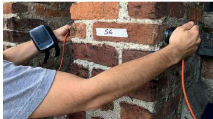
Indagine sonica su colonna in muratura
