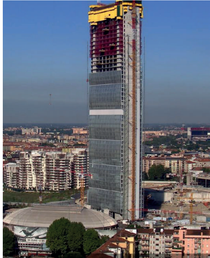
Vista dell'immobile in fase di costruzione
