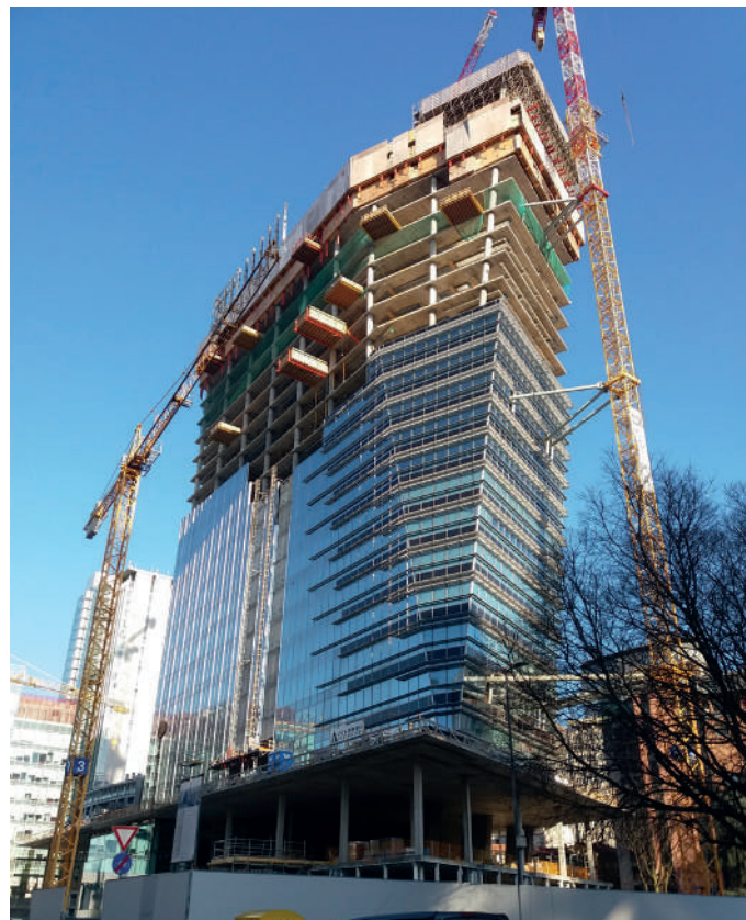
Vista dell'immobile in fase di costruzione
