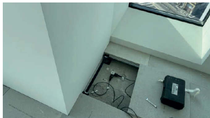
Posa di accelerometro per prova dinamica
