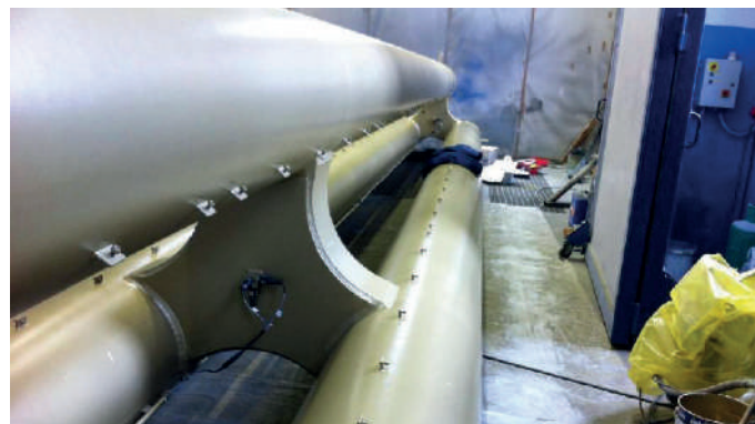
Accelerometro per monitoraggio dinamico dei puntoni
