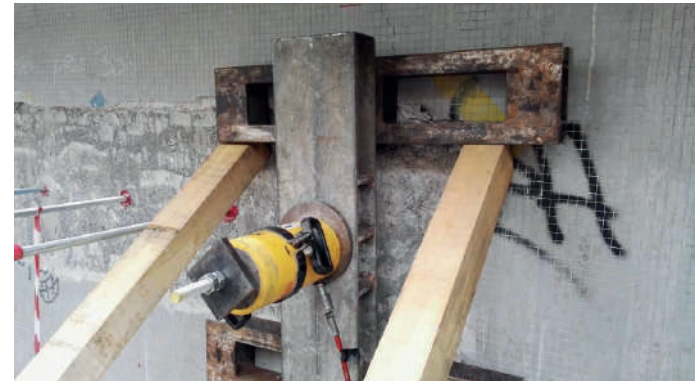
Fissaggio dello strumento di applicazione del carico
