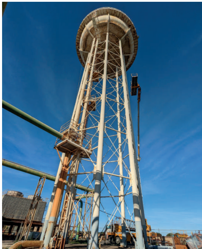
Vista d'insieme del serbatoio pensile
