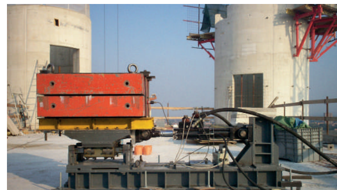
Installazione di vibrodina sulla copertura
