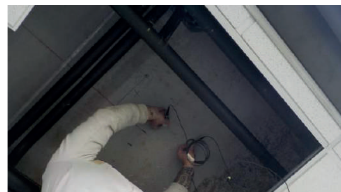
Indagine sonica su solaio in c.a.
