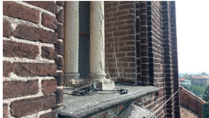
Posizione di accelerometro
