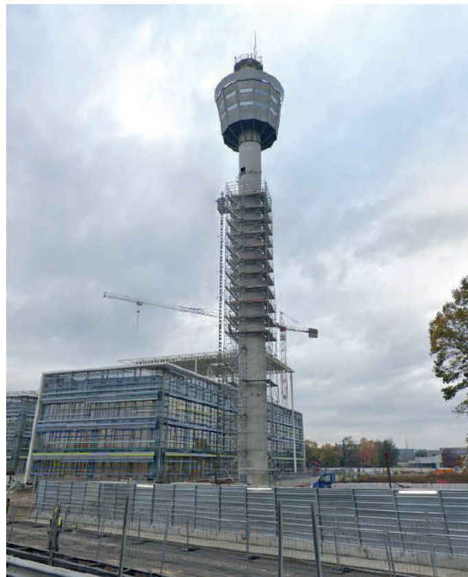
Vista d'insieme della Torre della Telettra
