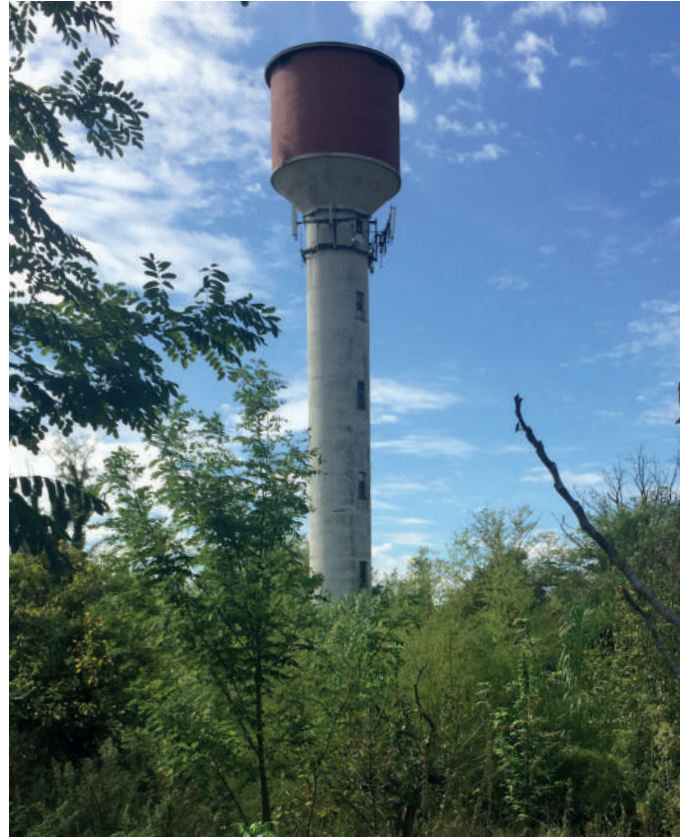
Vista d'insieme del serbatoio pensile
