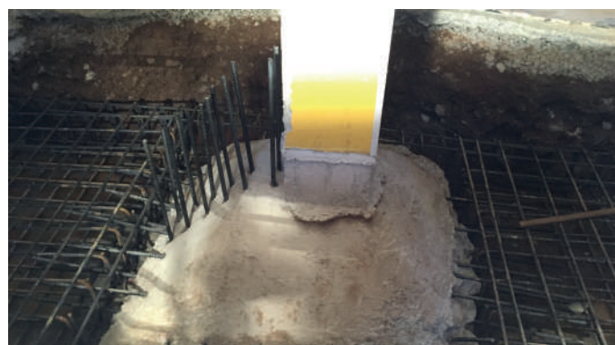
Rinforzo fondazionale dei plinti esistenti
