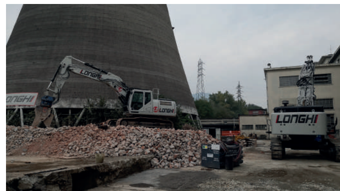
Stato dei luoghi a demolizione ultimata
