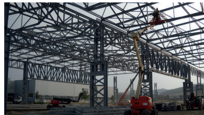
Realizzazione della struttura in carpenteria metallica
