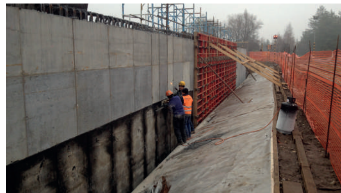
Realizzazione delle pareti verticali in c.a.
