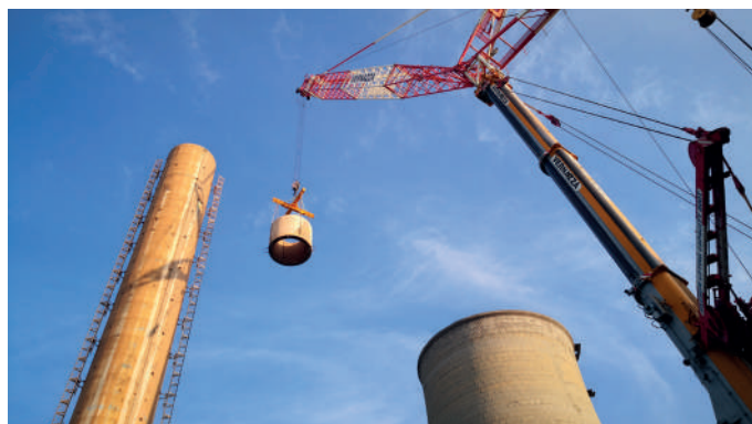
Demolizioni a conchi della ciminiera tramite gru
