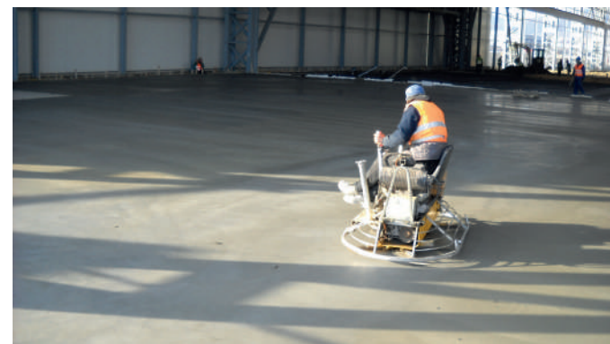
Lisciatura della pavimentazione in calcestruzzo
