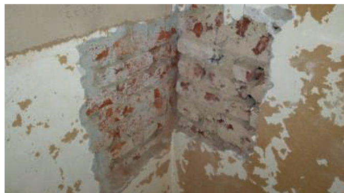
Verifica dell'ammorsamento tra le murature
