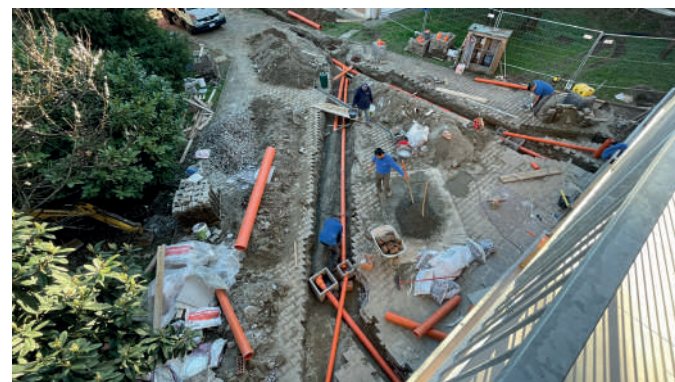
Direzione lavori delle opere edili esterne
