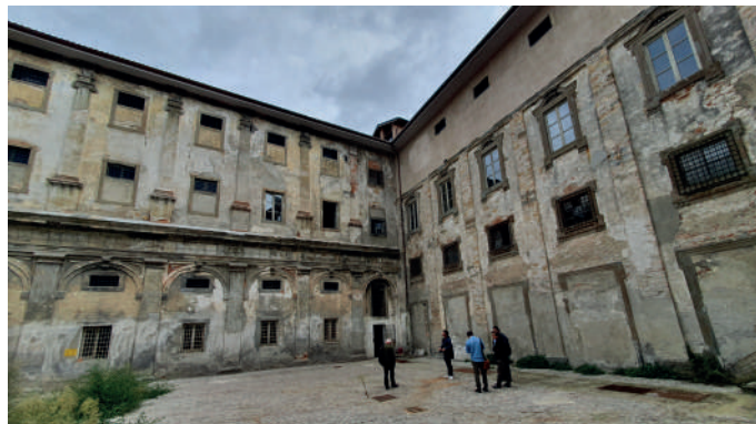
Vista del complesso dal cortile interno
