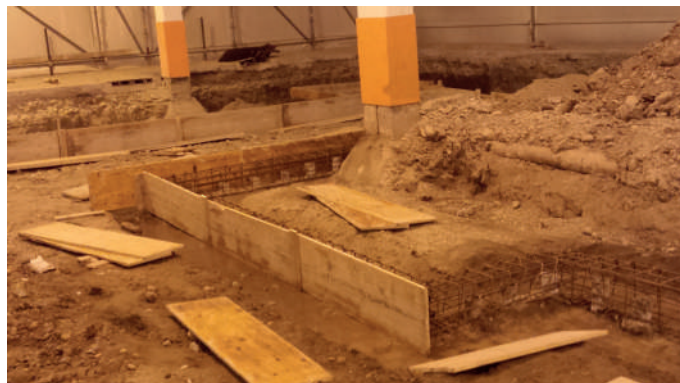
Vista interna del capannone ante intervento
