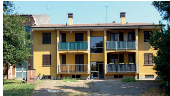
Vista esterna del fabbricato
