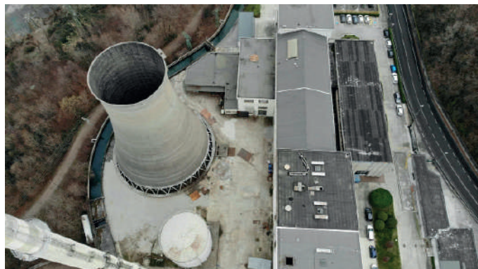
Vista da drone della centrale ante demolizione
