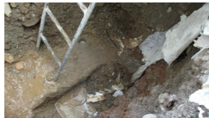
Saggio in fondazione alla base del pilastro
