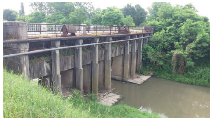
Vista del ponte n.1
