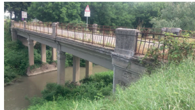
Vista del ponte n.4
