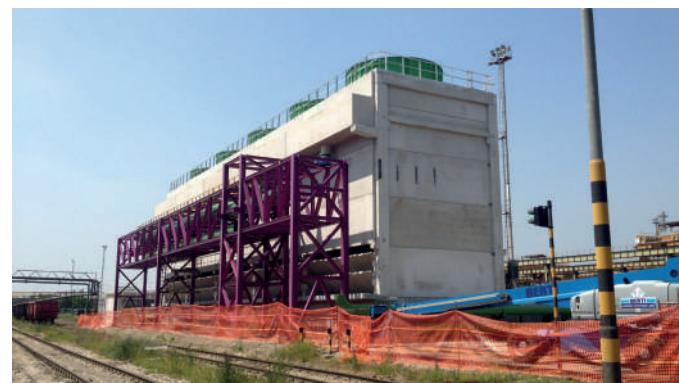
Vista dell'impianto ad intervento ultimato
