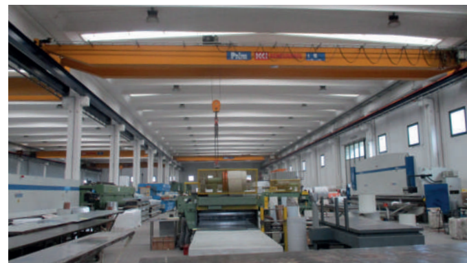
Vista interna dell'immobile
