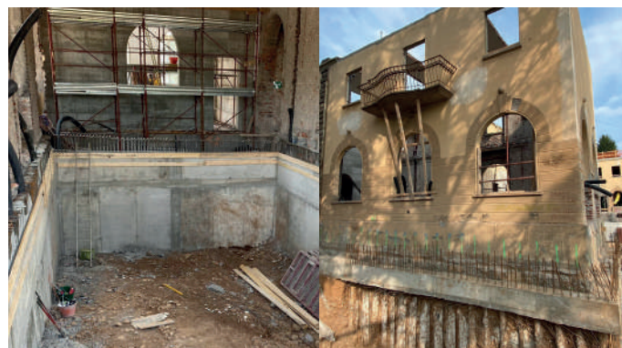
Opere di sottomurazione e di rinforzo fondazionale
