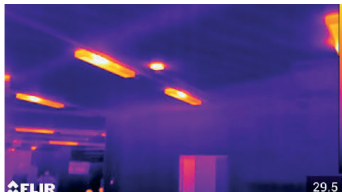
Termocamera per rilievo della struttura portante
