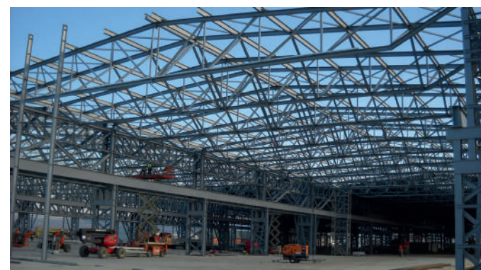
Copertura metallica in travi reticolari
