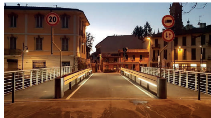
Vista del ponte post intervento
