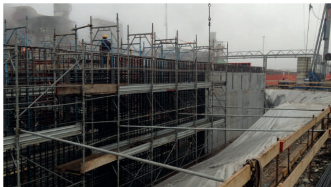
Realizzazione delle pareti verticali in c.a.
