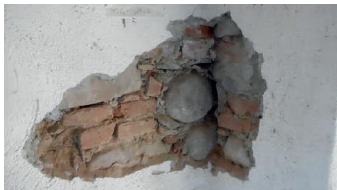
Saggi murari per la valutazione degli ammassamenti
