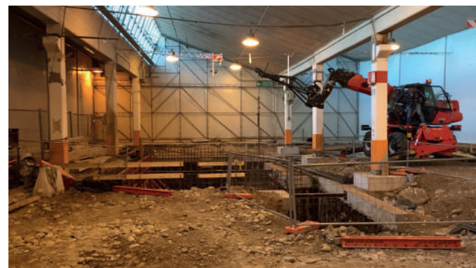
Realizzazione in corso d'opera di vasca interrata
