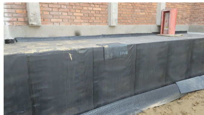
Messa di opera di tessuto non tessuto
