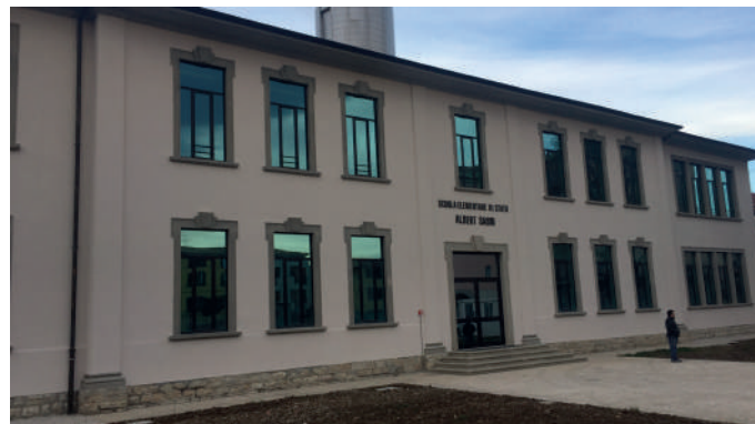
Vista esterna dell'immobile
