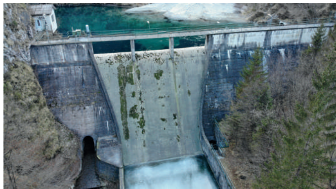
Vista del corpo diga da drone
