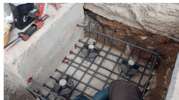
Esecuzione del rinforzo fondazionale del plinto
