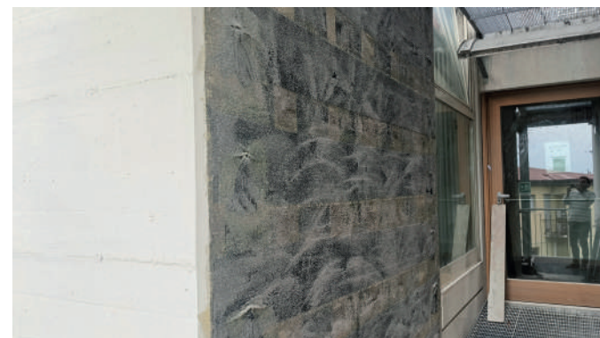
Rinforzo setti in c.a. con CFRP
