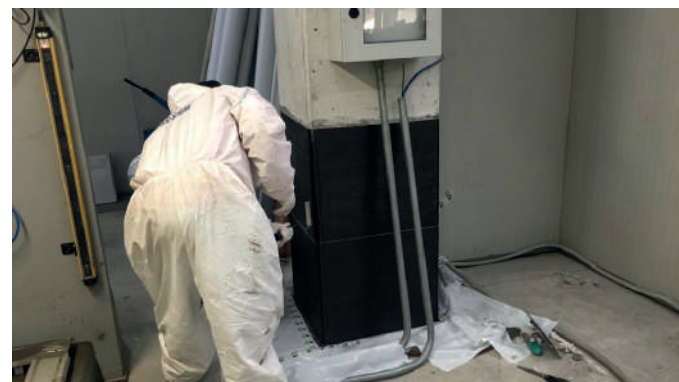
Rinforzo di pilastri prefabbricati esistenti tramite fasciatura
