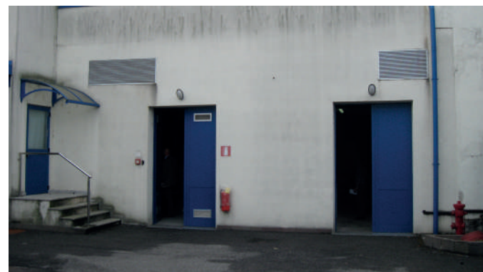
Vista esterna dell'immobile
