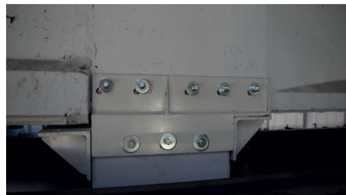
Rinforzo del collegamento tra trave e pilastro
