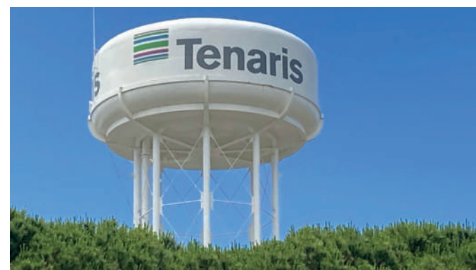
Serbatoio a fine lavori
