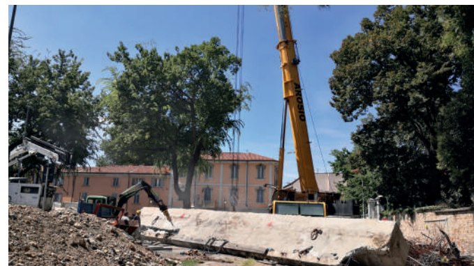
Opere di demolizione del ponte esistente
