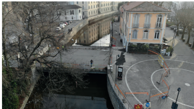
Vista da drone del ponte ante demolizione
