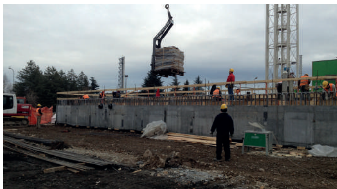
Opere di ultimazione della copertura della vasca
