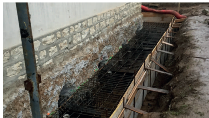
Armatura con cordolo in c.a.
