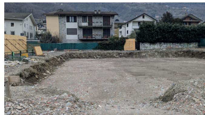
Direzione Lavori dell'attività di scavo
