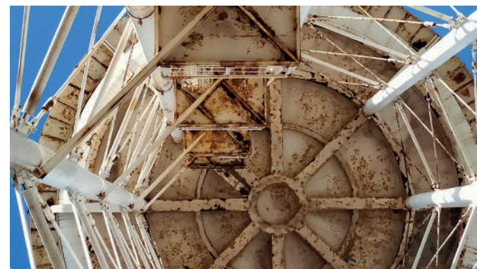
Vista dell'intradosso della cisterna del serbatoio
