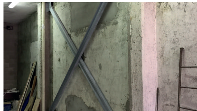
Nuovi controventi di rinforzo
