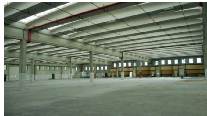
Vista interna del complesso industriale
