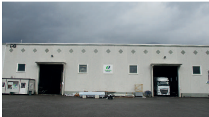
Vista esterna dell'immobile
