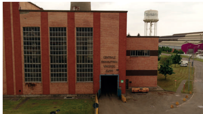
Vista della facciata principale della centrale
