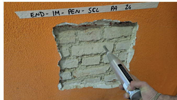
Prova penetrometrica sui giunti di malta
