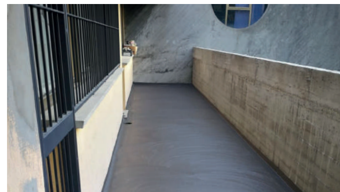
Impermeabilizzazione dei balconi esistenti
