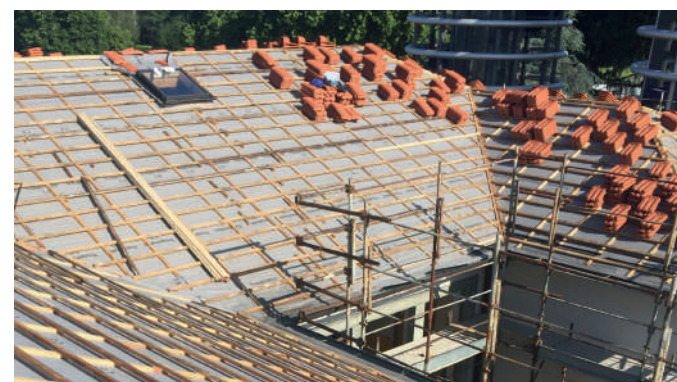
Rifacimento della copertura
