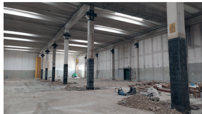
Placcaggio dei pilastri in c.a. esistenti
