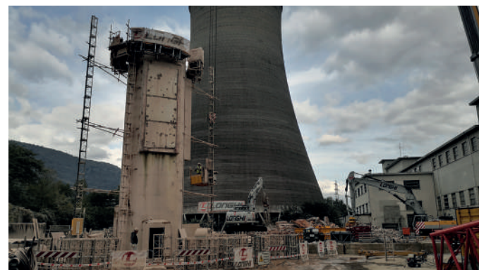
Opere di demolizione della base della ciminiera
